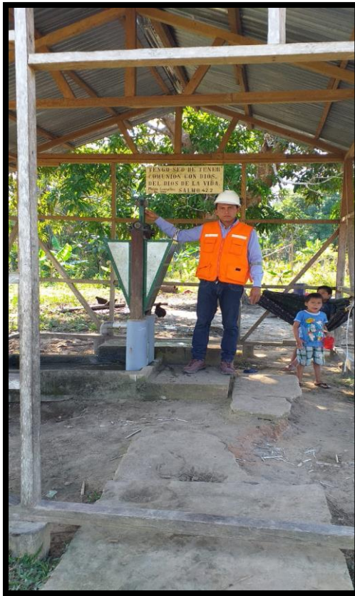
La población se abastece de agua de una fuente de pozo tubular, impulsado mediante una bomba manual
