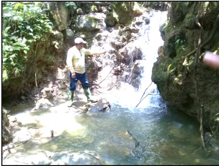
Foto 13 – captación 02 rio Barranco
