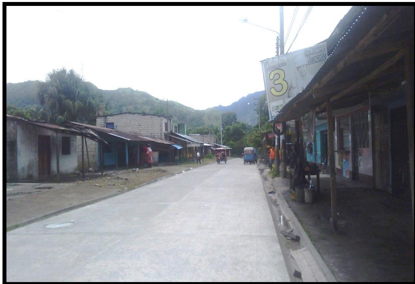
Fig. 08: Ingreso principal a la localidad de Sute San Jorge, las viviendas son de material seminoble, material de madera con cobertura de calamina.
