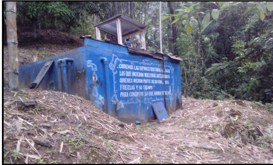
Figura 12: Reservorio de la captación denominado Berlín, abastece de agua a una parte de la población, fue construido en el año de 1976.
