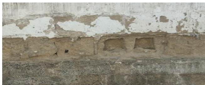
Gráfico 14: Figura de la patología erosión en los muros de albañilería Fuente: Elaboración Propia. (2019).
