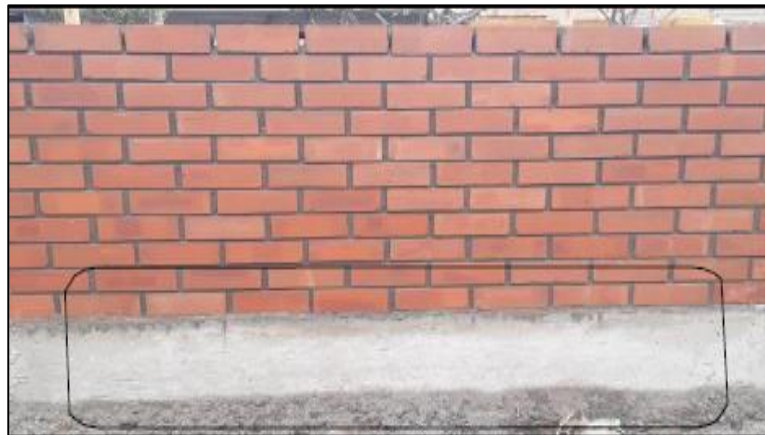
Gráfico 05: Sobrecimiento de un edificación.
