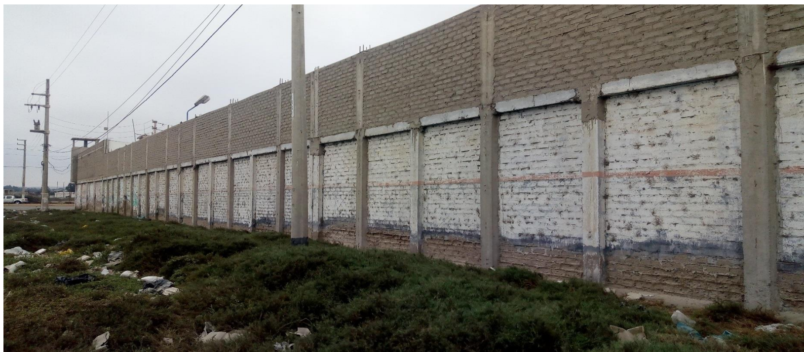
Fotografía 2: Foto panorámica lateral derecho del cerco del almacén ubicado en la urbanización Industrial Gran Trapecio, kilómetro 430, carretera Panamericana Norte, distrito de Chimbote, provincia del Santa, región Ancash.
