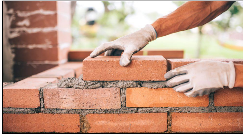
Gráfico 02: Unidades de albañilería asentadas y adheridos con mortero.
