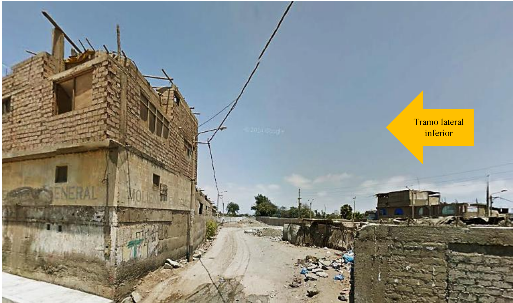
Fotografía 03: Tramo lateral inferior del cerco del Molino Santo Domingo del Asentamiento Humano Santo Domingo, distrito de Chimbote, provincia del Santa, región Áncash.
