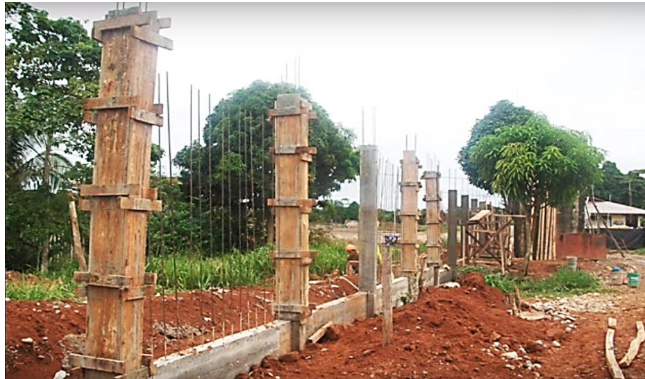
Figura 03: Detalle de la construcción de un cerco perimétrico con sus elementos de confinamiento.
