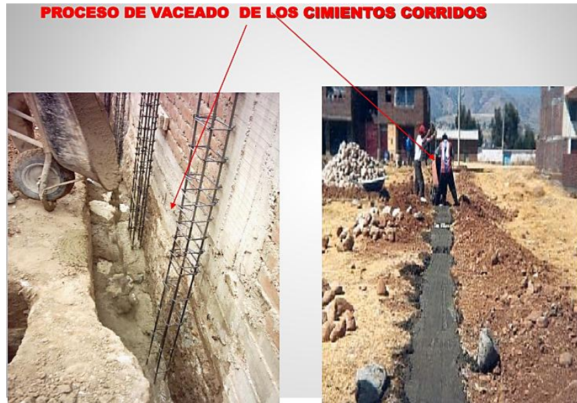
Figura 10: Detalle del proceso de vaciado de los cimientos corridos.
