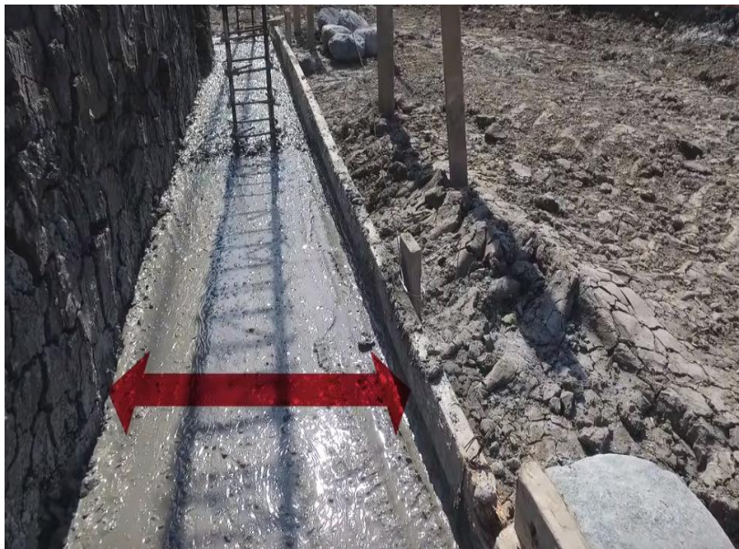
Figura 21: Detalle del vaciado del cimiento corrido con concreto ciclópeo con proporción 1:10 + 30% P.G.
