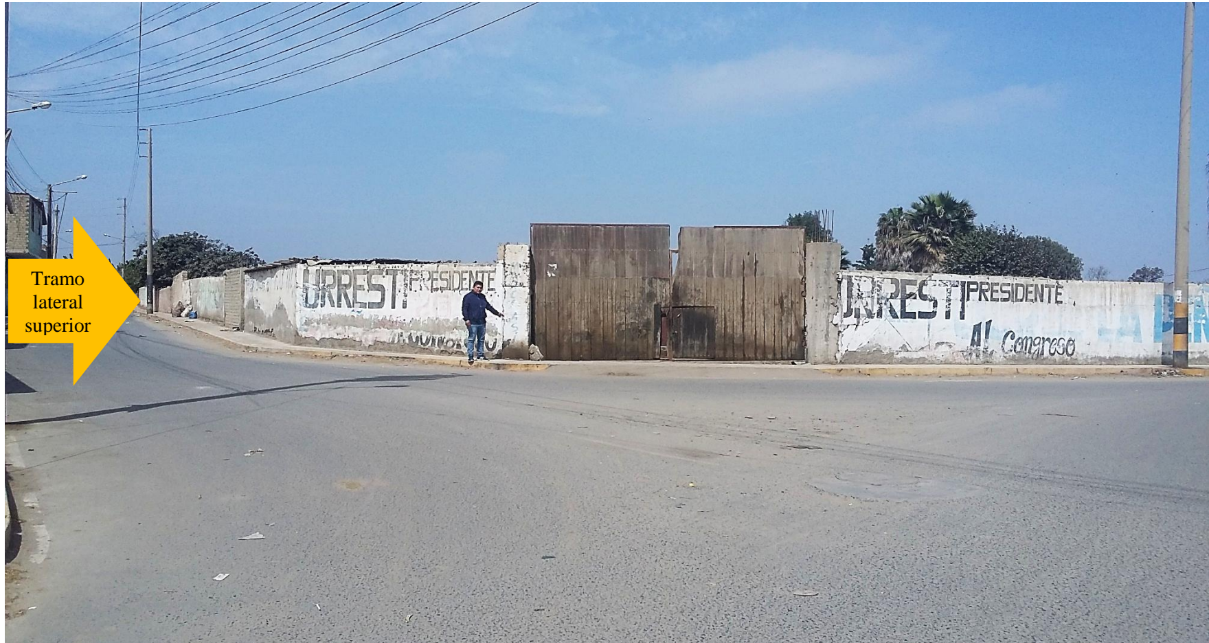
Fotografía 01: Tramo lateral superior evaluado del cerco del Molino Santo Domingo del Asentamiento Humano Santo Domingo, distrito de Chimbote, provincia del Santa, región Áncash.
