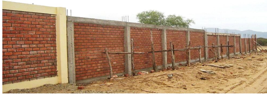
Figura 29: Detalle del cerco perimétrico recién construido con sus elementos de confinamiento y albañilería cumpliendo las propiedades de seguridad, funcionalidad y estética.
