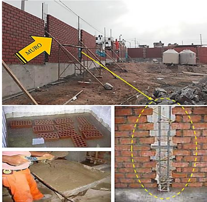
Figura 11: Detalle de muros de ladrillo tipo caravista del cerco perimétrico.
