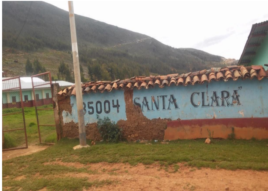
Figura 05: Detalle del cerco construido con adobe y barro de la Institución Educativa N°85004 del Centro Poblado de Santa Clara, distrito de Huayllabamba, provincia de Sihuas, región Áncash.
