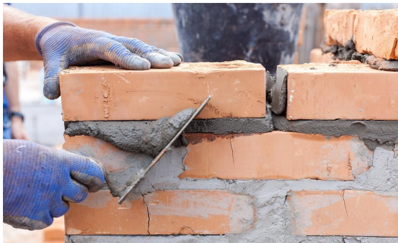
Figura 14: Detalle del uso del mortero en el asentado del ladrillo.
