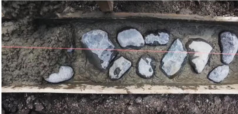
Figura 20: Detalle del vaciado del cimiento corrido con concreto ciclópeo con proporción 1:10 + 30% P.G.
