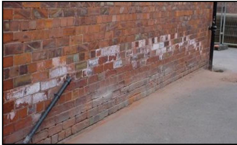
Gráfico 12. Eflorescencia en muros.
