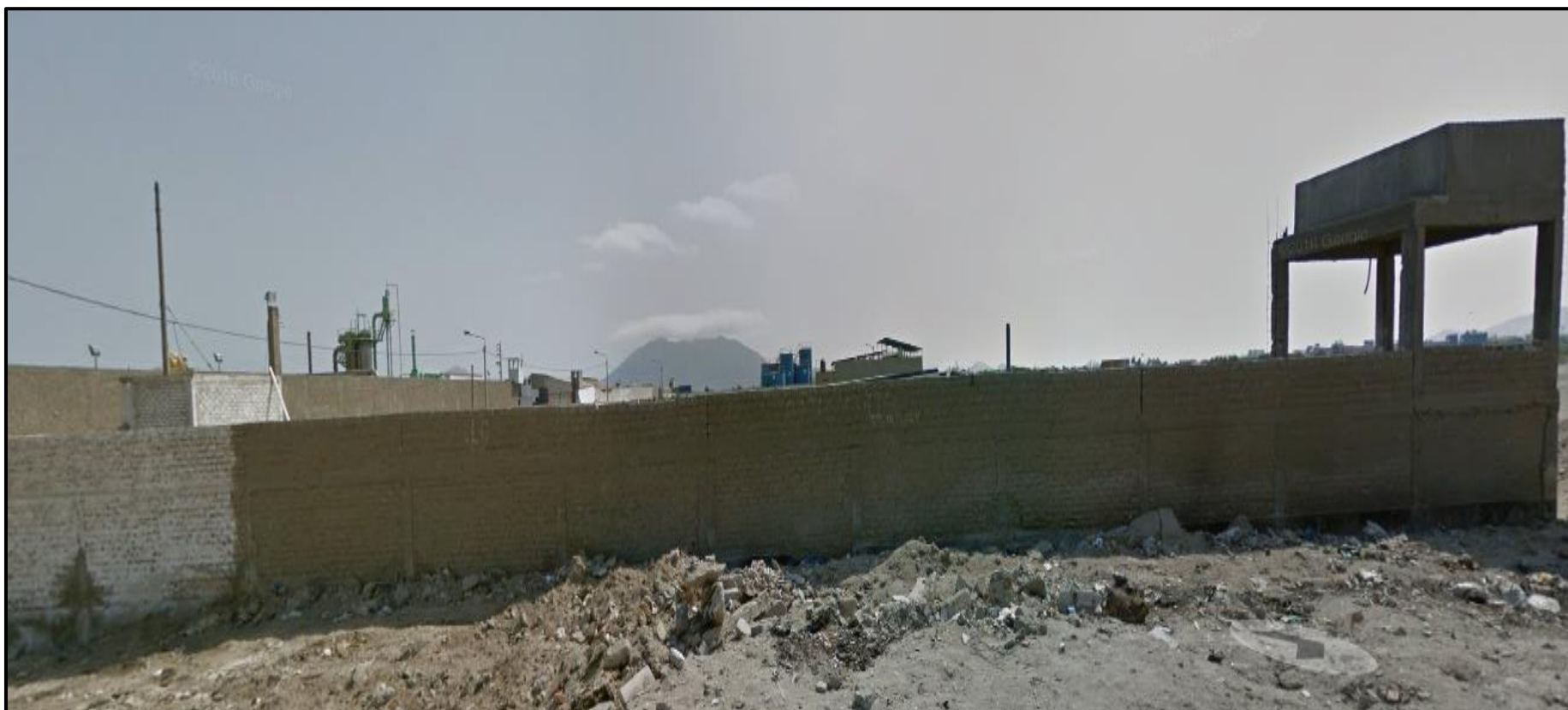
Imagen 04: Foto lateral del tramo 7-8 del cerco perimétrico del almacén.
