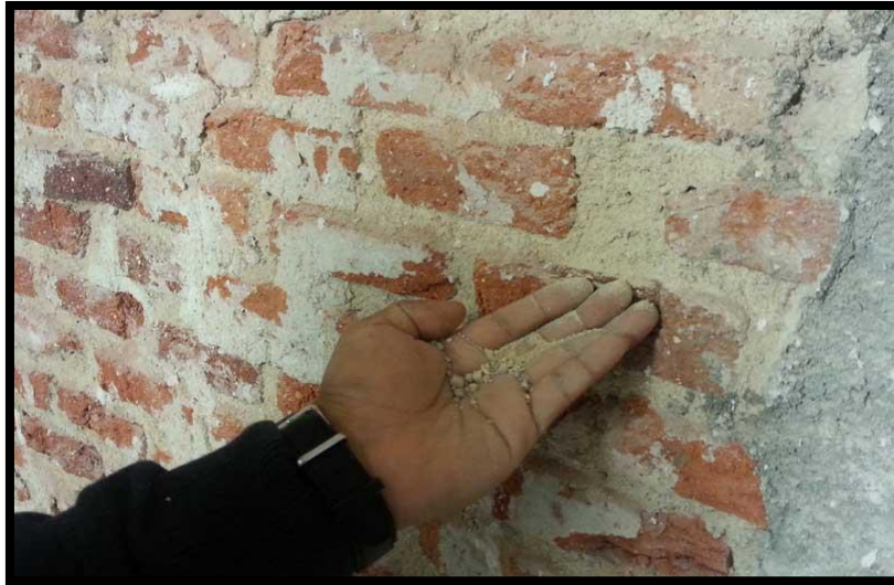
Gráfico 8. Desintegración en muro.
