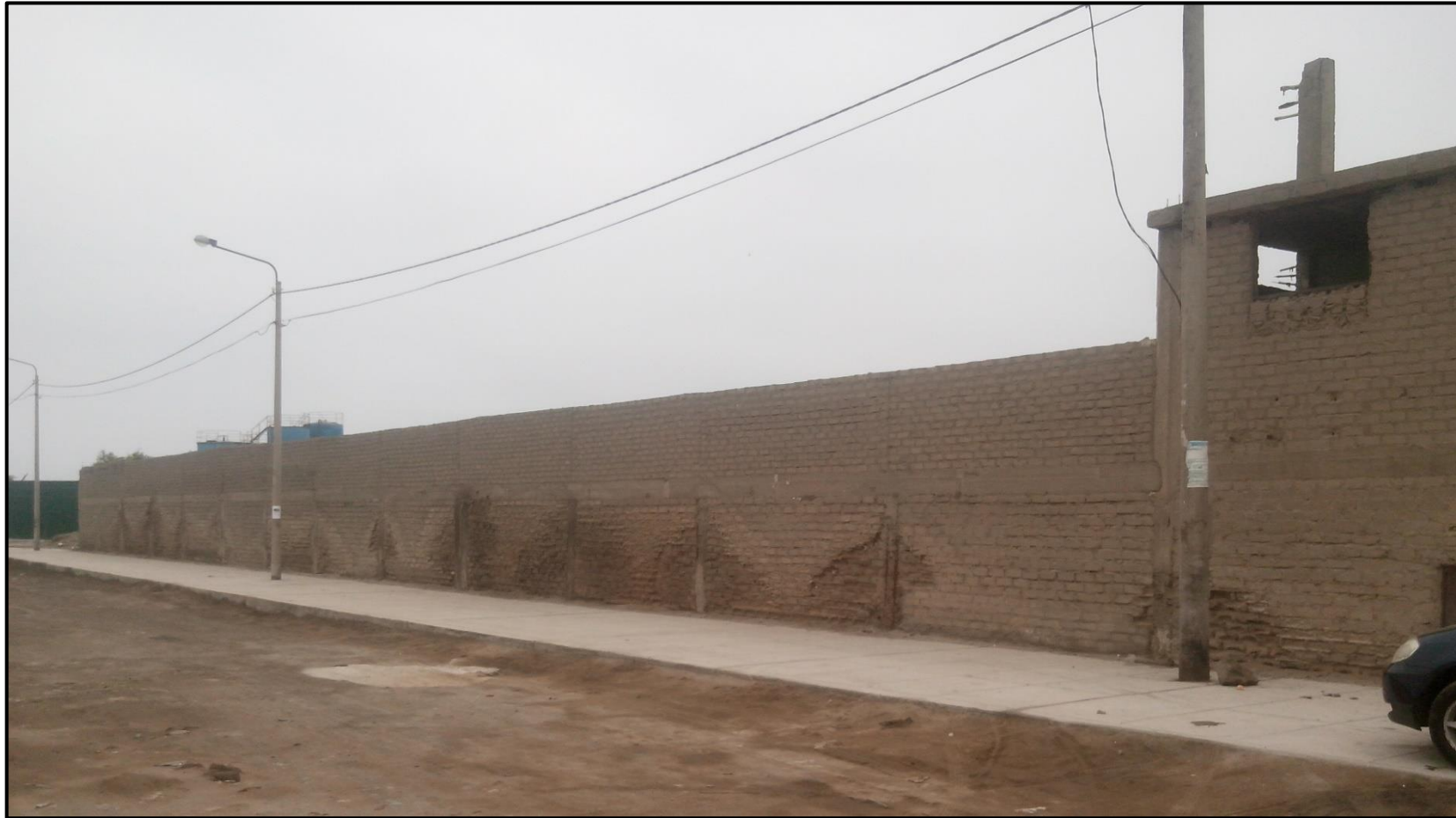
Imagen 01: Foto lateral del tramo 1-2 del cerco perimétrico del almacén.
