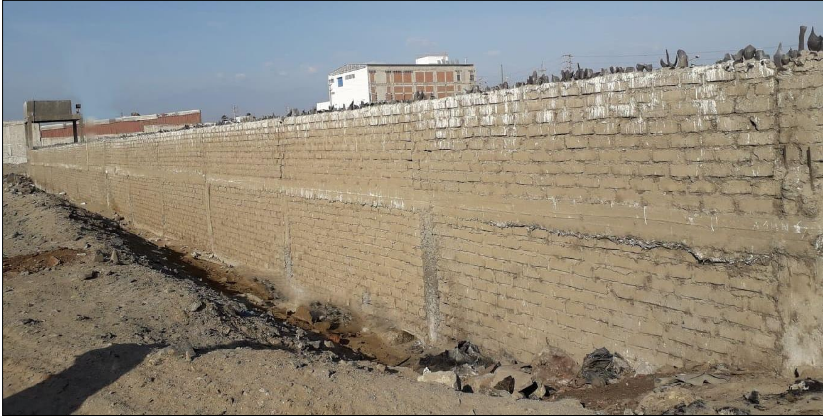
Imagen 03: Foto lateral del tramo 5-6 del cerco perimétrico del almacén.
