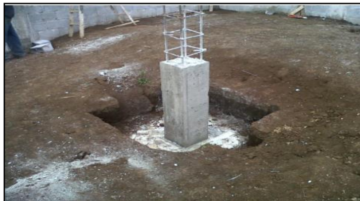
Gráfico 3. Columna de concreto armado.
