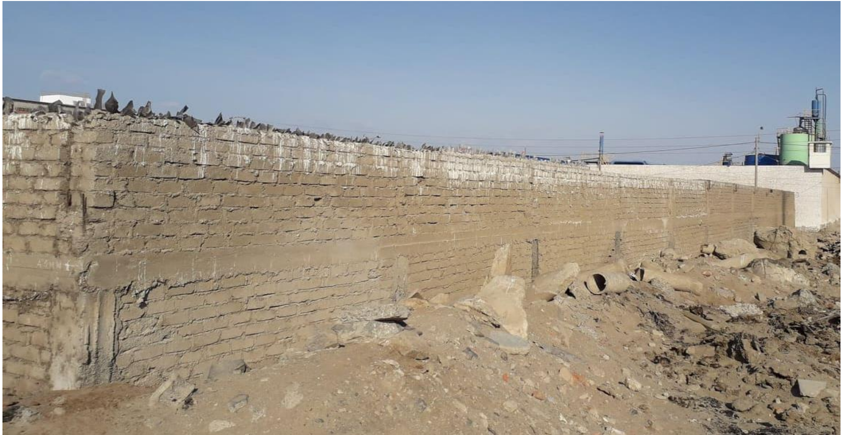
Imagen 02: Foto lateral del tramo 3-4 del cerco perimétrico del almacén.
