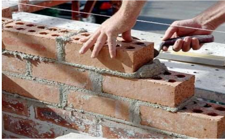
Gráfico 13: muros de mampostería ladrillo.
