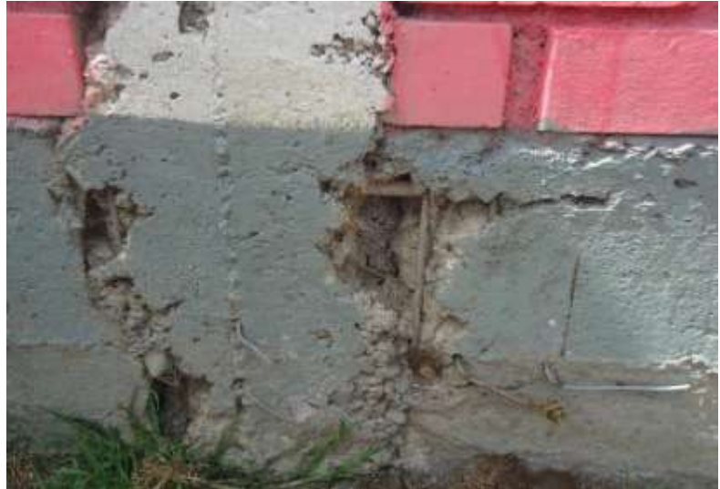
Gráfico 27: columna afectada por la corrosión.
