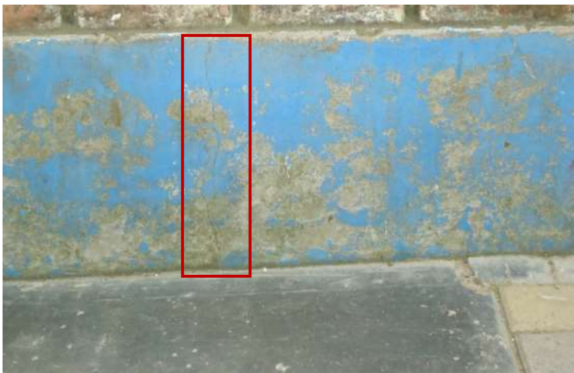
Gráfico 95: sobrecimiento afectadas por fisuras en la unidad de muestra 3.
