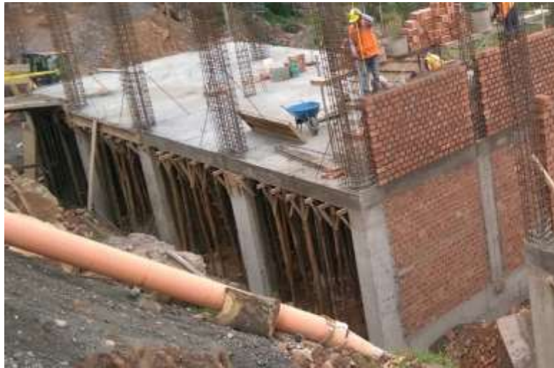
Gráfico 5: elementos de una edificación albañilería confinada.
