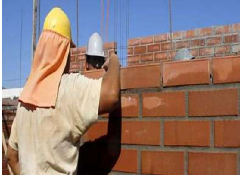
Gráfico 6: construcción de muro.
