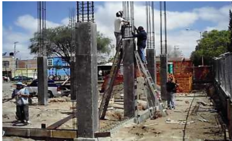
Gráfico 16: columnas de un cerco
