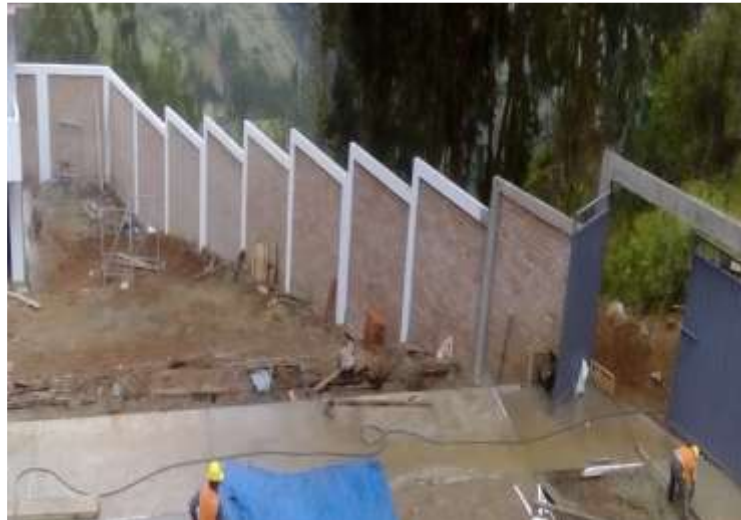
Gráfico 18: Viga Confinada de Concreto Armado en Cerco.
