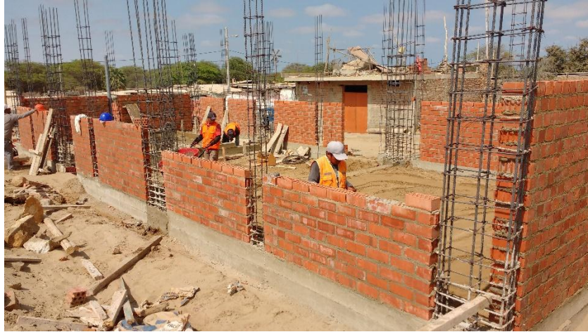
Figura 04. Imagen de muro. Fuente: Propia
