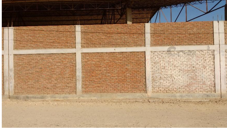
Figura 03. Imagen de estructura de albañilería confinada. Fuente: Propia
