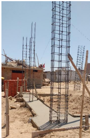
Figura 05. Imagen de columna. Fuente: Propia
