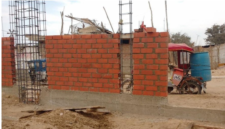
Figura 07. Imagen de sobrecimiento. Fuente: Propia
