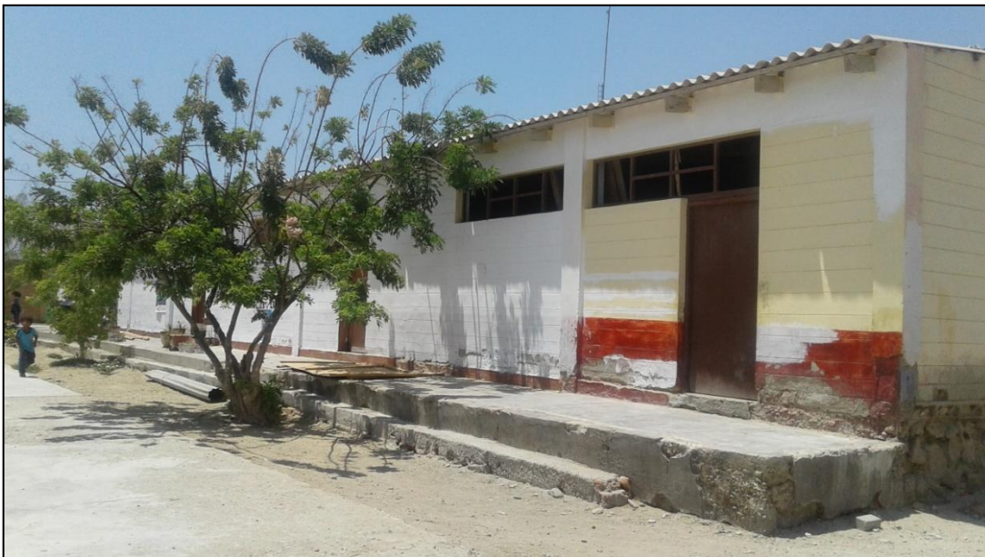
Fotografía 2: Parte frontal (lado sur) de pabellón 01.
