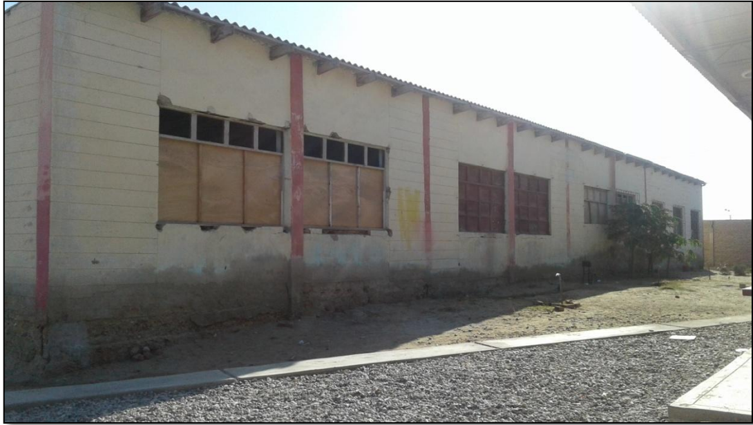
Fotografía 5: Parte posterior (lado norte) de pabellón 01.
