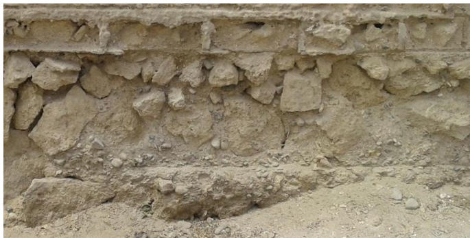
Figura 2: Erosión física. Fuente: Autor
