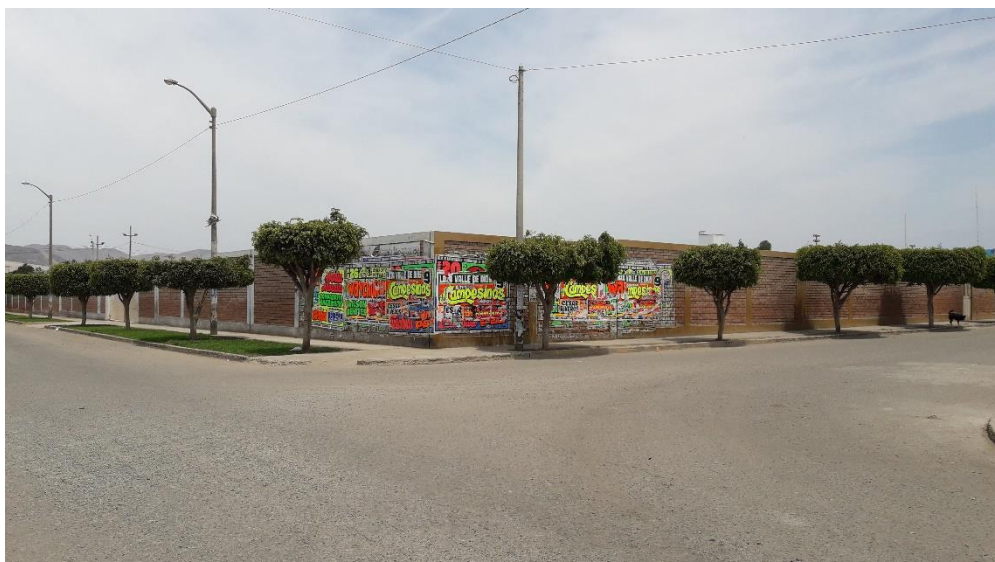
Foto 02: vista del cerco perimétrico del lado derecho del centro de salud Puente Chao.
