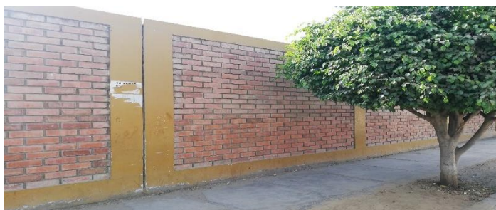
Gráfico 2: Cerco perimétrico del Centro de Salud. Fuente: Elaboración propia 2019.
