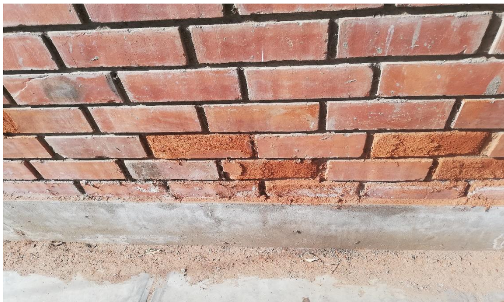
Foto 04: vista de la muestra 23 donde se identifica la erosión en los ladrillos del cerco perimétrico del centro de salud puente chao.
