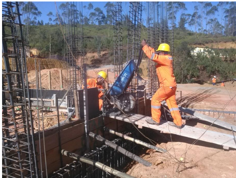
Gráfico 11: Proceso constructivo de los elementos de concreto armado.
