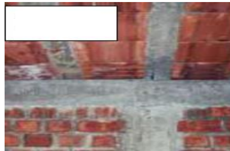
Gráfico 8: Elementos de confinamiento en Albañilería
