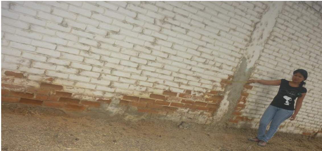
Gráfico 103: Patología Erosión Física en muro (patología más frecuente en todas las Unidades de Muestra)
