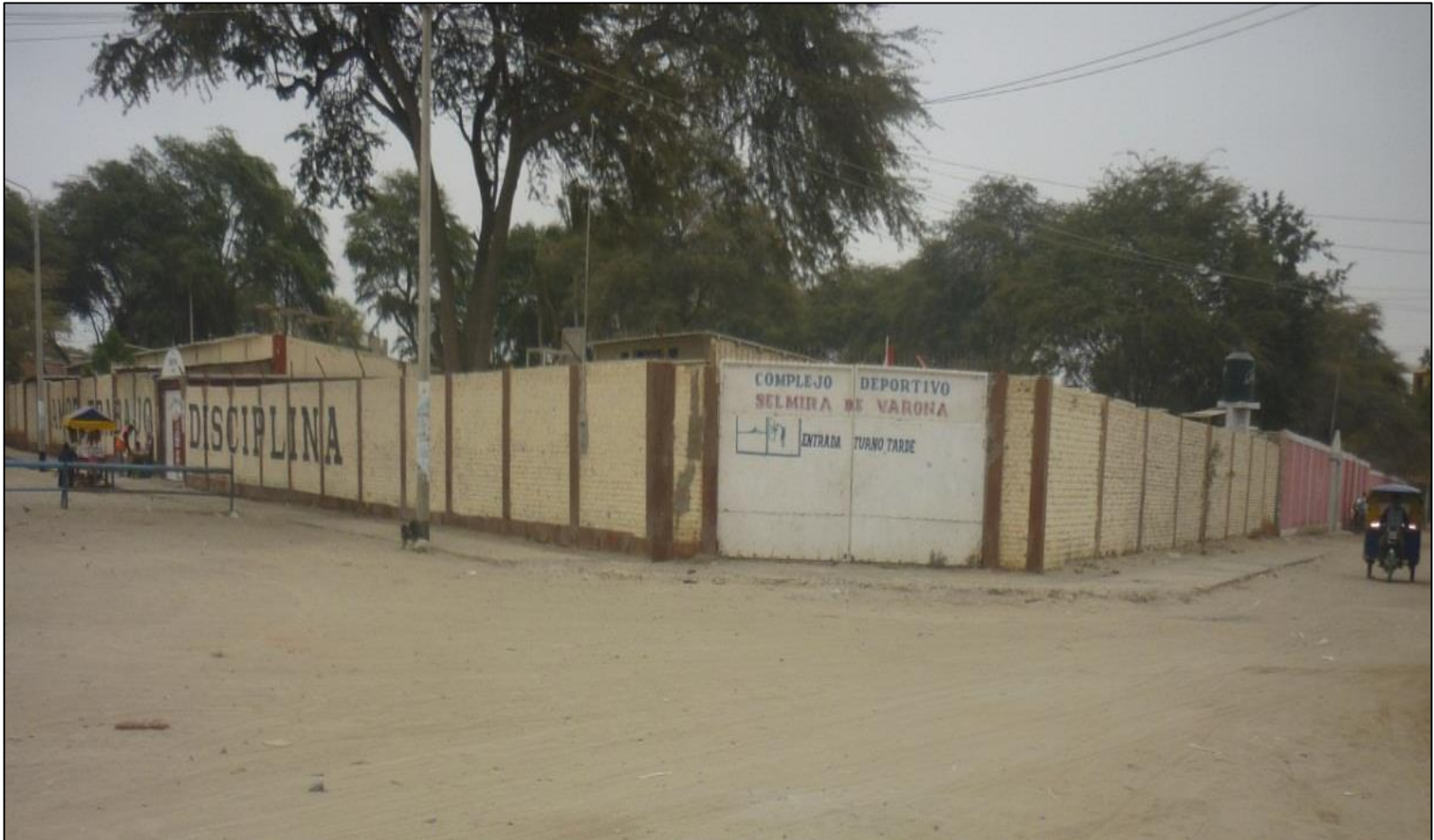
Gráfico 95: Vista Panorámica exterior del cerco perimétrico de la Institución Educativa 14009 Selmira de Varona-Piura.
