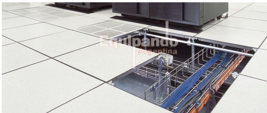
Gráfico Nro. 15: Forma visual del piso técnico
