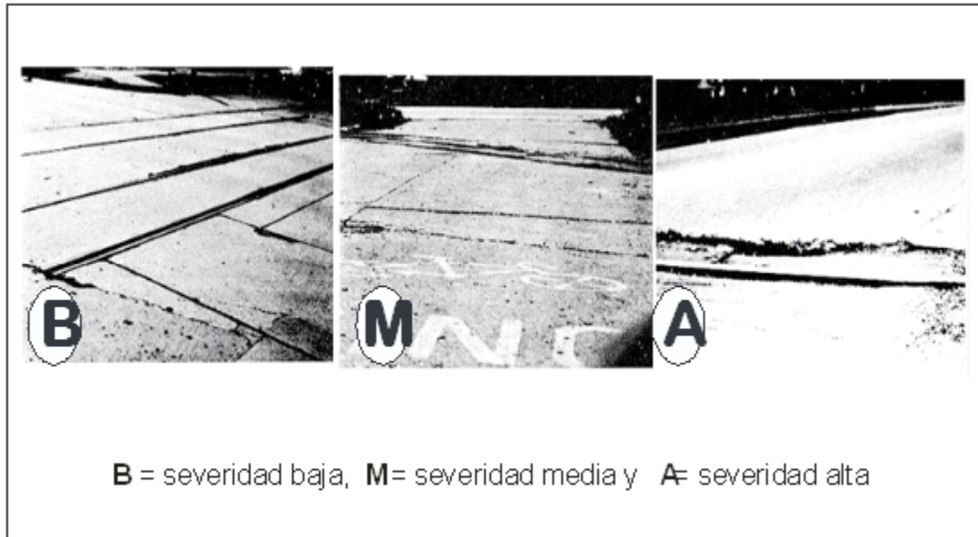
Figura 2.18: Cruce de Ferrocarril
