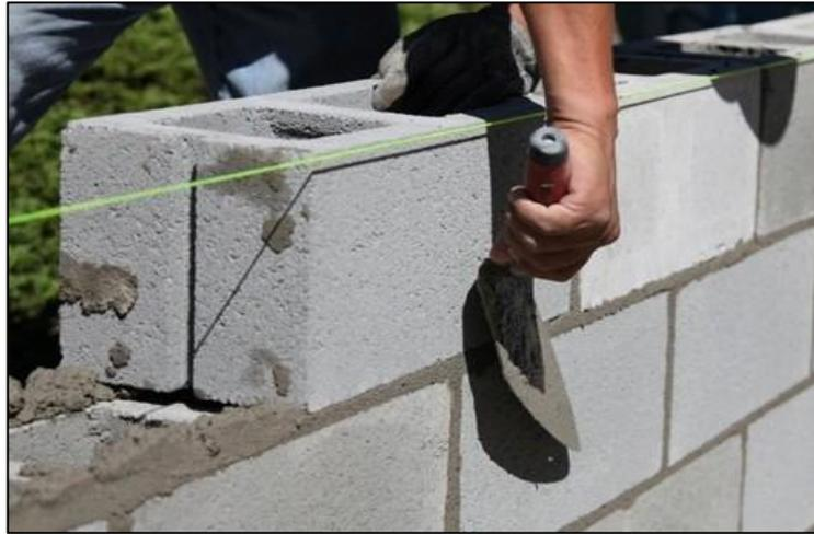
*Figura 14.* Construcción de muro con bloques de concreto.
