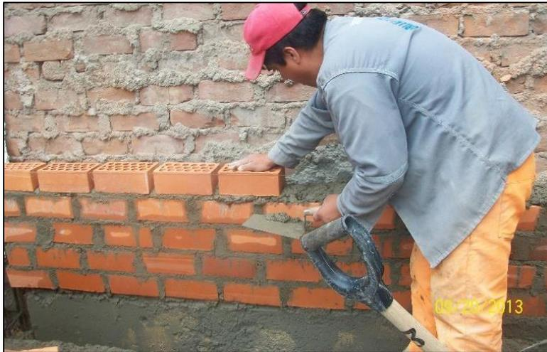
*Figura 4.* Construcción de muro de albañilería con ladrillos de arcilla.
