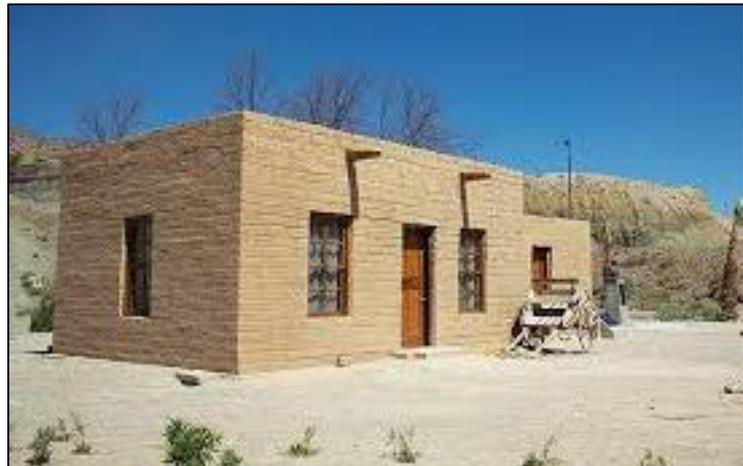
*Figura 1.* Vivienda con muros de albañilería simple.
