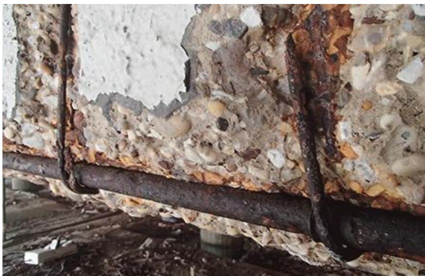
Figura 22. Columna deteriorada por la corrosión del acero.
