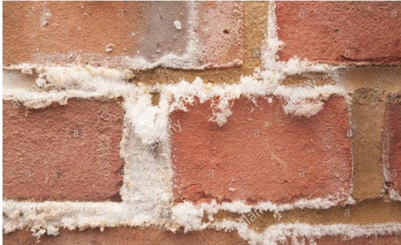
*Figura 21.* Muro con presencia de eflorescencia en las juntas de mortero provenientes del propio material.
