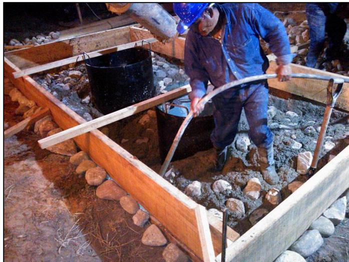
*Figura 12.* Vaciado de concreto ciclópeo para base de poste de línea eléctrica
