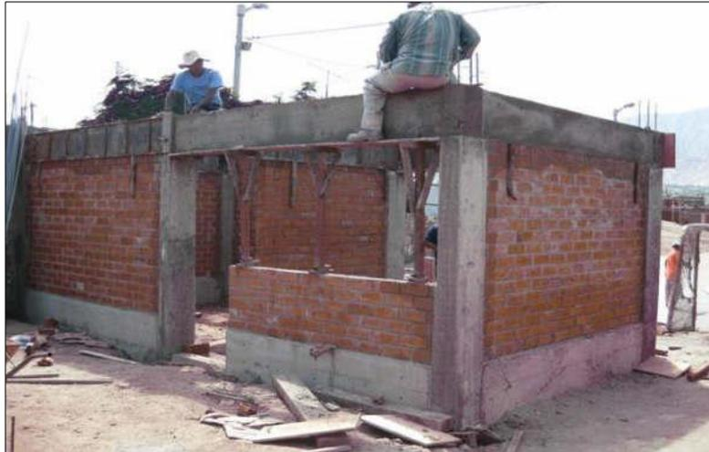
*Figura 3.* Proceso constructivo mediante albañilería confinada.
