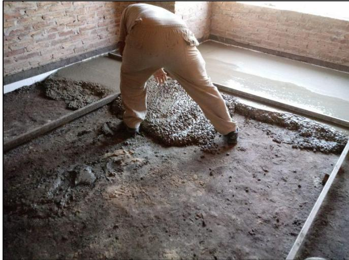
*Figura 10.* Realización de contrapiso con concreto simple.
