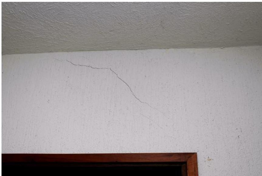
Figura 19. Aparición de fisura diagonal en el revestimiento del muro resultado de movimientos sísmicos o sobrecarga.
