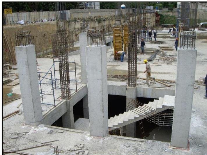
*Figura 11.* Elementos estructurales de concreto armado.
