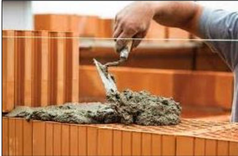
*Figura 15.* Colocación del mortero para el asentado del ladrillo de un muro de albañilería.
