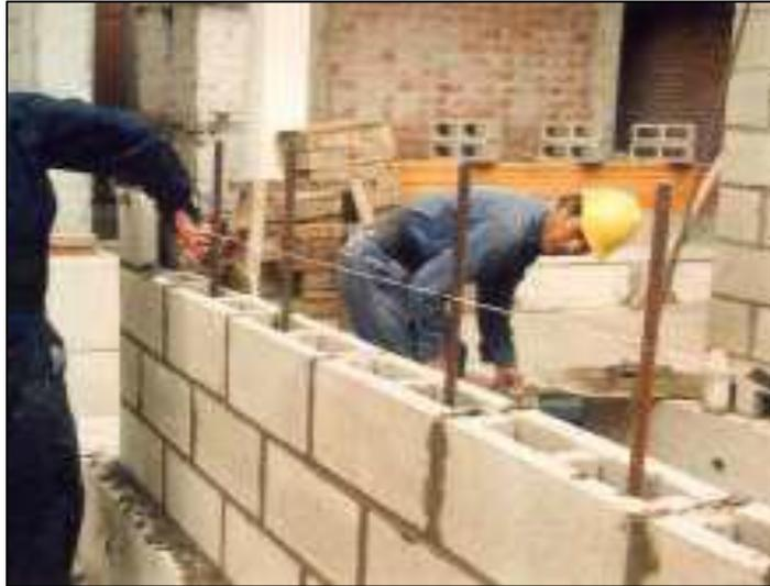
*Figura 2.* Construcción de muro de albañilería reforzada con bloques de concreto.
