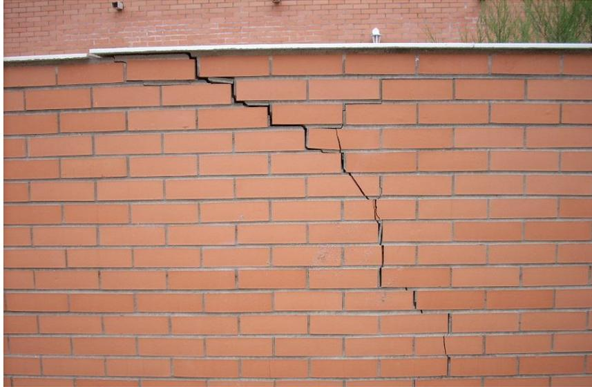
*Figura 18.* Grieta en muro producto de la deformación del apoyo de su cimiento y por carencia de elemento de confinamiento.
