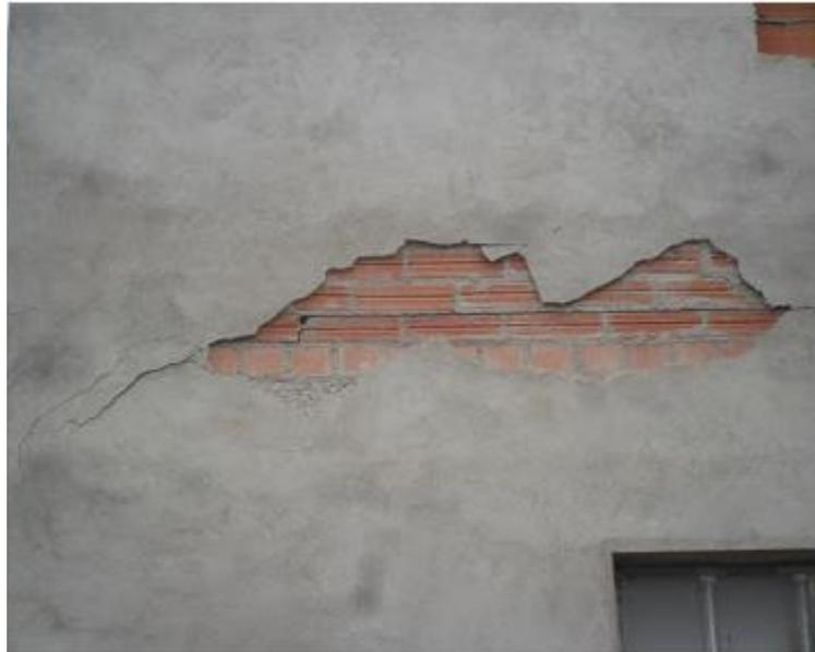
Figura 20. Desprendimiento en la fachada por falla en la adherencia.
