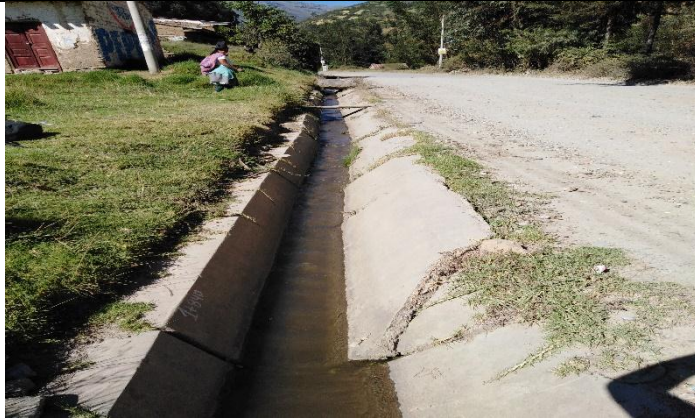
Presencia de patologías: Fisura, grieta, fractura y erosión
