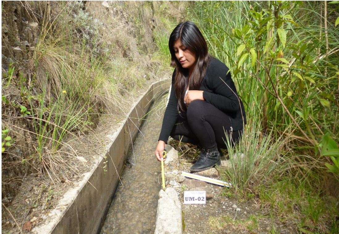
Midiendo la pérdida de material por impacto en la UM-02
