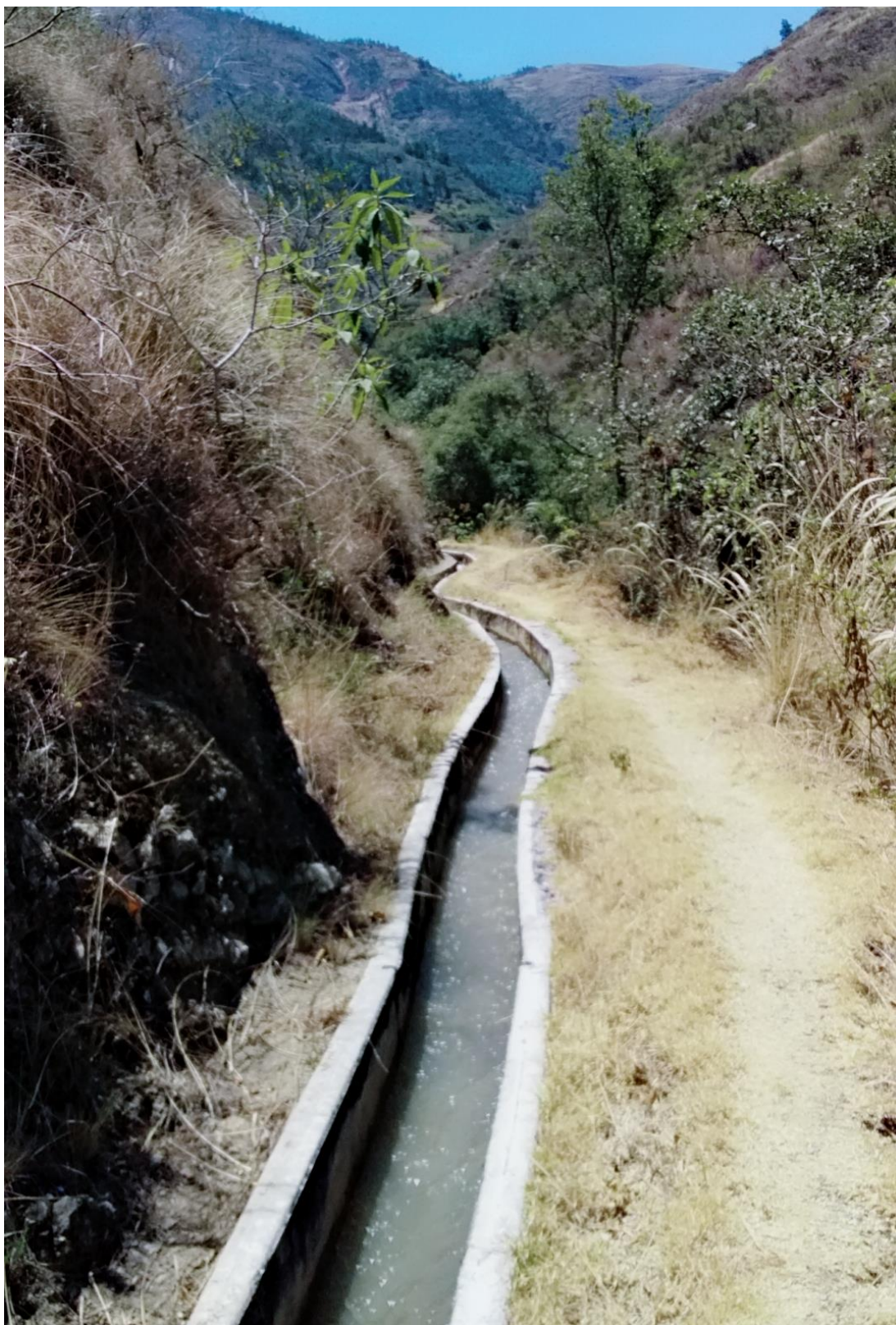
Vista panorámica del canal riego Monte Ruri
