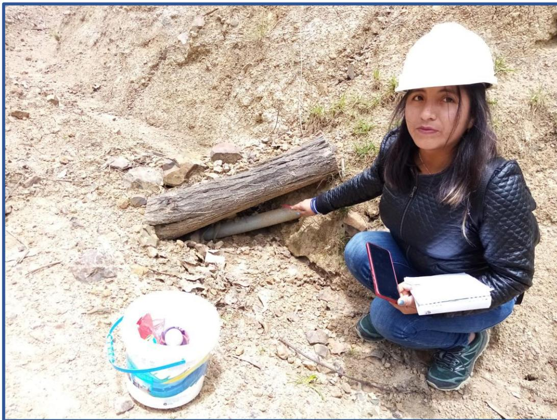
**Fotografía N°09:** *Tubería expuesta en la línea de conducción al lado de la carretera.*
