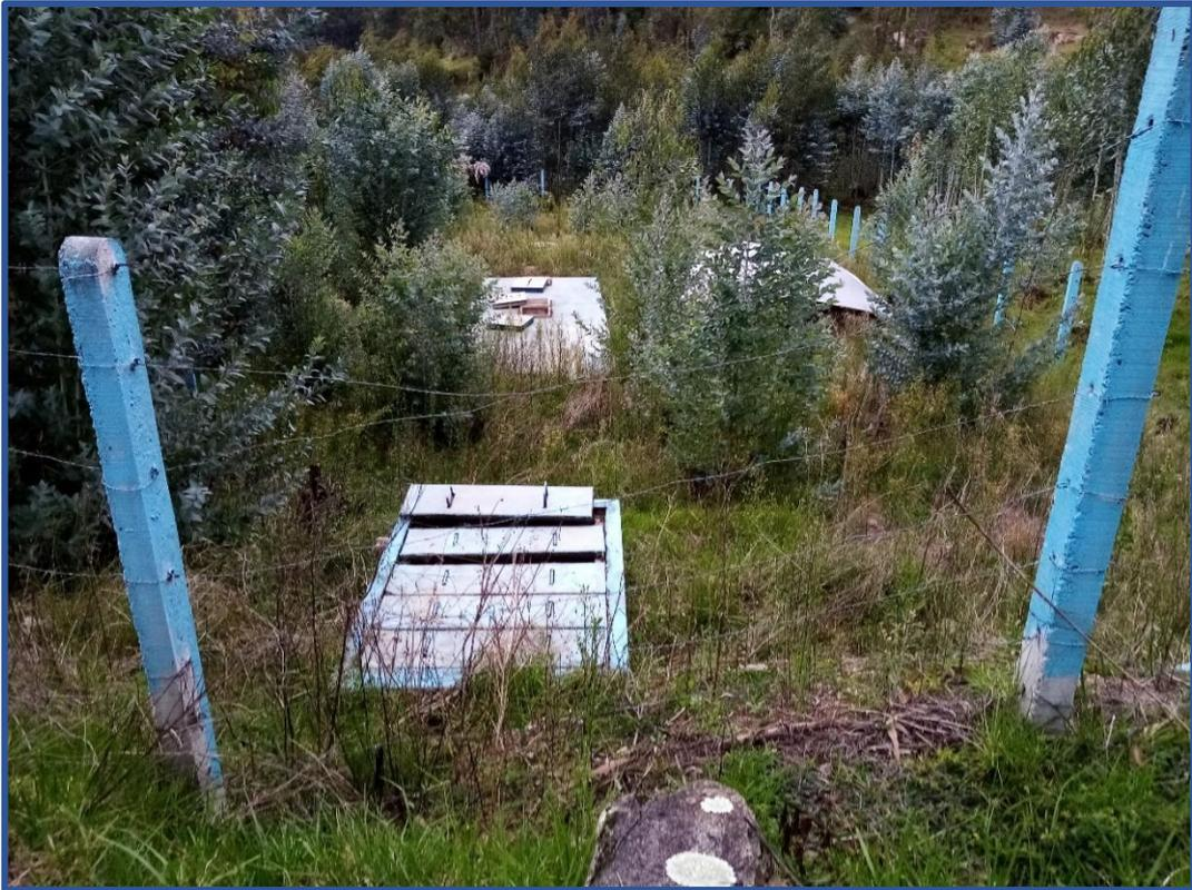
**Fotografía N°25:** *Cámara de rejas presenta descascaramiento de la pintura.*
