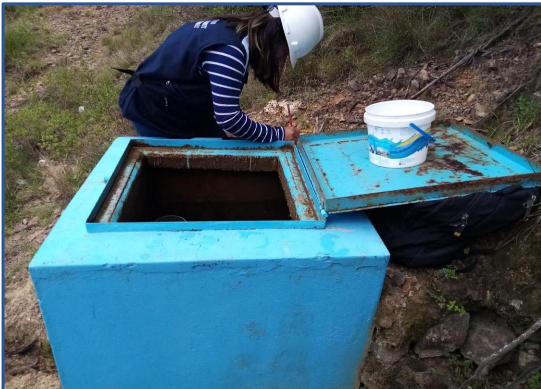
**Fotografía N°13:** *Cámara rompe presión T6 presencia de fisuras leves.*
