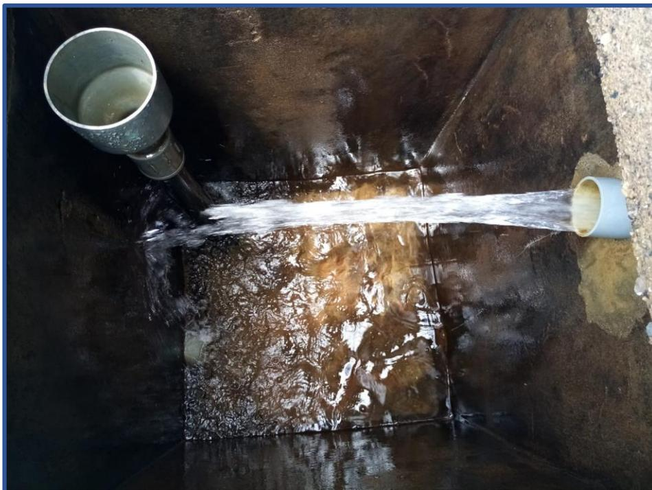
**Fotografía N°15:** *Cámara rompe presión T6 requiere tarrajeo interno.*
