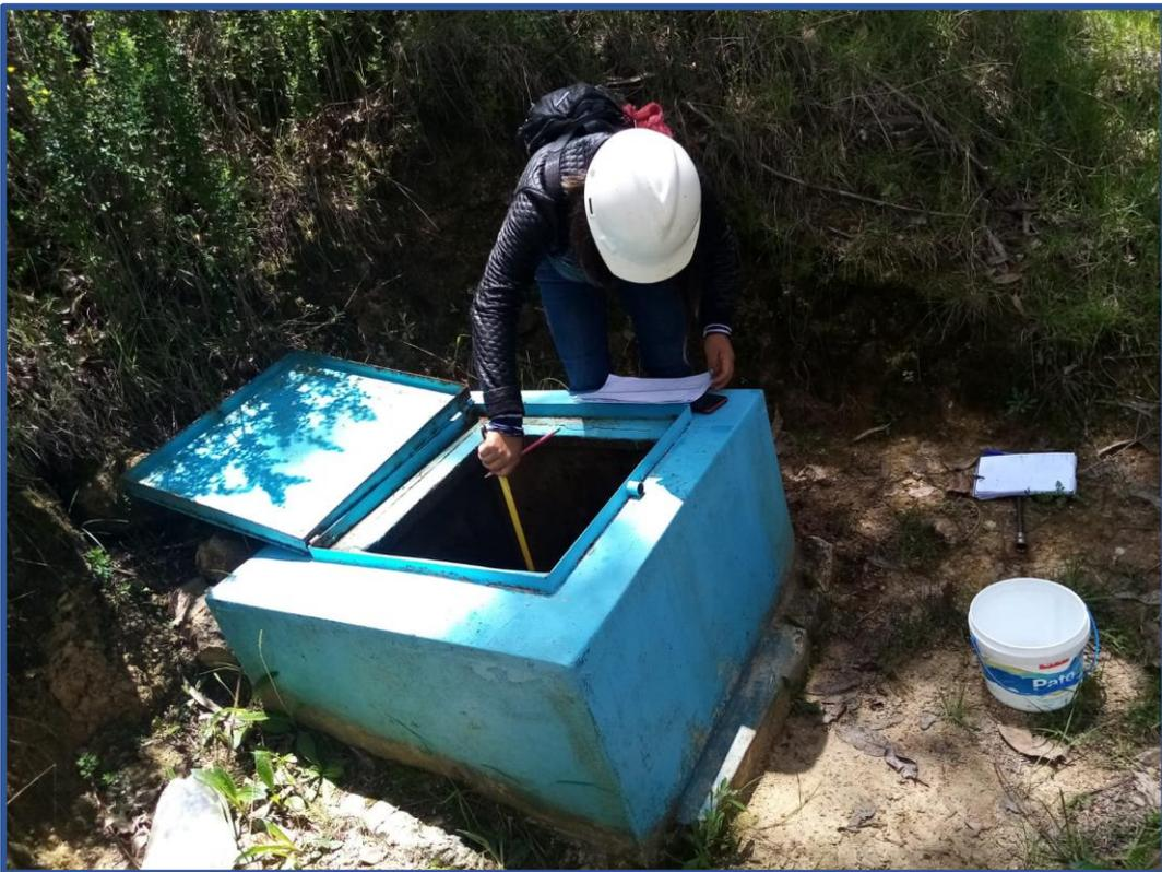
**Fotografía N°12:** *Cámara rompe presión T6 presencia de oxido en la tapa.*
