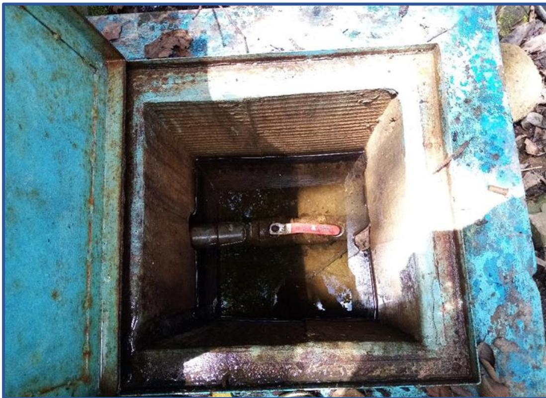
**Fotografía N°08:** *Tubería expuesta en la línea de conducción.*
