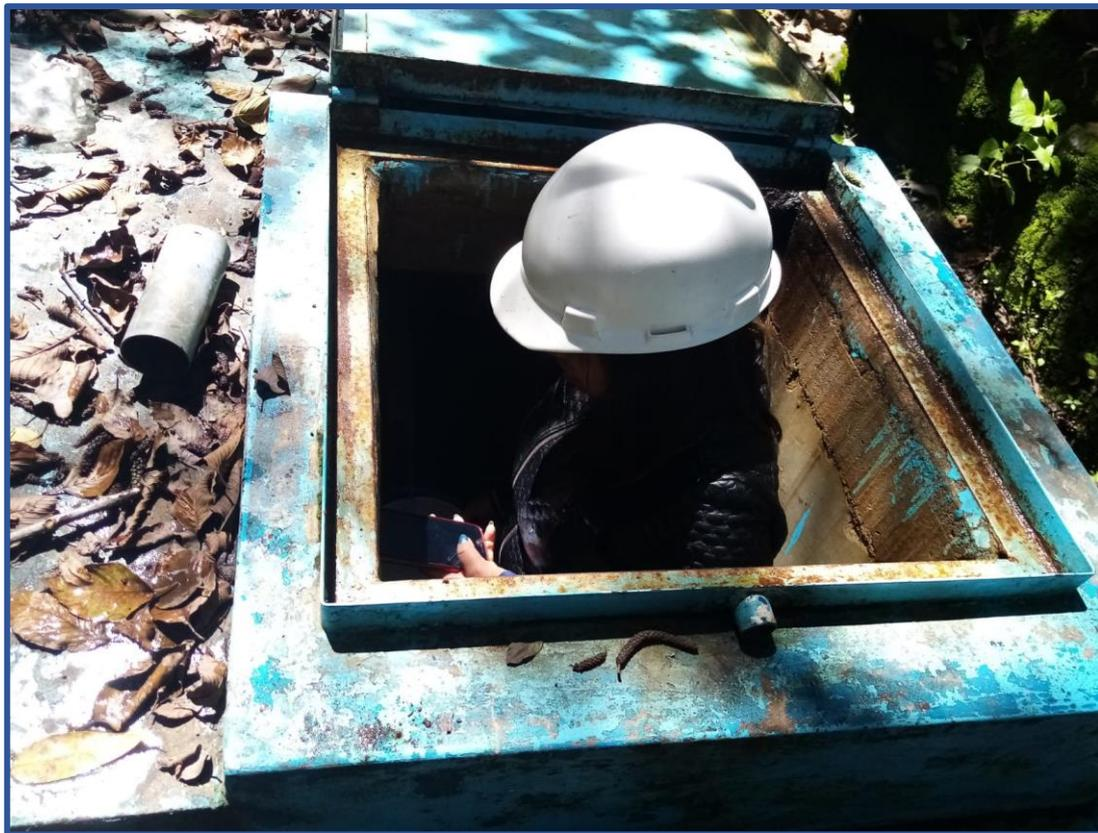
**Fotografía N°07:** *En la caja de válvula se observa agua.*
