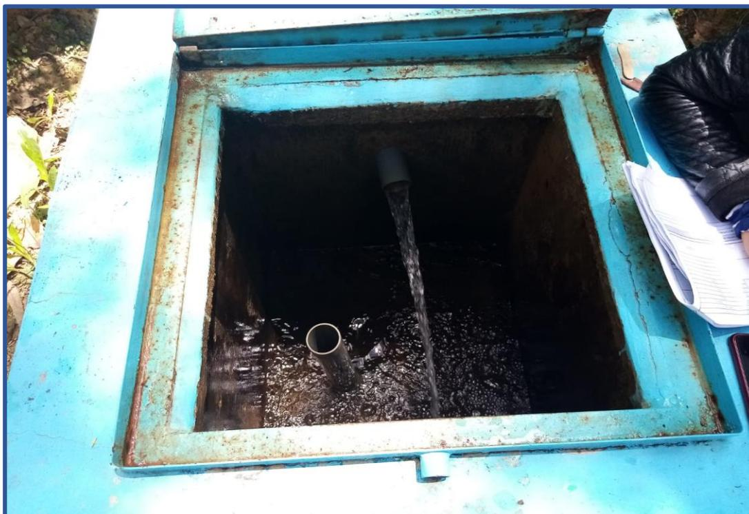
**Fotografía N°14:** *Cámara rompe presión T6 no tiene canastilla y codo en la tubería de entrada.*
