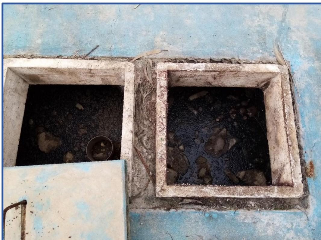
**Fotografía N°30:** *Las aguas negras en colmatación por la falta de O y M.*
