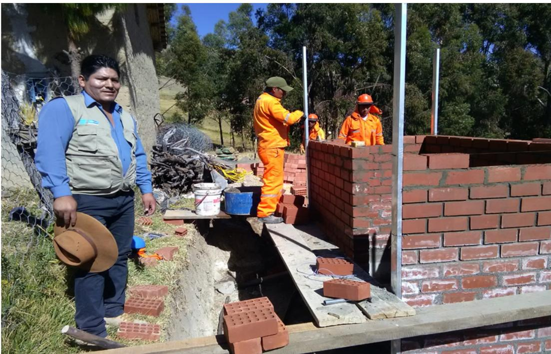
Figura 2.15: Proceso constructivo de una UBS (Colocación de los ladrillos para la construcción de los muros).
