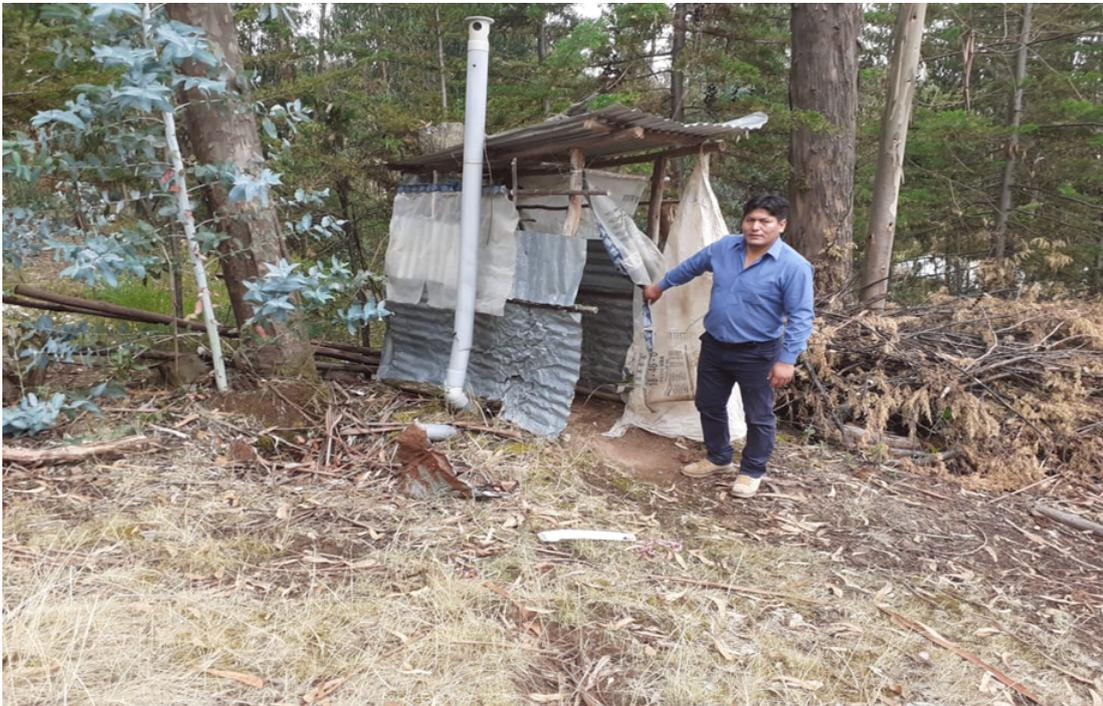
Figura 2.3: Baño de hoyo seco ventilado.
