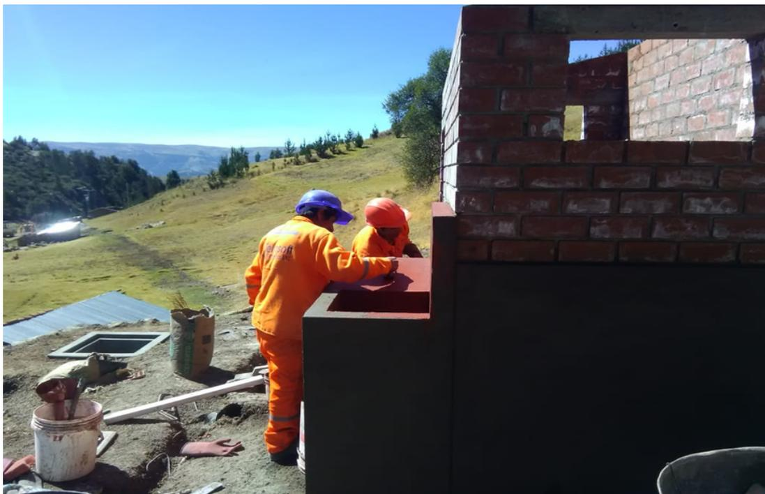
Figura 2.16: Proceso constructivo de una UBS(Tarrajeo de la pared y construcción del lavadero).
