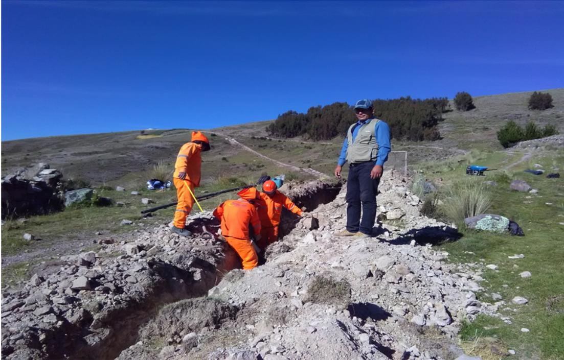
Figura 2.8: Línea de conducción en proceso de construcción.
