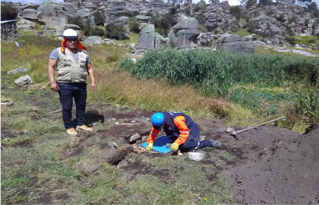
Figura 2.5: Buzón de alcantarillado en proceso de instalación.
