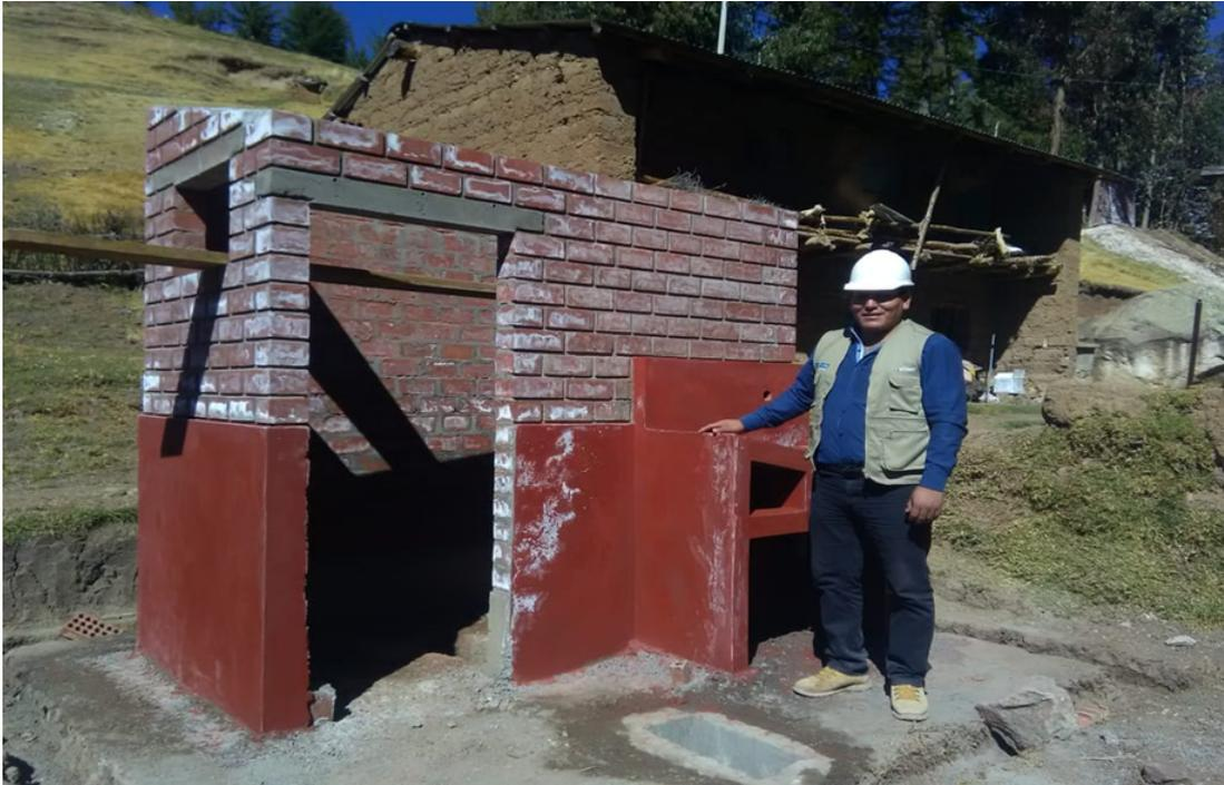
Figura 2.2: Retrete de tanque en proceso de construcción.
