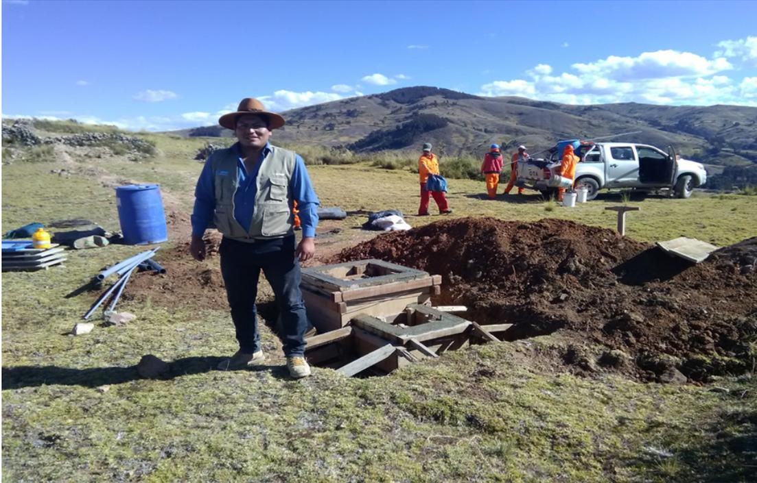
Figura 2.7: Encofrado de la captación tipo C-1
