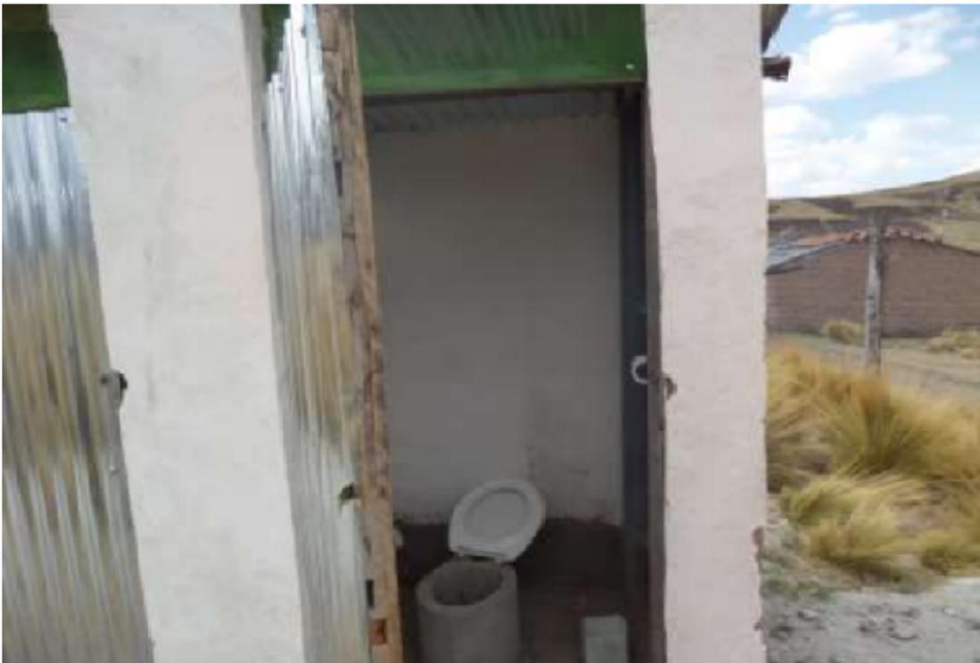
Figura 2.1: Retrete con arrastre hidráulico.
