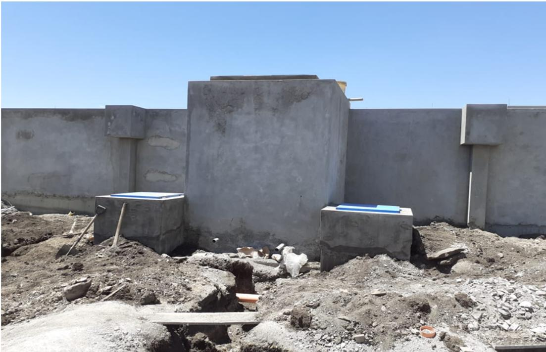
Figura 2.10: Cámaras rompe presión tipo 6 en construcción.
