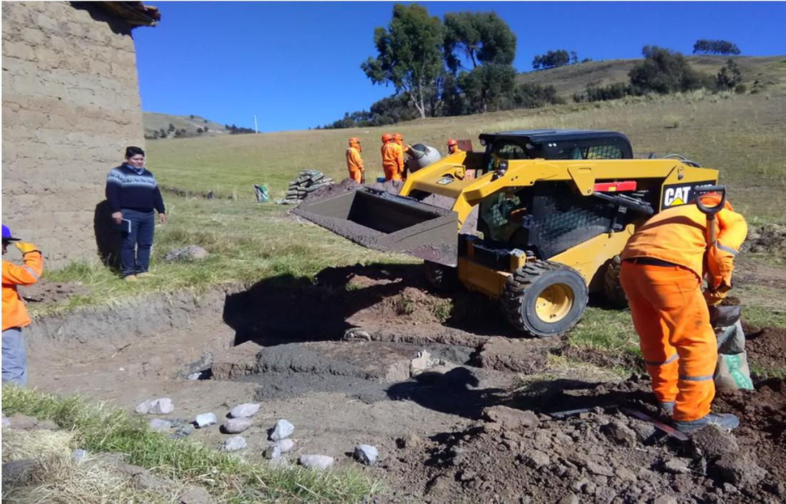
Figura 2.14: Proceso constructivo de una UBS (Colocación del concreto para la cimentación).
