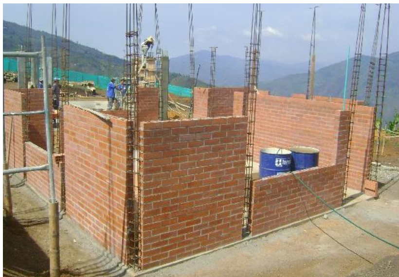
Gráfico 9: Muros de mampostería en proceso constructivo. Fuente: Elaboración Propia (2019).
