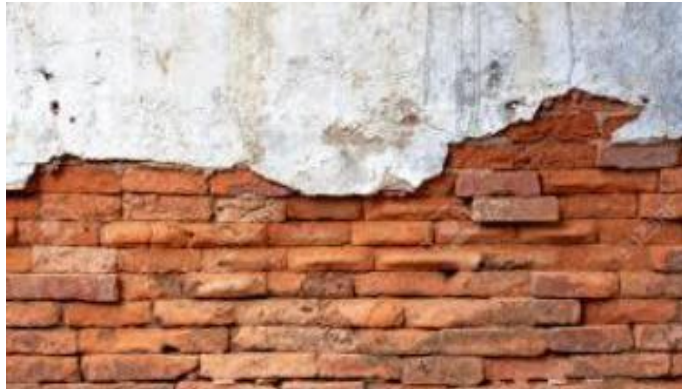
Gráfico14: Erosión en Muros de Mampostería. Fuente: Enciclopedia Broto. (2016).
