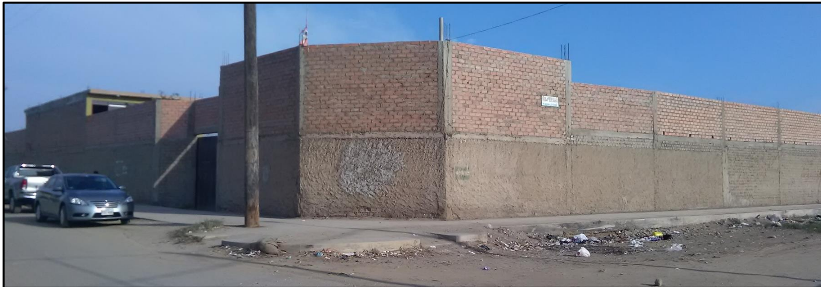
Fotografía 1: Vista panorámica del cerco del depósito maderero El Álamo.
