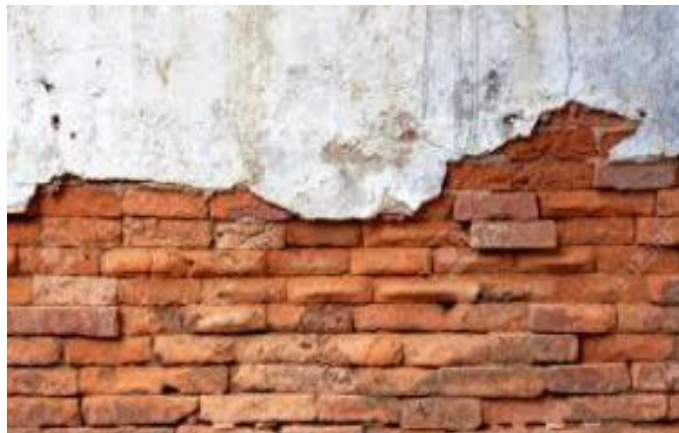
Gráfico 20: Erosión en Muros de Mampostería. Fuente: Enciclopedia Broto. (2016).
