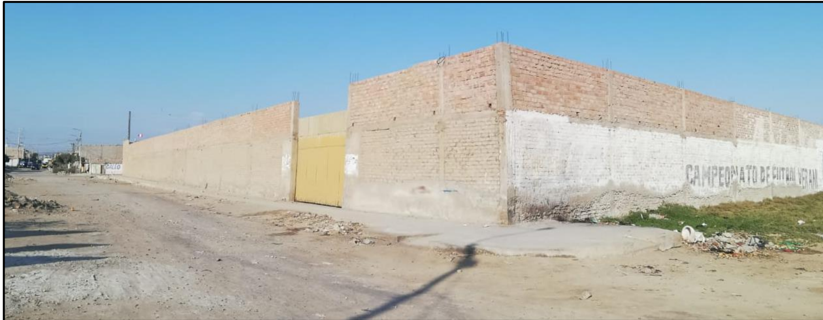
Fotografía 2: Vista panorámica del cerco del depósito maderero El Álamo.
