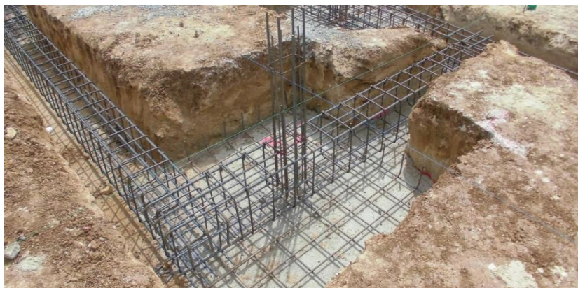
Gráfico 5: Cimentación en proceso constructivo. Fuente: Elaboración Propia (2019).
