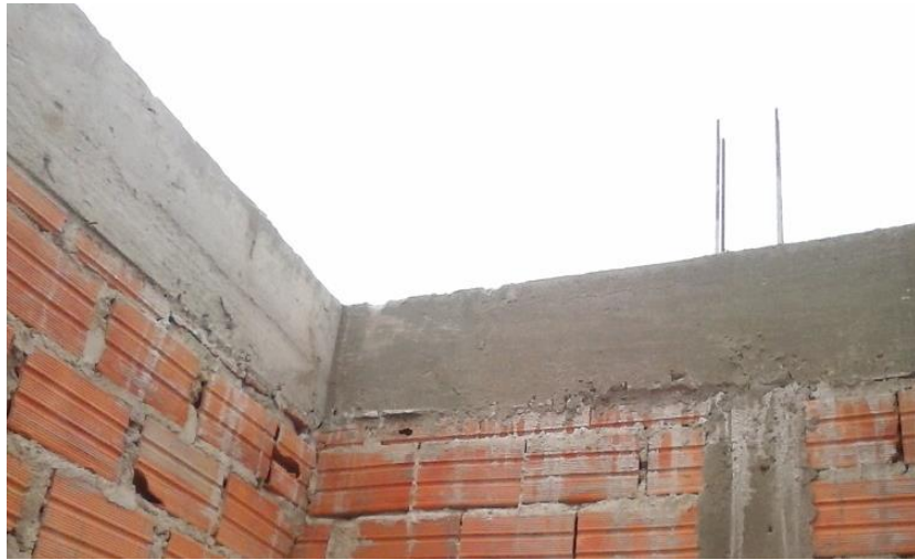
Gráfico 8: Vigas confinadas en proceso constructivo. Fuente: Elaboración Propia (2019).
