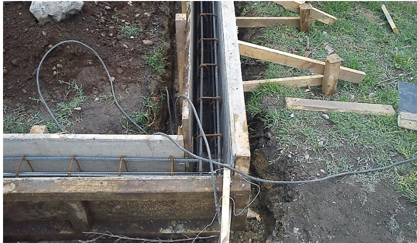
Gráfico 6: Sobrecimiento en proceso constructivo. Fuente: Elaboración Propia (2019).
