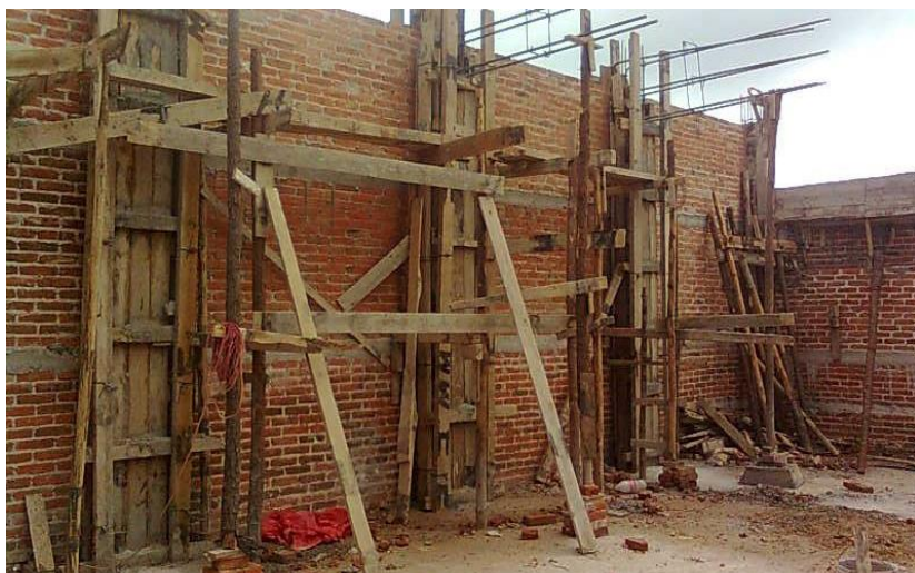
Gráfico 7: Columnas confinadas en proceso constructivo. Fuente: Elaboración Propia (2019).
