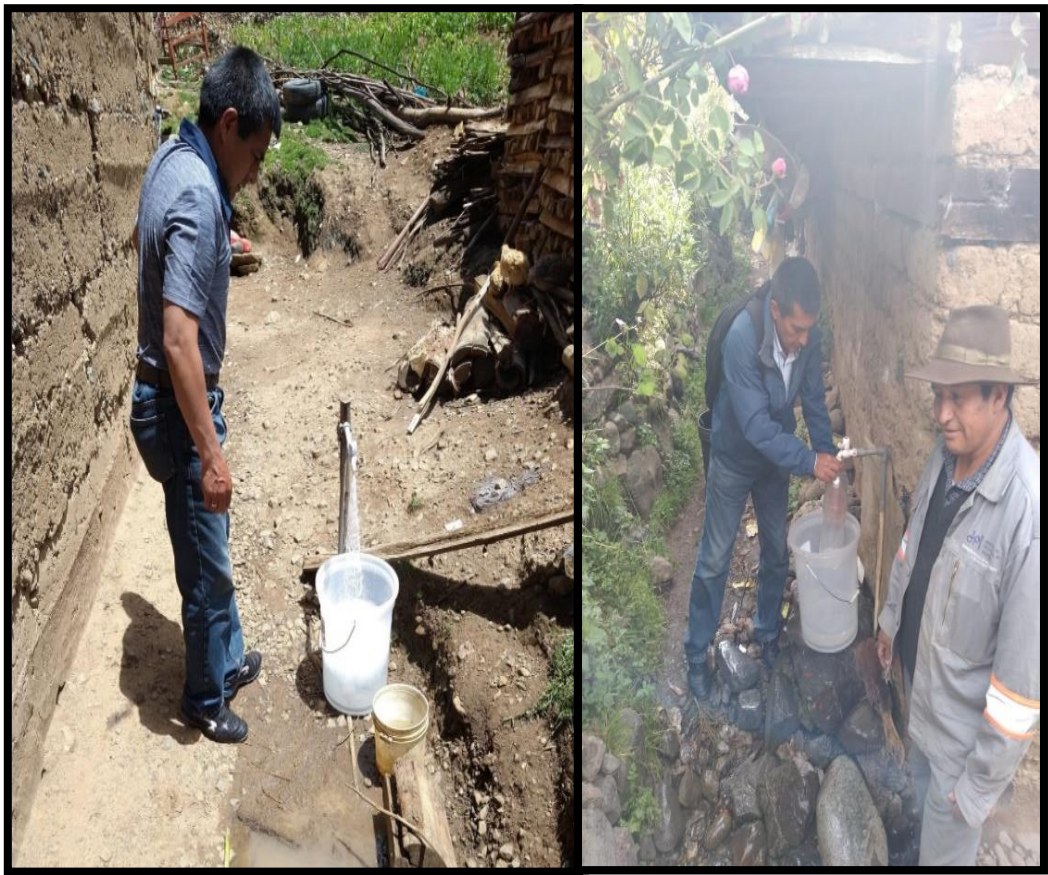
Figura 12: Conexión domiciliaria existente.
