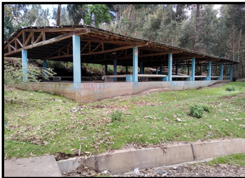
Figura 19: Vista de infraestructura del lecho de lodos.
