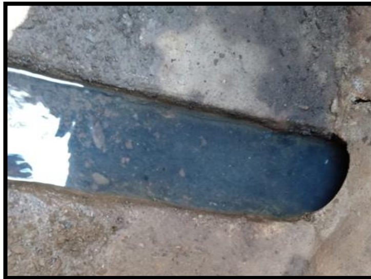
Figura 13: Vista interior de buzón colector.
