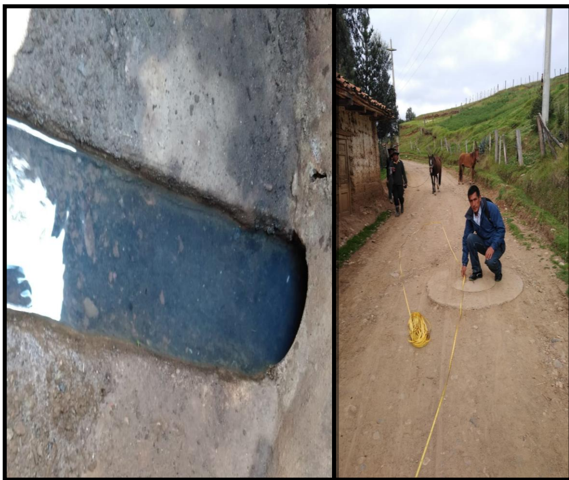
Figura 14: Interior del buzón colector existente.
