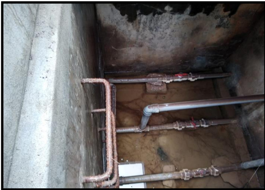
Foto 04: Se observa el interior de la caseta de válvulas y ver la condición actual en la que se encuentra.
