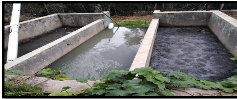
Figura 16: Vista del tanque IMHOFF existente en el centro poblado de Huaripampa.
