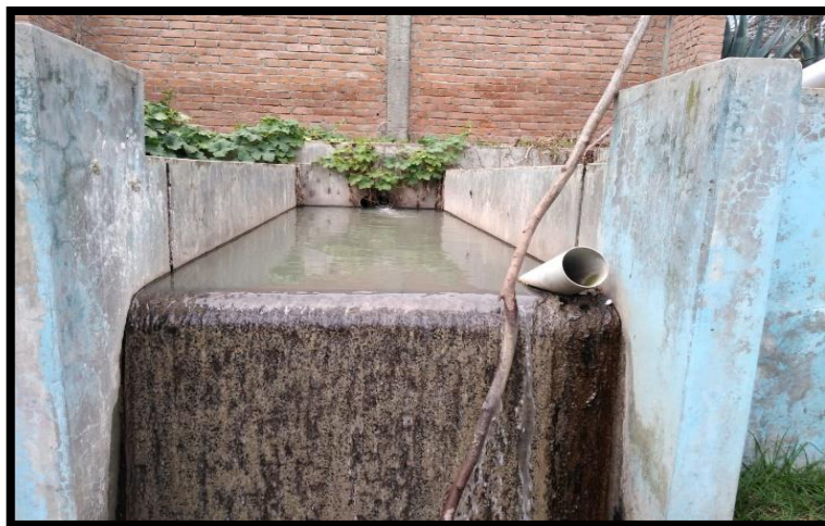
Figura 15: Al fondo se observa emisor de desagüe.
