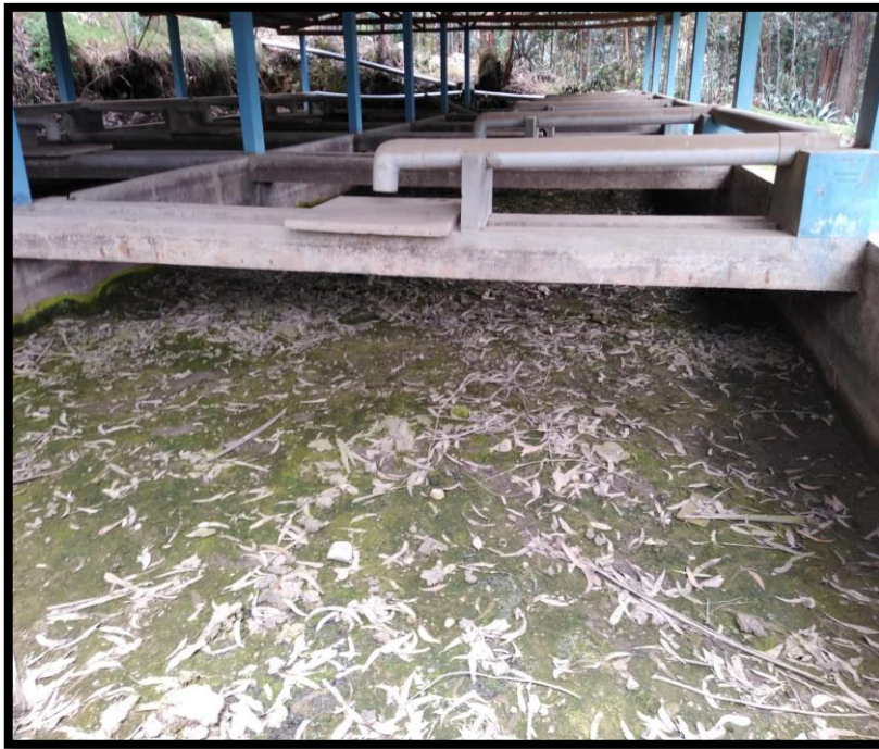
Figura 18: Interior de la infraestructura de lecho de lodos.
