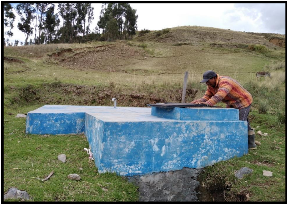
Foto 03: Se observa el reservorio, el cual se tuvo que abrir la tapa sanitaria para ver cómo se encontraba el interior de este.
