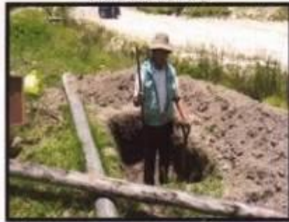
CALICATA 07 ZONA RESERVARIO
