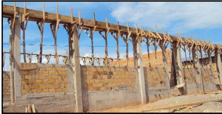
Figura 21: Detalle de encofrado de viga de amarre.
