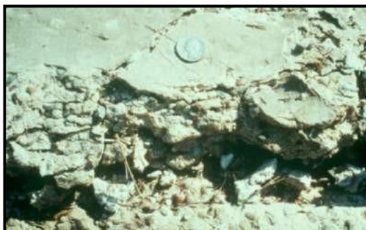
Figura 45: Desintegración de una estructura.
