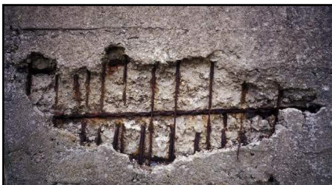
Figura 29: Ataques por cloruros.
