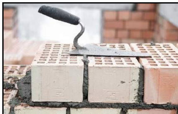
Figura 24: Detalle del empastado con mortero y ladrillo.
