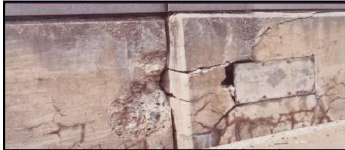
Figura 43: Distorsión del concreto.
