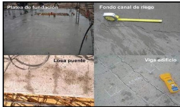
Figura 35: Patologías por contracción de secado.
