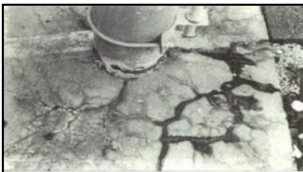
Figura 30: Deterioro por ataque de sulfatos.
