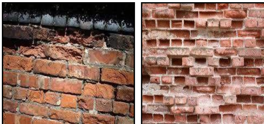
Figura 36: Erosión en muros de albañilería.
