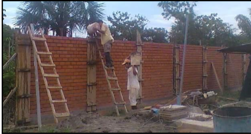
Figura 05: Llenado de concreto en las columnas
