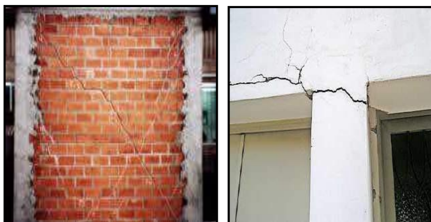
Figura 37: Fisuración de elementos estructurales.
