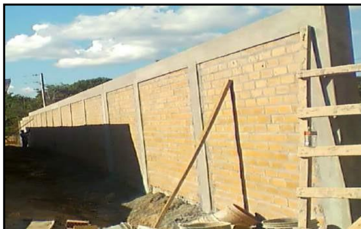
Figura 20: Acabado de viga de amarre del cerco perimétrico.
