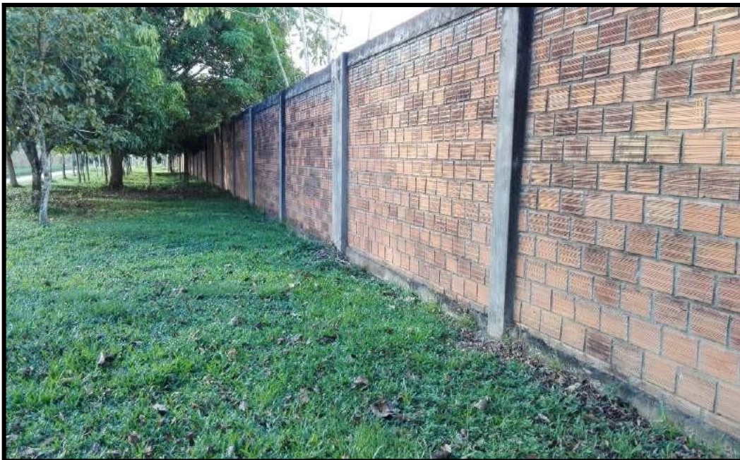
Figura 87: Vista panorámica interior del cerco perimétrico del Instituto de Investigaciones de la Amazonía Peruana.
