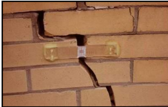
Figura 32: Patologías de grietas estructurales.
