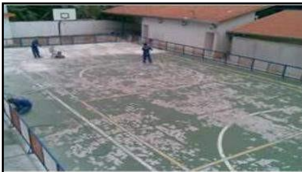
Figura 33: Deterioro mediante la abrasión.
