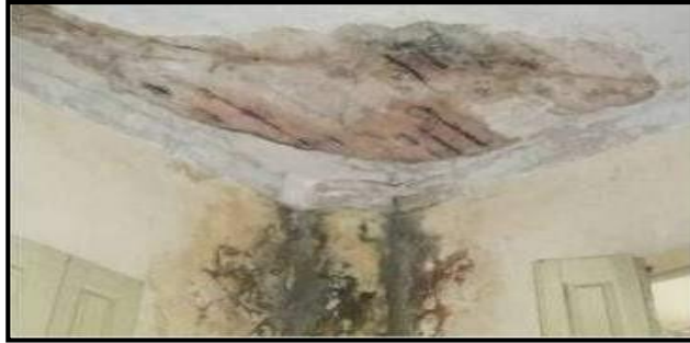
Figura 31: Deterioro por medio de carbonatación.
