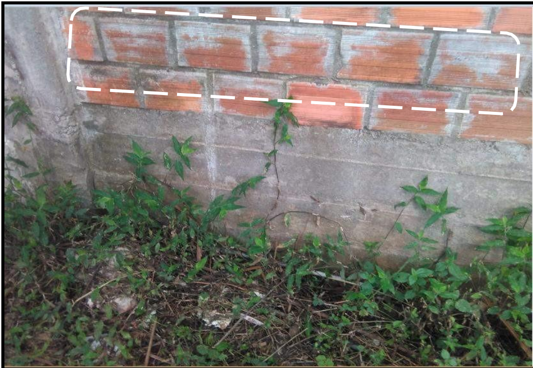
Figura 93: Apreciación de eflorescencia de severidad moderada.
