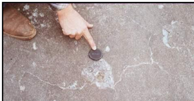
Figura 44: Popouts o cráter en el concreto.
