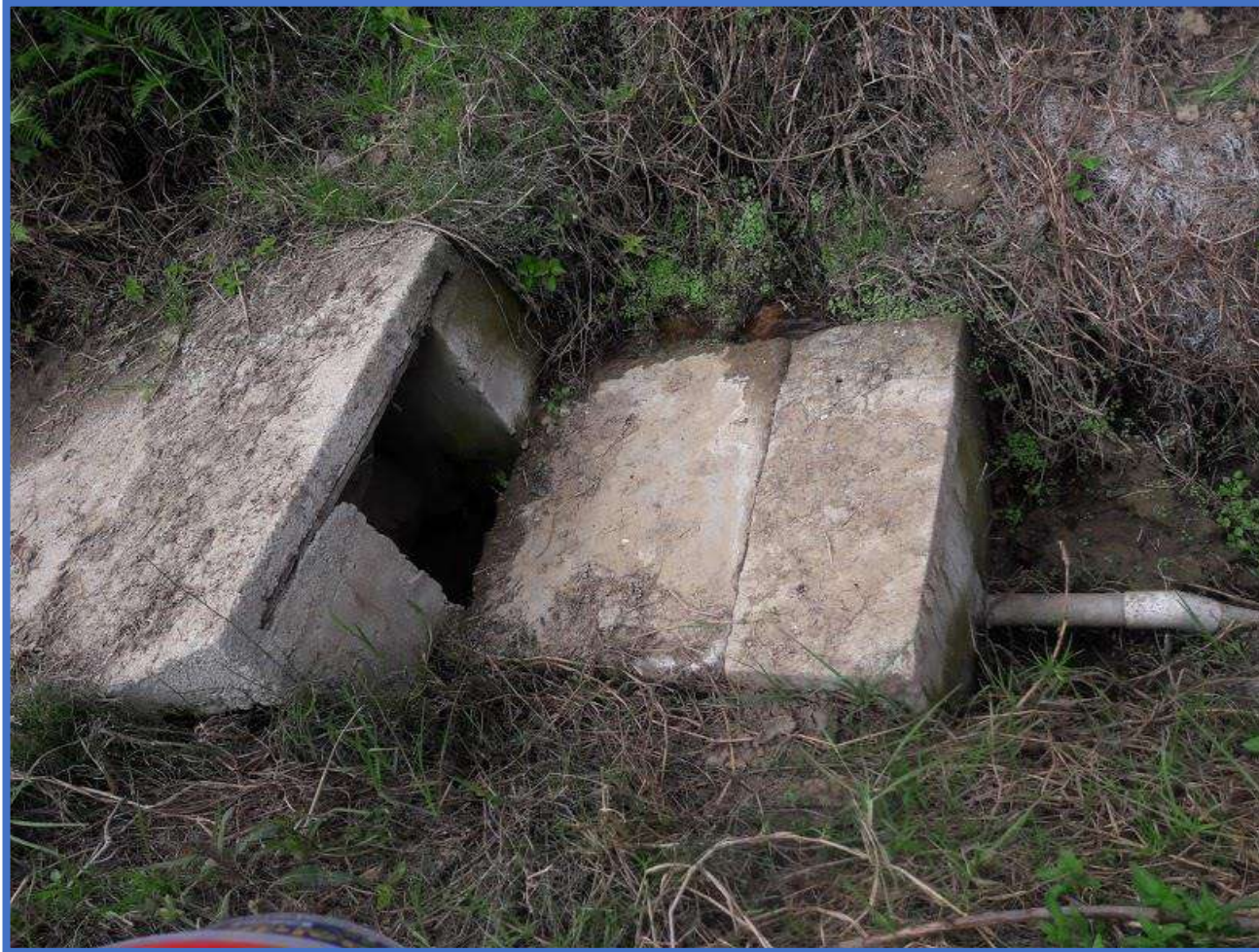
Imagen 1. Captación artesanal Wayta del caserío Canchas
