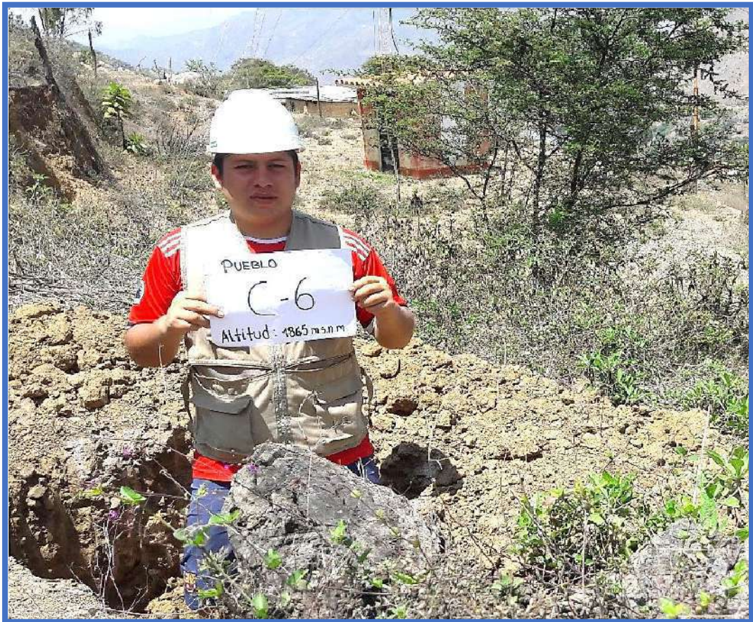
Imagen 23. Calicata N° 06 en el pueblo a 1865 m.s.n.m.
