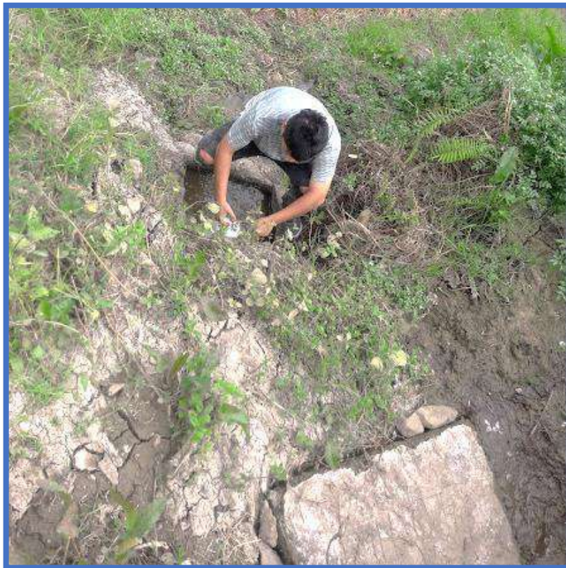
Imagen 8. Captación Wayta del caserío Canchas.
