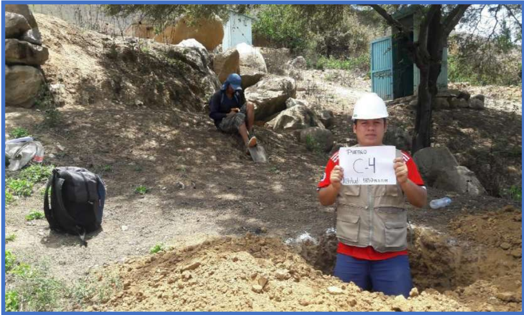
Imagen 21. Calicata N° 04 en el pueblo a 1850 m.s.n.m.
