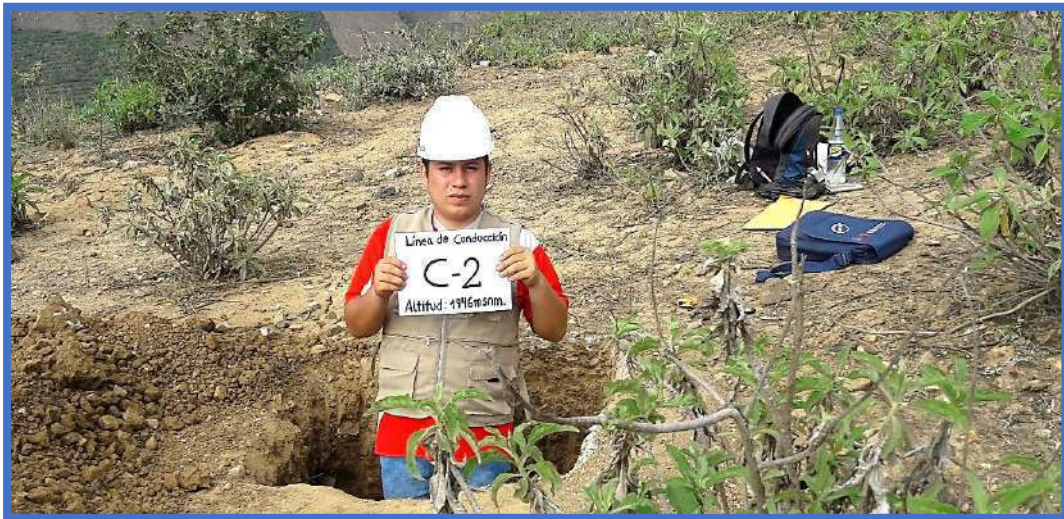
Imagen 19. Calicata N° 02, en la línea de conducción a 1946 m.s.n.m
