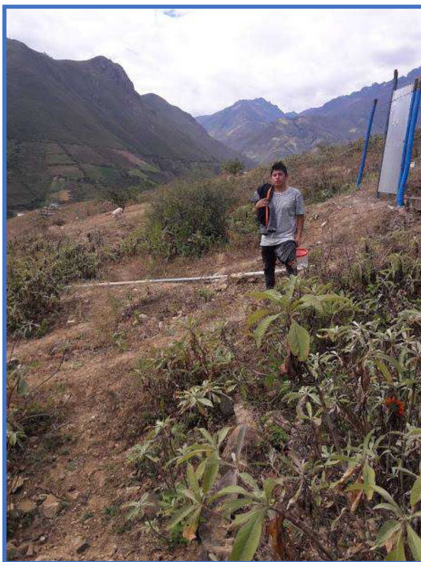
Imagen 6. Línea de aducción
