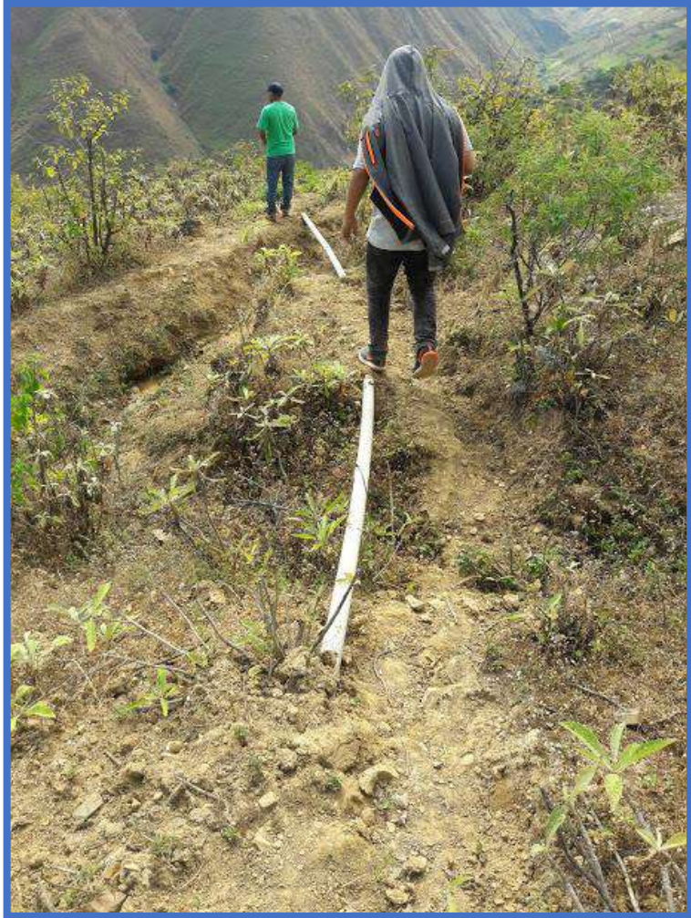
Imagen 2. Línea de conducción tramo 1
