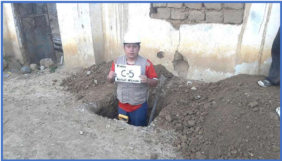
Imagen 22. Calicata N° 05 en el pueblo a 1853 m.s.n.m.
