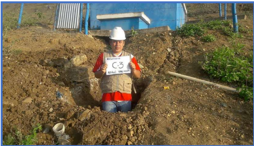
Imagen 20. Calicata N° 03 en el reservorio a 1898 m.s.n.m.
