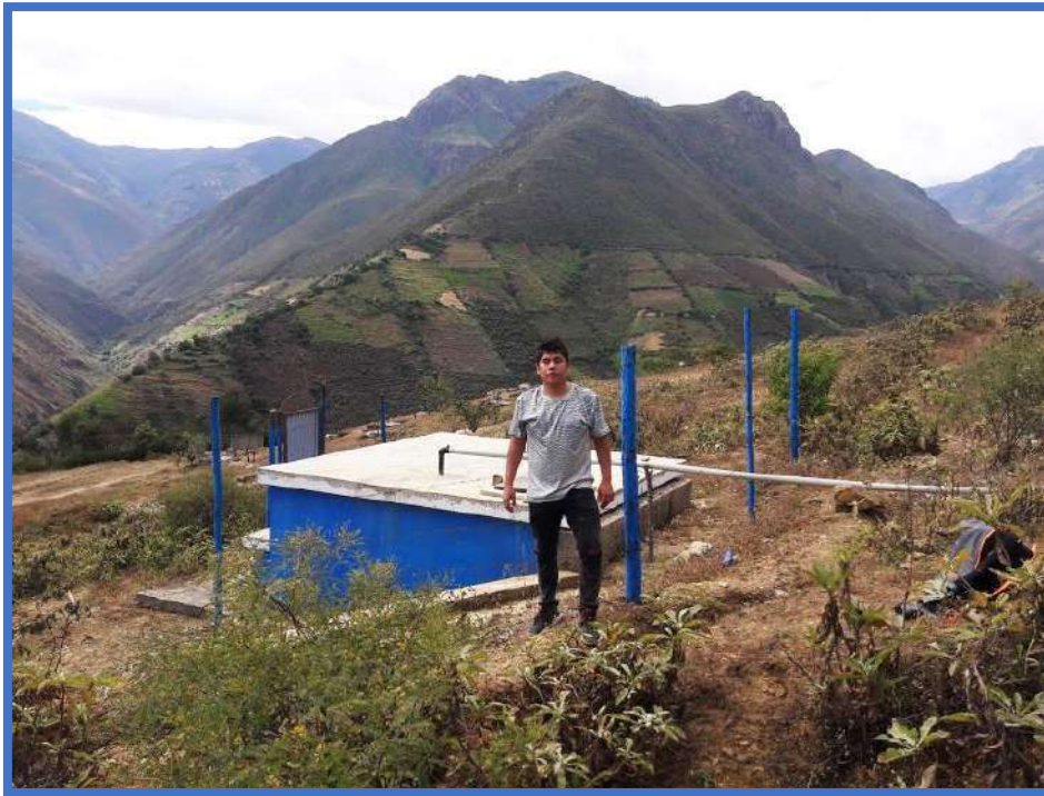
Imagen 11. Tubería de la línea de aducción
