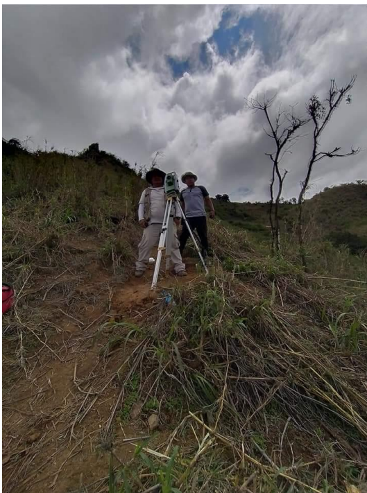
Levantamiento topográfico con Estación Total.
