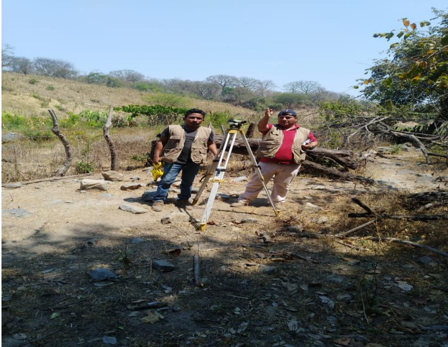
Topografía preliminar para línea de conducción con teodolito.
