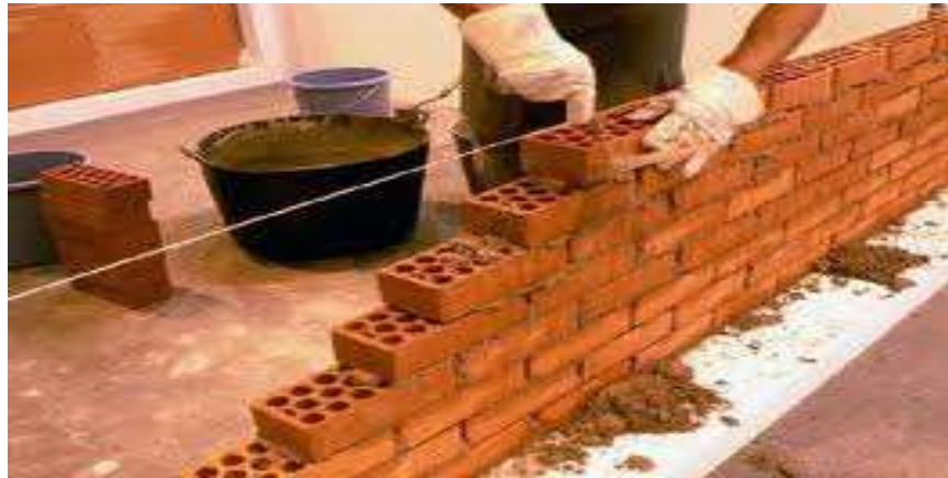
Figura 4: Muro de Albañilería Simple.
