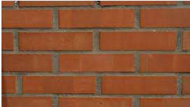
Figura 10: Muro de Albañilería.
