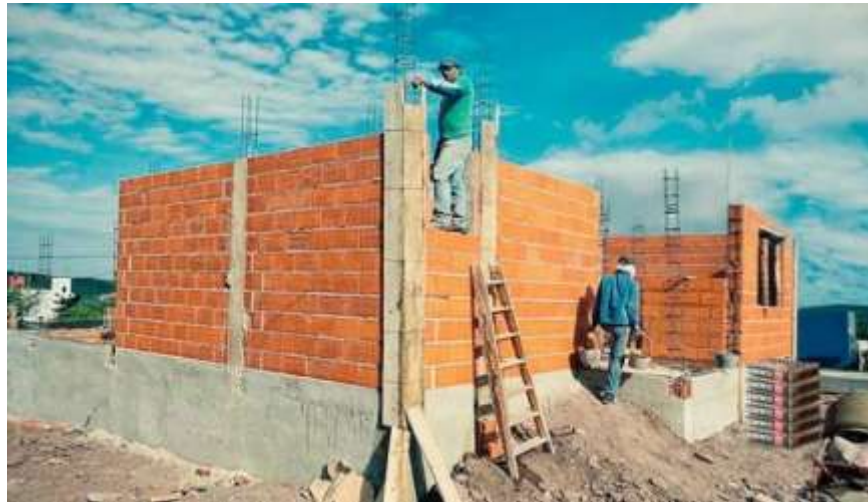
Figura 7: Proceso Constructivo de una vivienda de Albañilería Confinada.
