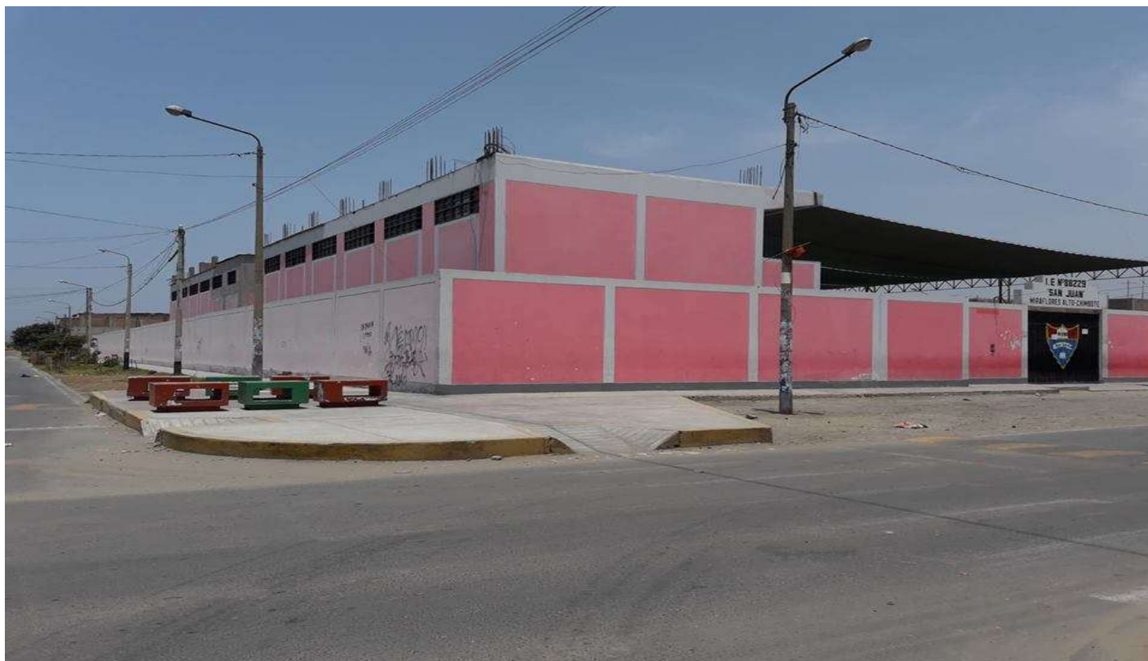
Fotografía 2: Vista esquinada de la Institución Educativa N° 88229 San Juan, Distrito de Chimbote, provincia del Santa, región Áncash..
