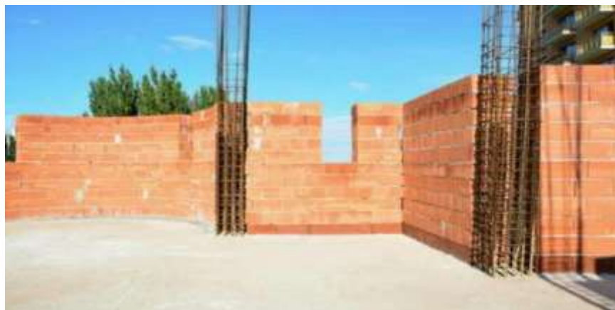
Figura 5: Vivienda de Albañilería Confinada.
