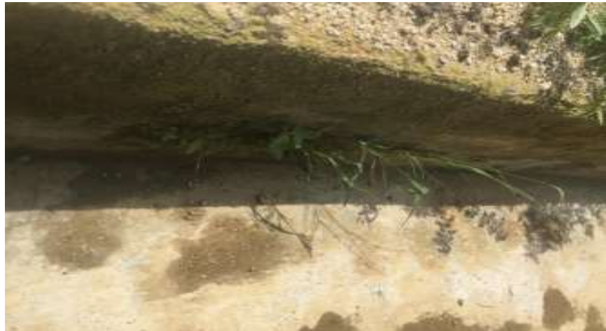
Figura 30: Vegetación en un Muro.
