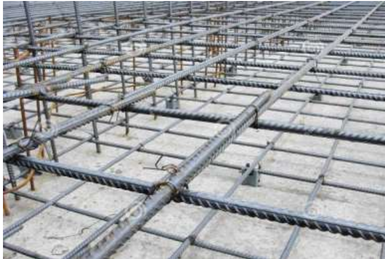
Figura 15: Acero de refuerzo.
