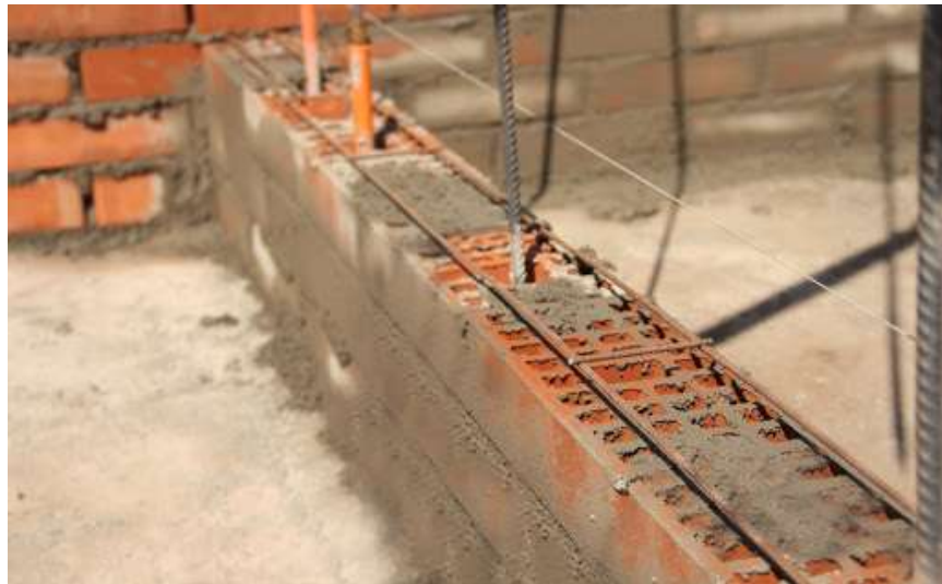
Figura 6: Muro de Albañilería Armada.
