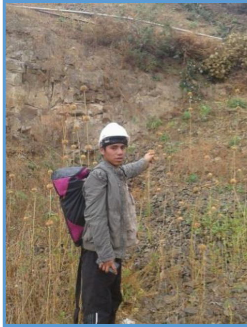
Fotografía 9: En esta fotografía se puede apreciar, en el tramo de la línea de aducción, la tubería que se encuentra entre la intemperie y se encuentra en una posición mal ubicada, esto se da por falta de mantenimiento.
