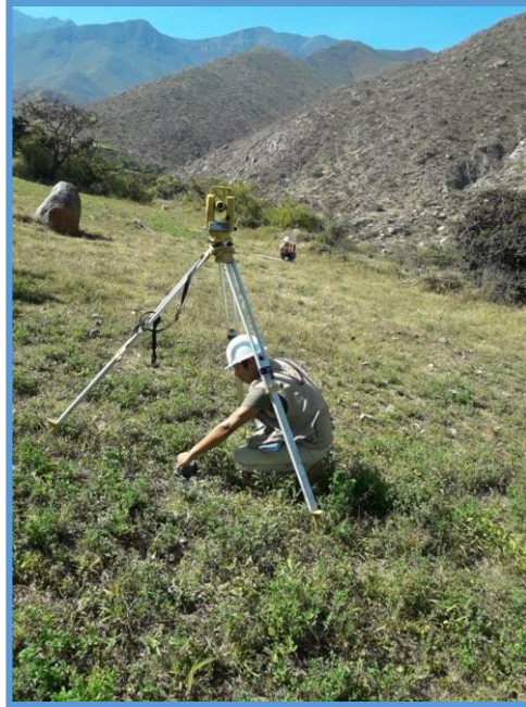
Fotografía 19: En la fotografía se puede apreciar el proceso del trabajo de levantamiento topográfico en la línea de conducción, donde se tomaron medidas, con el fin de comprobar las distancias horizontales en campo y en gabinete.
