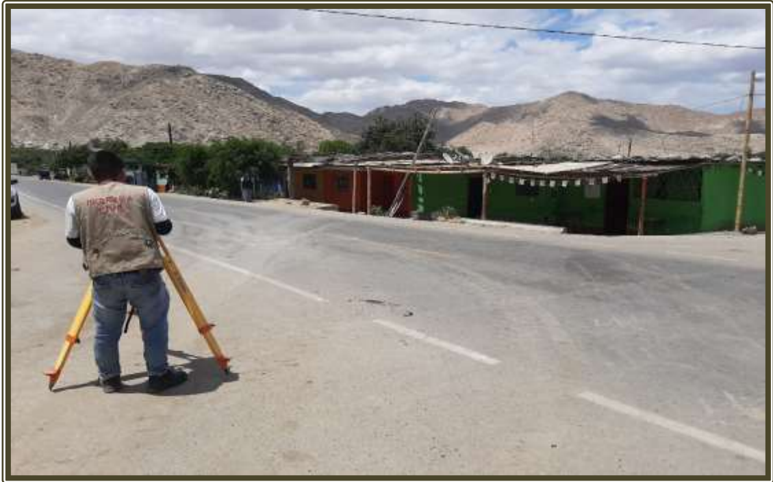
Fotografía 27: Se observa el trabajo de levamiento topográfico que se realizó en la red de distribución del centro poblado María Cristina.
