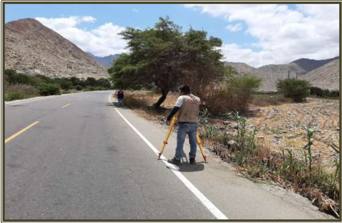
Fotografía 21: Se observa que se realizó el levantamiento topográfico de la línea de conducción, del centro poblado María Cristina.
