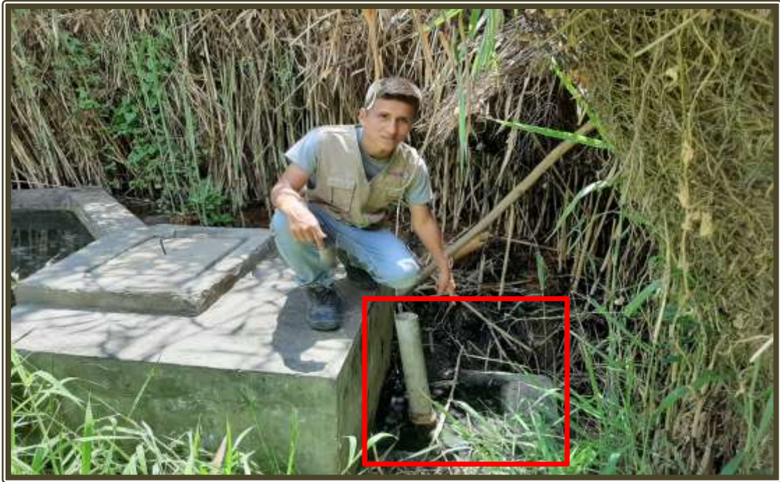
Fotografía 11: Se observa la estructura de la caja de válvulas que se encuentra saturada, debido que existe fuga por la válvula de compuerta existente.
