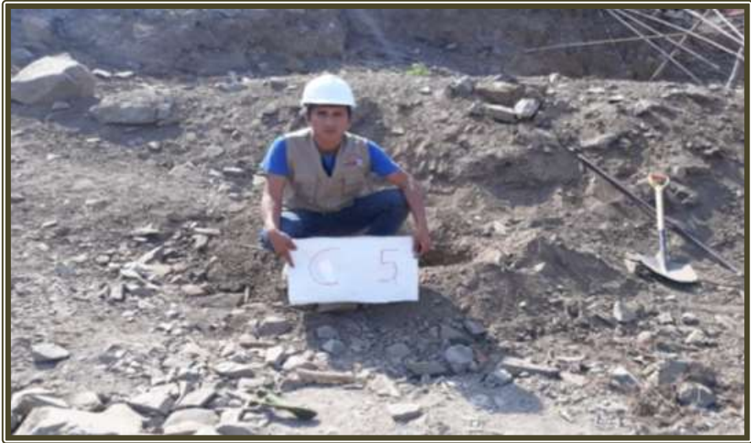
Fotografía 33: Se muestra la calita C-5, con fines de evaluar el tipo de suelo que se presenta en la línea de conducción.
