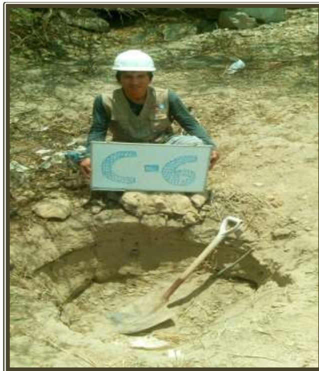
Fotografía 34: Se muestra la calita C-6, con fines de evaluar el tipo de suelo que se presenta en la línea de conducción.
