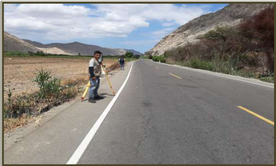
Fotografía 22: Se observa el levantamiento topográfico de la línea de conducción, para obtener los datos se empleó el equipo de estación total.
