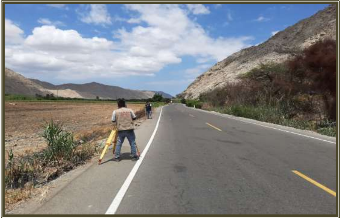
Fotografía 23: Se muestra el levantamiento topográfico de la línea de conducción, para obtener los datos se empleó el equipo de estación total.
