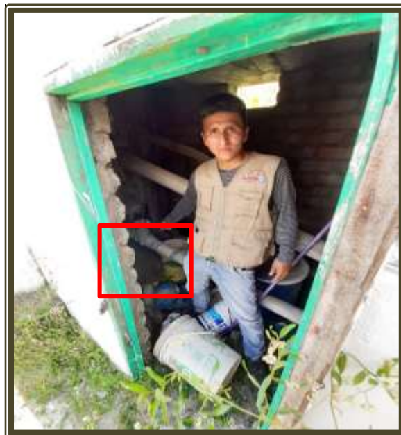
Fotografía 16: Se indica la inspección de válvula de compuerta, que corresponde a tubería de ingreso.
