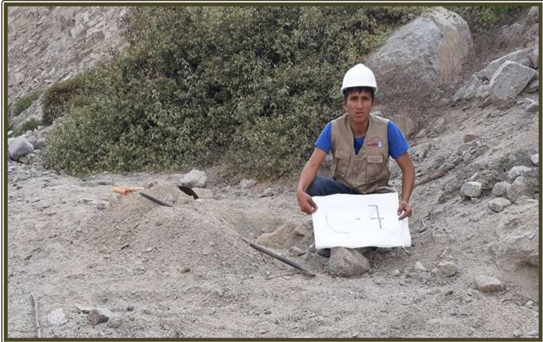
Fotografía 35: Se muestra la calita C-7, con fines de evaluar el tipo de suelo que se presenta en la línea de conducción.
