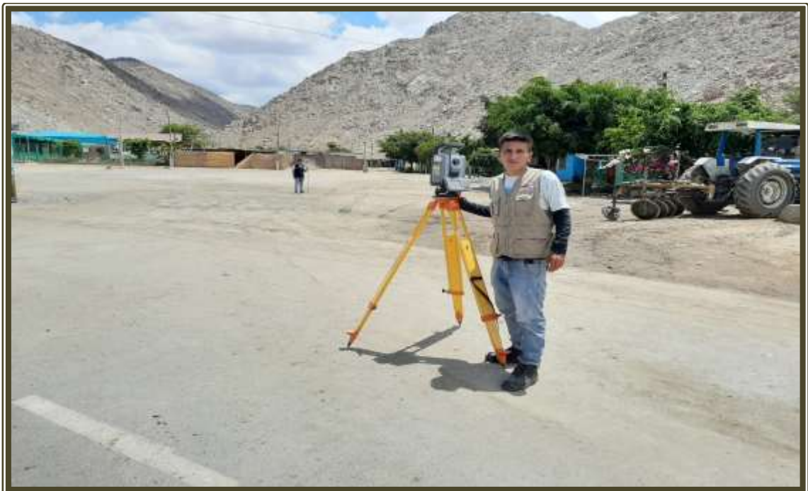
Fotografía 24: Se observa el levantamiento topográfico de la red de distribución, del centro poblado María Cristina.
