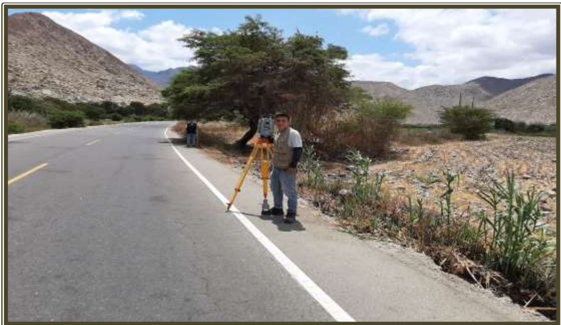
Fotografía 20: Se observa el levantamiento topográfico de la línea de conducción, que nos permitido obtener las características matemáticas del terreno.
