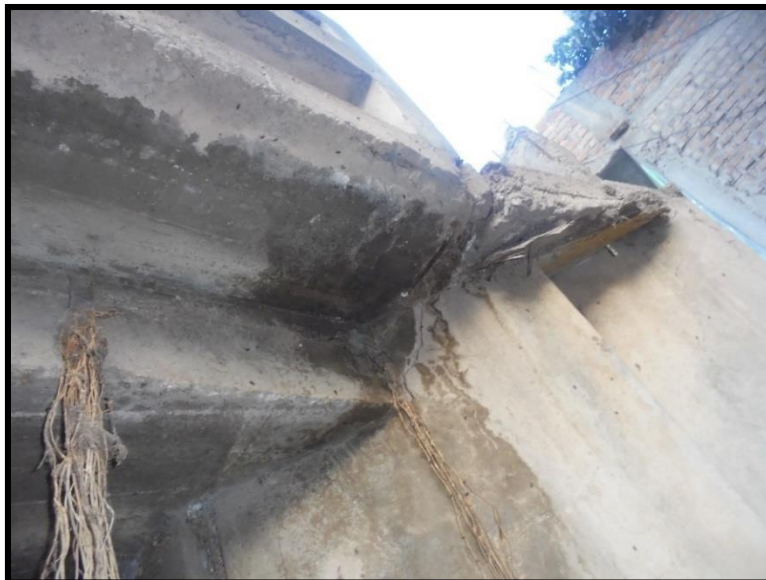
Figura N° 09 Patología en la columna 2 del puente
