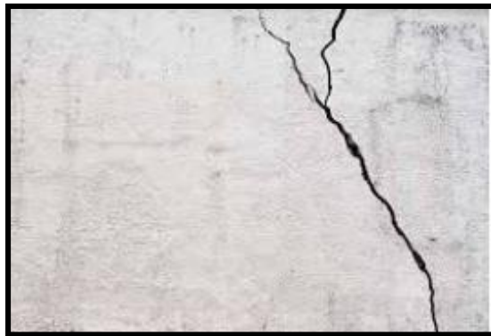
Figura 10 Fisura en concreto
