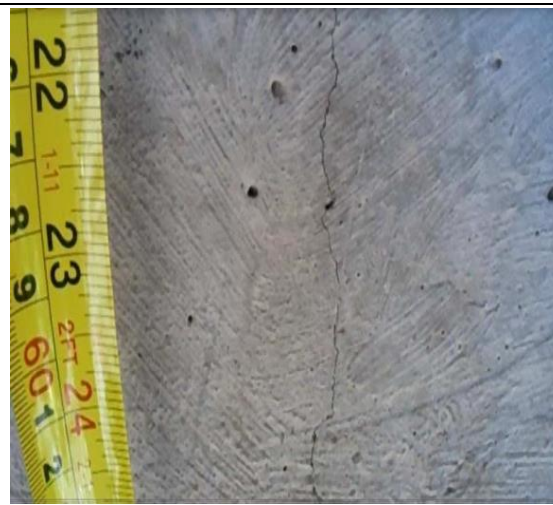
Figura 23 Fisuras en la viga 2 Fuente: Elaboración propia
