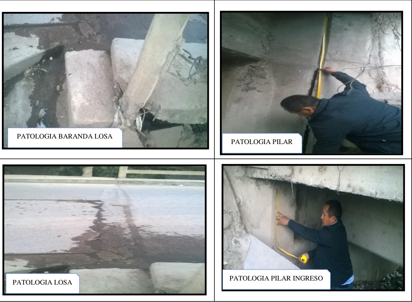
Figura N° 17 Grietas y fisuras en los elementos del puente.
