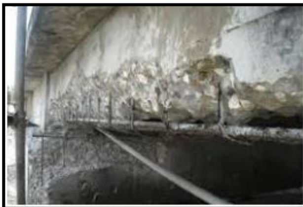
Figura 11 Desprendimiento del concreto
