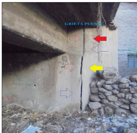
Figura 25 Fisuras en la Columna 1 Fuente: Elaboración Propia
