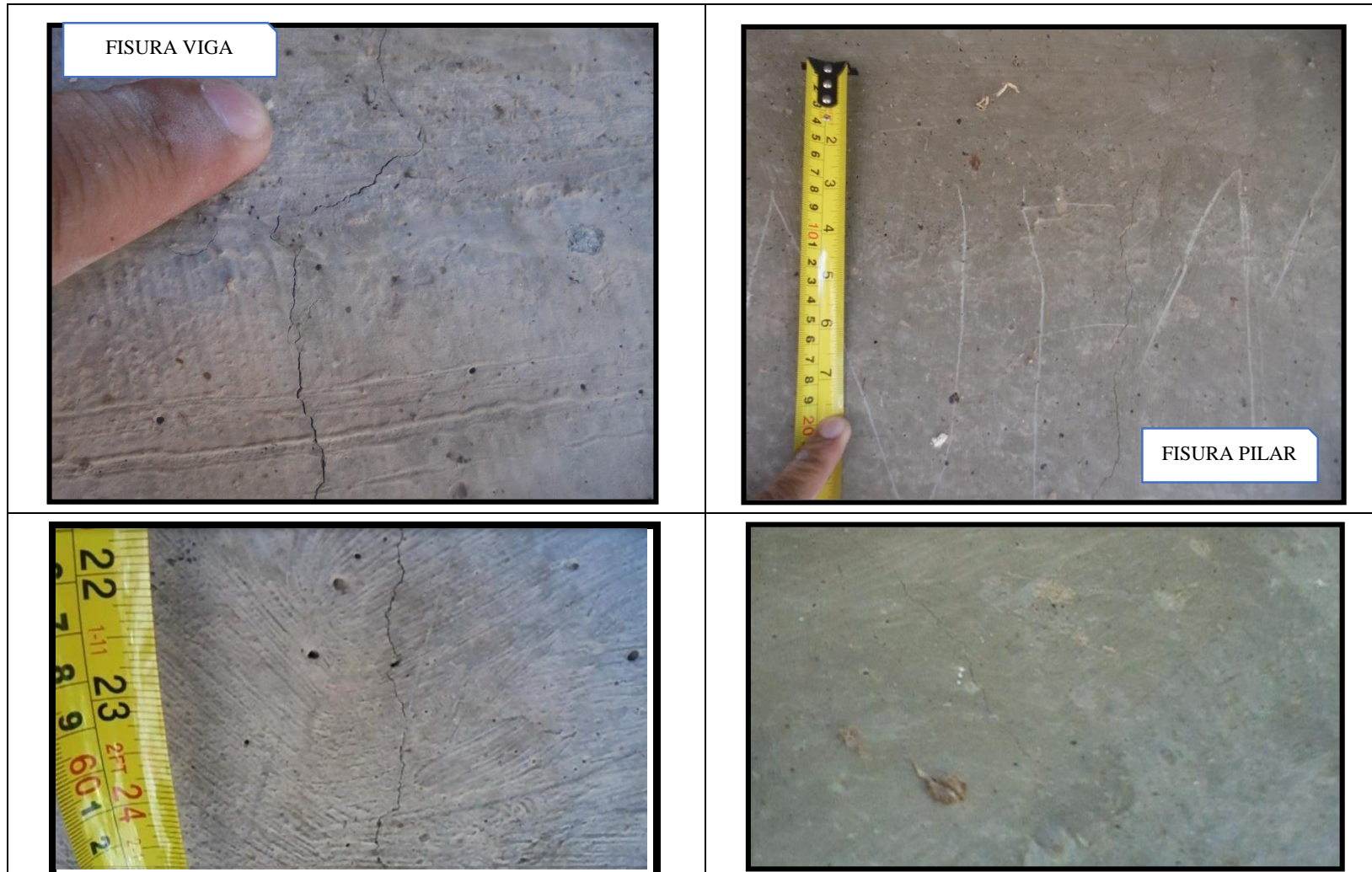
Figura N° 16 Fisuras en la viga.
