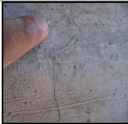
Figura 22 Fisuras en la Viga 1 Fuente: Elaboración propia
