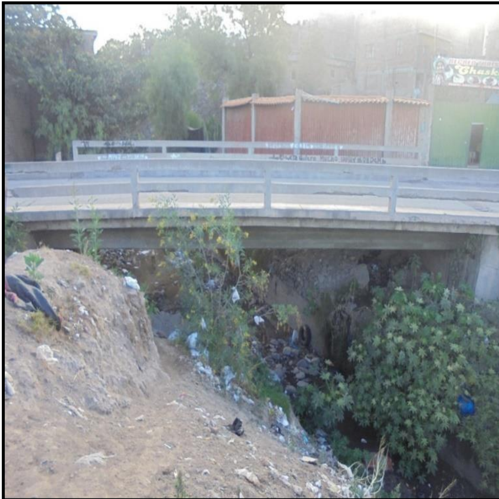
Figura N° 15 Foto panorámica del puente donde se muestra la exposición a elementos que lo deterioran.
