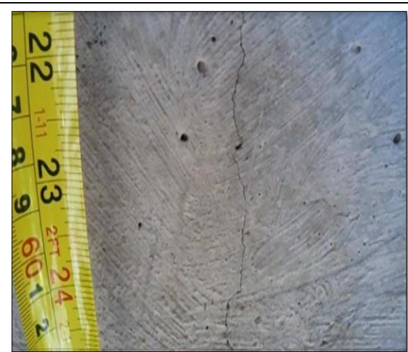
Figura 24 Fisuras en la viga 3 Fuente: Elaboración propia
