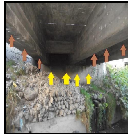
Figura 27 Fisuras en la Viga Fuente: Elaboración Propia
