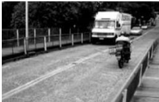
Figura 13 Colisiones en el concreto
