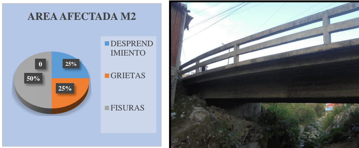
Figura N° 13 Patología en la viga del puente sección lateral 2
