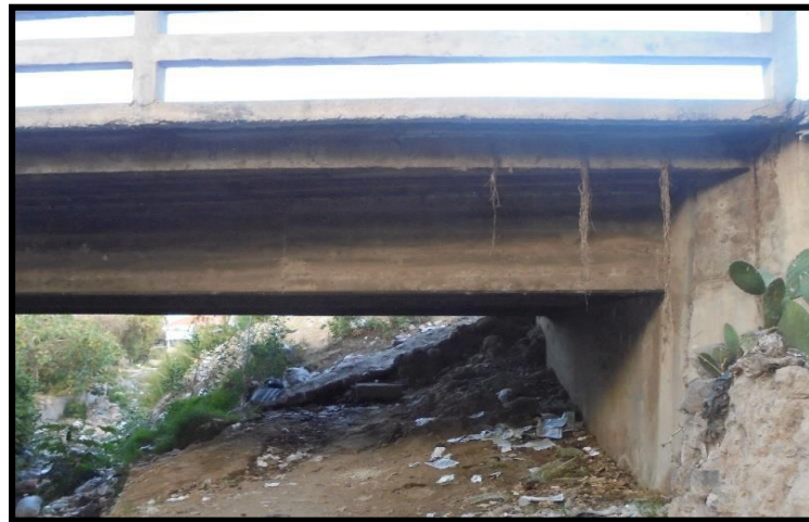
Figura 18 Patología en la Viga del puente Fuente: Elaboración propia
