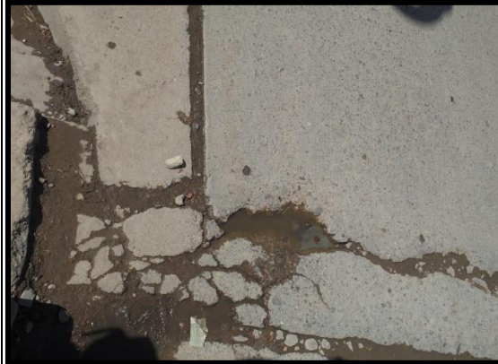
Figura 29 Grietas Pronunciadas Junto a la Vereda Fuente: Elaboración Propia
