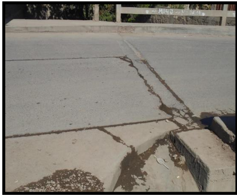
Figura 28 Grietas en Losa altura del Pilar Fuente: Elaboración Propia
