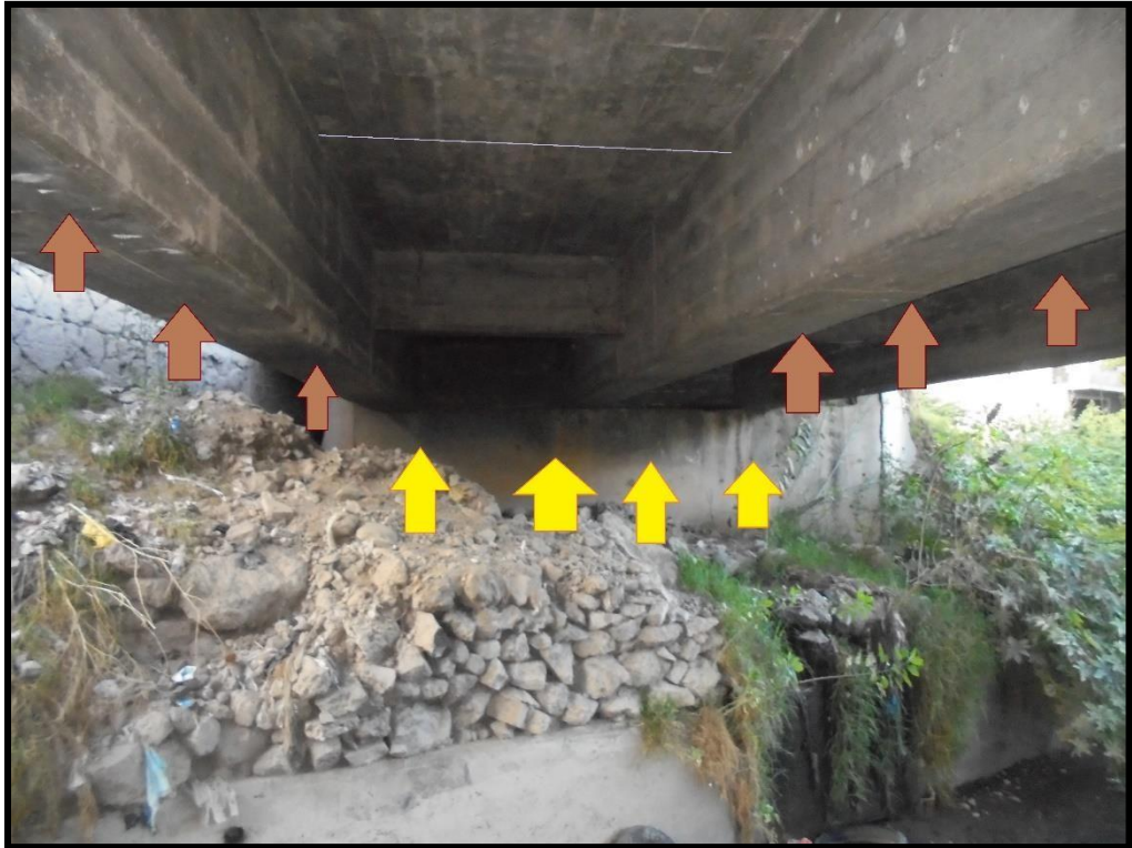
Figura N° 20 LAS FISURAS EN LA VIGA
