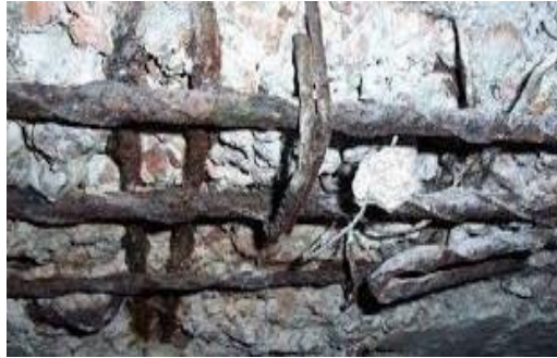
Figura 12 Patología corrosión del acero
