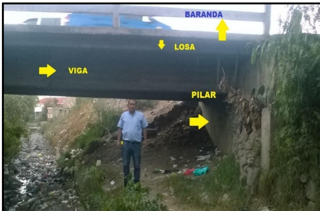
Figura 01 Partes del puente
