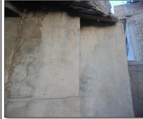
Figura 30 Grietas Columna Fuente: Elaboración Propia
