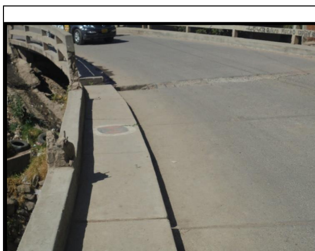
Figura 20 Patología en la Baranda del puente Fuente: Elaboración propia
