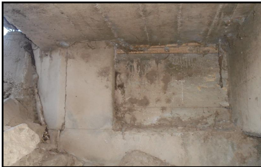
Figura N° 08 Patología en la columna 1 del puente
