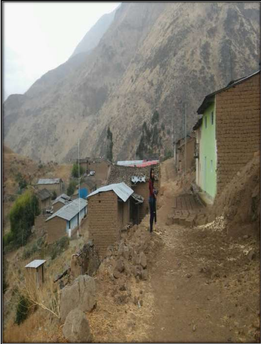
Fotografía N° 01: Reconocimiento del Caserío San Antonio de Ranchin
