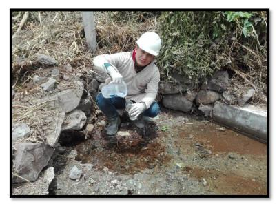
**Figura 16**: Extracción de muestra para determinar en laboratorio la calidad del agua.
