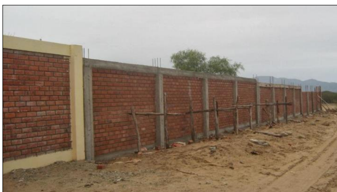
Imagen 01: Cerco de albañilería.
