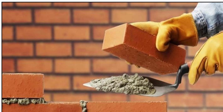
Imagen 11: Unidad de albañilería.
