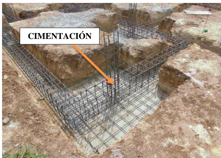
Gráfico 5. Cimentación de concreto armado. Fuente: Mi devocional (2018).
