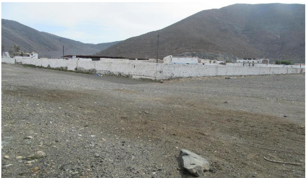
Fotografía 4: Vista panorámica del cerco del local de almacenamiento de la empresa Petroperú.
