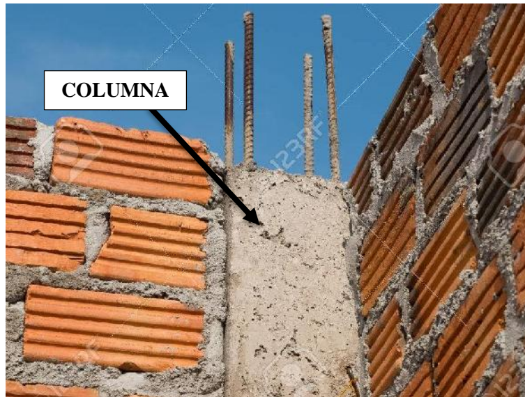
Gráfico 7. Columna de concreto armado. Fuente: Sutichak Yachiangkham (2019).
