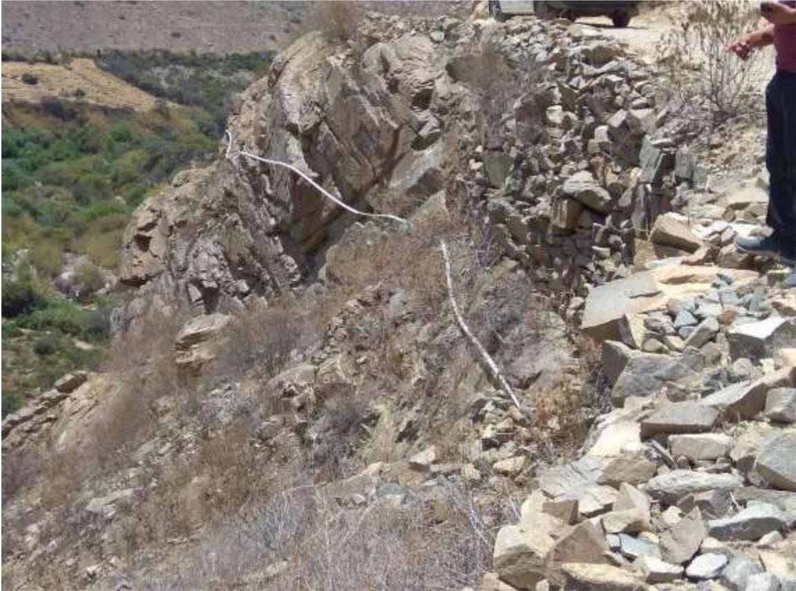
*Foto 04. Línea de conducción: obsérvese la tubería expuesta y el terreno rocoso.*
