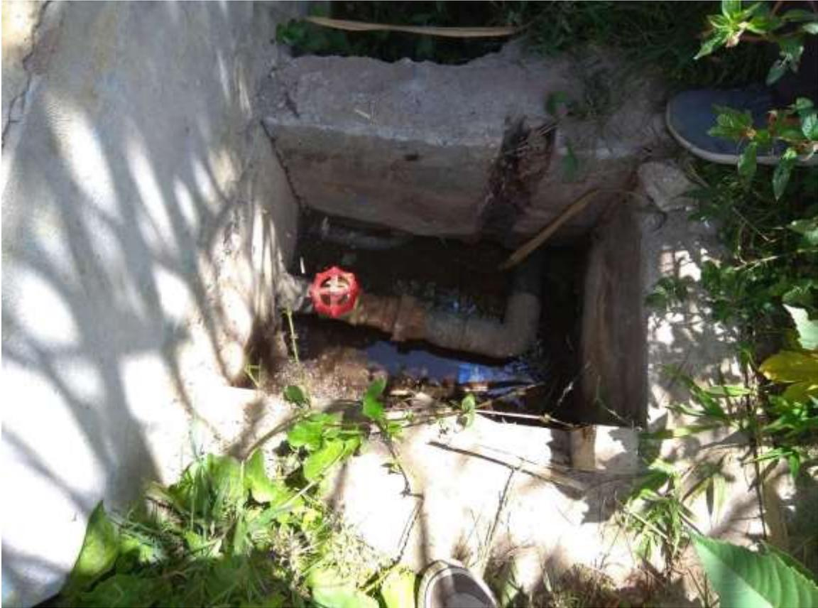
*Foto 07. Caseta de Válvulas del reservorio, véase una sola llave y tubería deterioradas.*
