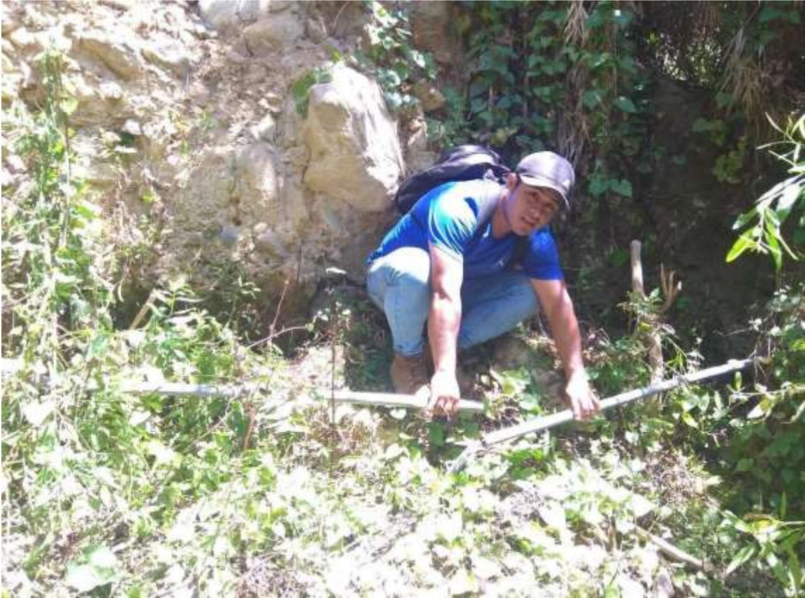
*Foto 05. Línea de conducción: obsérvese la tubería de conducción despegada.*
