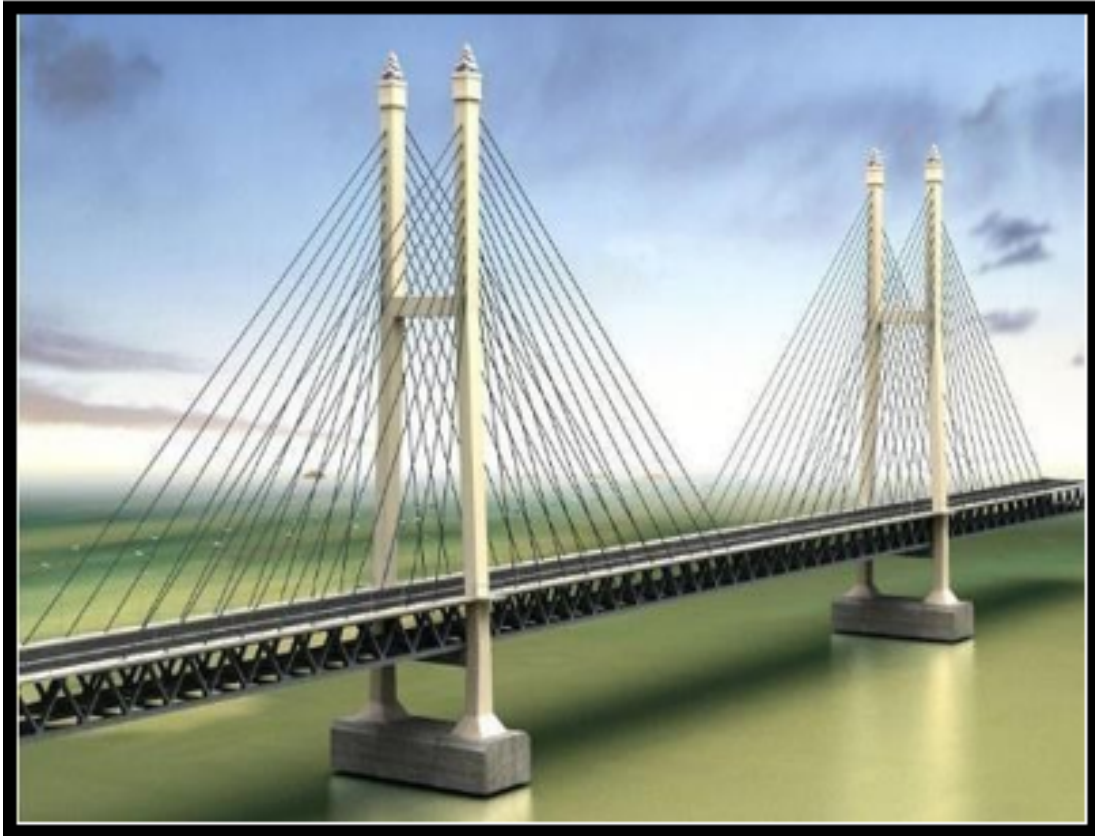
Figura 2.7: Tipo Atirantado Fuente: Elaboración Propia
