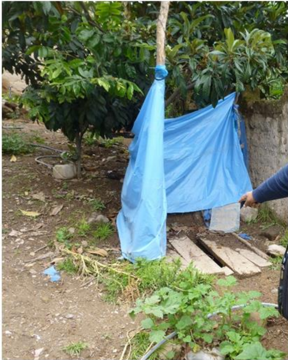
Figura 5.6: San Juan Bautista: Instalación precaria de pozo ciego. Fuente: Elaboración propia.
