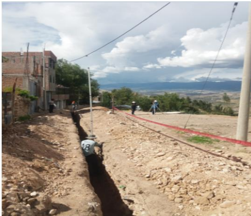
Fotografía 8: Excavación de Zanja red matriz de alcantarillado en jr. Buena Vista.
