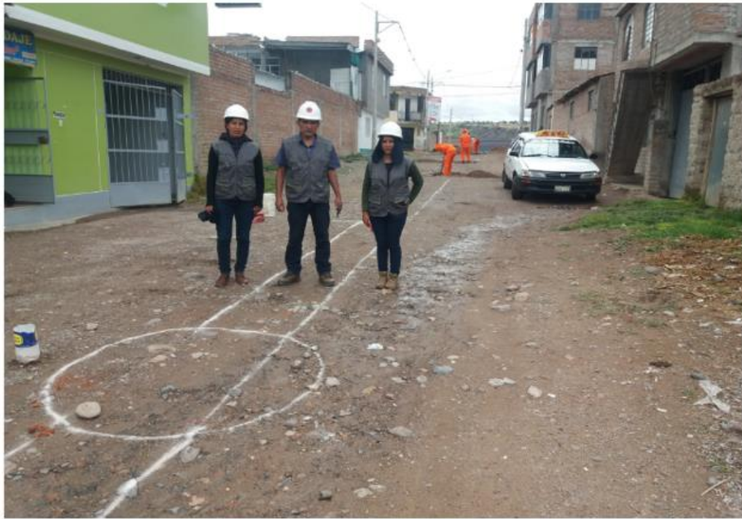
Fotografía 9: Excavación de Zanja red matriz de alcantarillado en jr. Angaraes.
