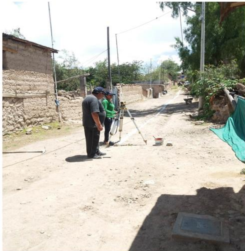
Fotografía 4: Trazo y replanteo de la línea de conducción en jr. Buena Vista.
