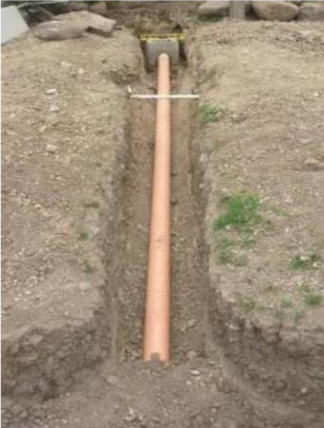
Figura 2.8: Red de alcantarillado. Fuente: Dirección nacional de saneamiento.
