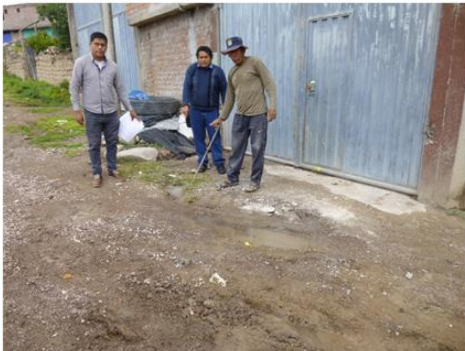
Figura 5.4: San Juan Bautista: Tuberías inadecuadas de agua en colapso. Fuente: Elaboración propia.
