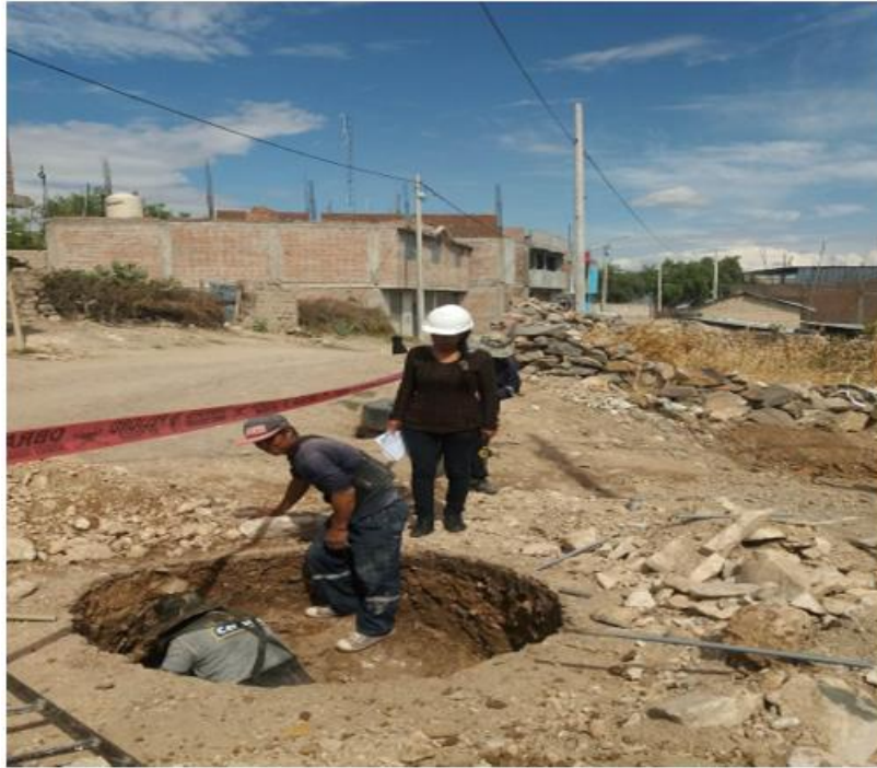
Fotografía 7: Excavación de buzones en jr. Buena Vista.
