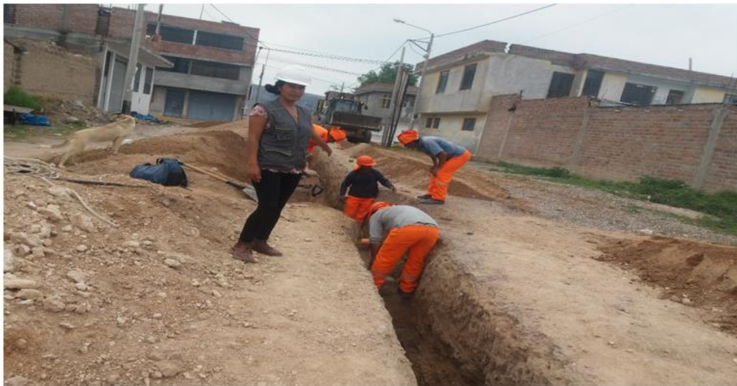
Fotografía 10: Excavación de Zanja red matriz de alcantarillado en jr. Angaraes.
