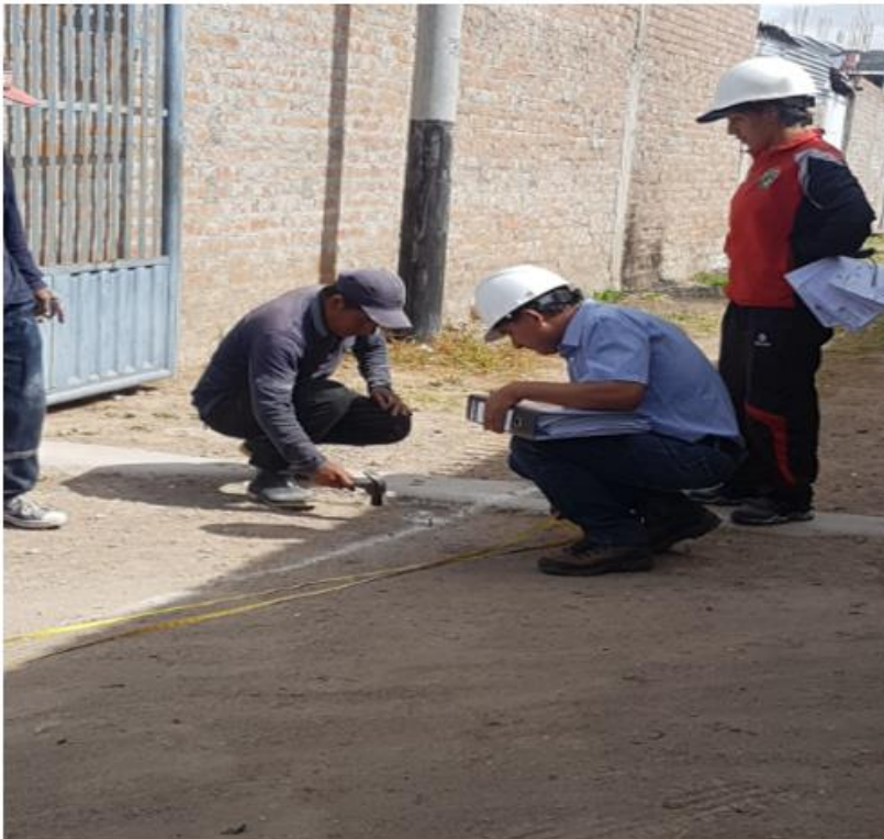
Fotografía 6: Trazo y replanteo de la línea de conducción de red matriz en jr. Angaraes.
