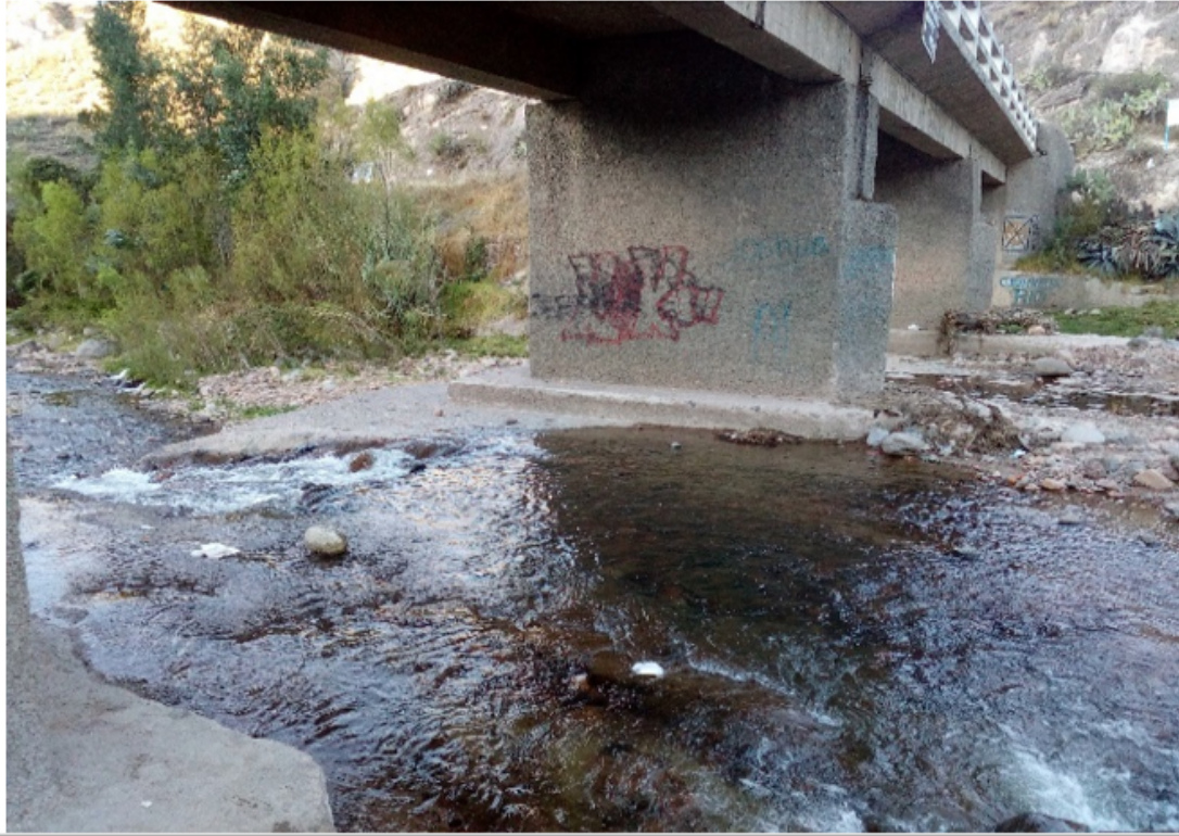
Fotografía 3: Flujo actual en el puente.
