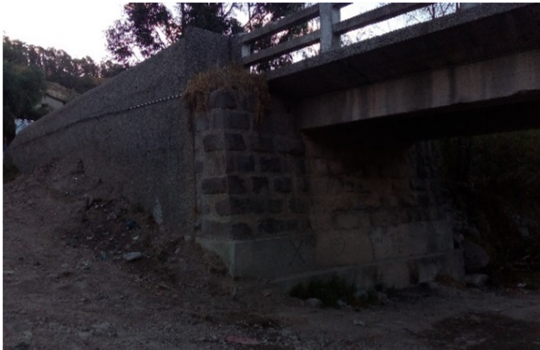
Figura 5.15: Estribo del puente Huatatas.
