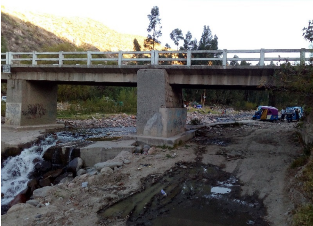
Fotografía 4: Sección del puente.
