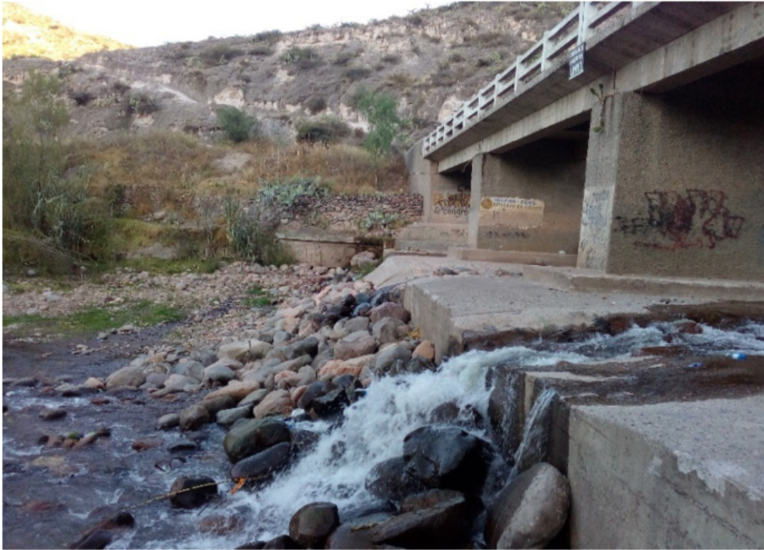
Fotografía 3: Puente Huatatas-lugar Ccachamolino.
