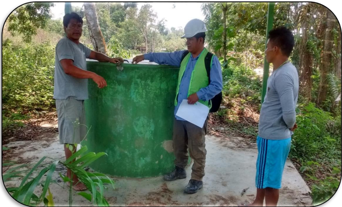
Se Observa, Pozo Artesiano Existente Junto a las Autoridades de la CC. NN de Sana Ana
