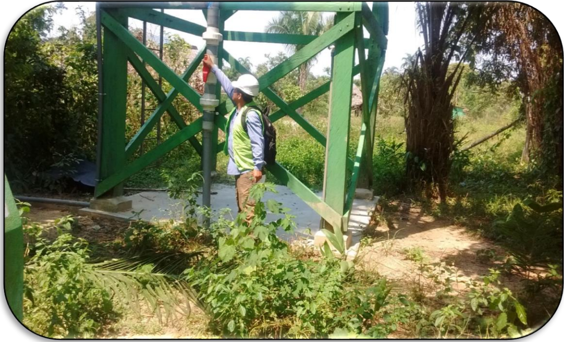
Se Observa, Verificación de la llave de Paso en Tubería de Distribución
