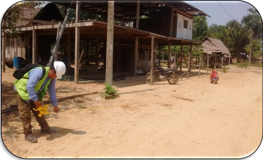
Se Observan los Trabajos de Medición de toda la Red Existente
