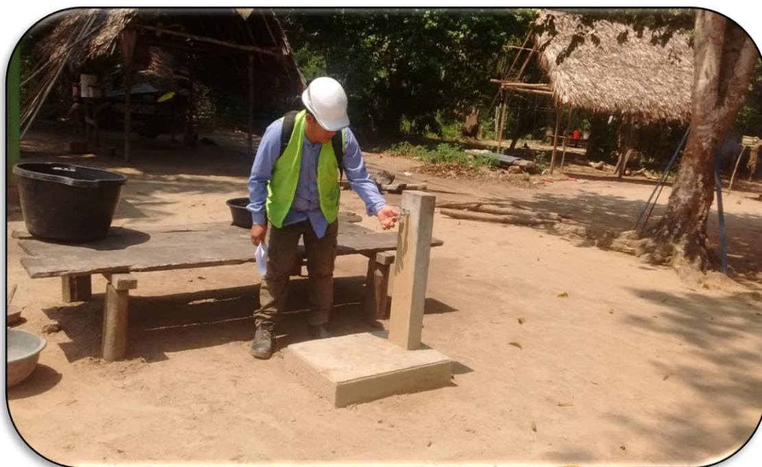
Se Observa la Falta de Agua en las Piletas existentes en la CC.NN. de Santa Ana
