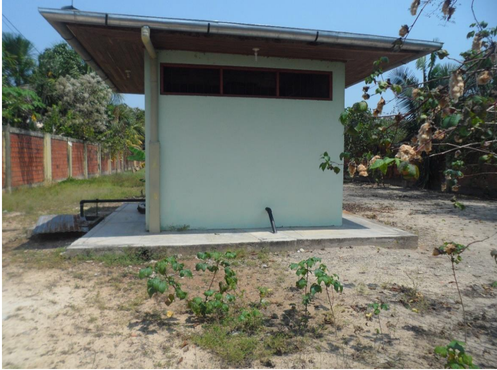
Foto n° 9: Tubo galvanizado de Ø 2"
