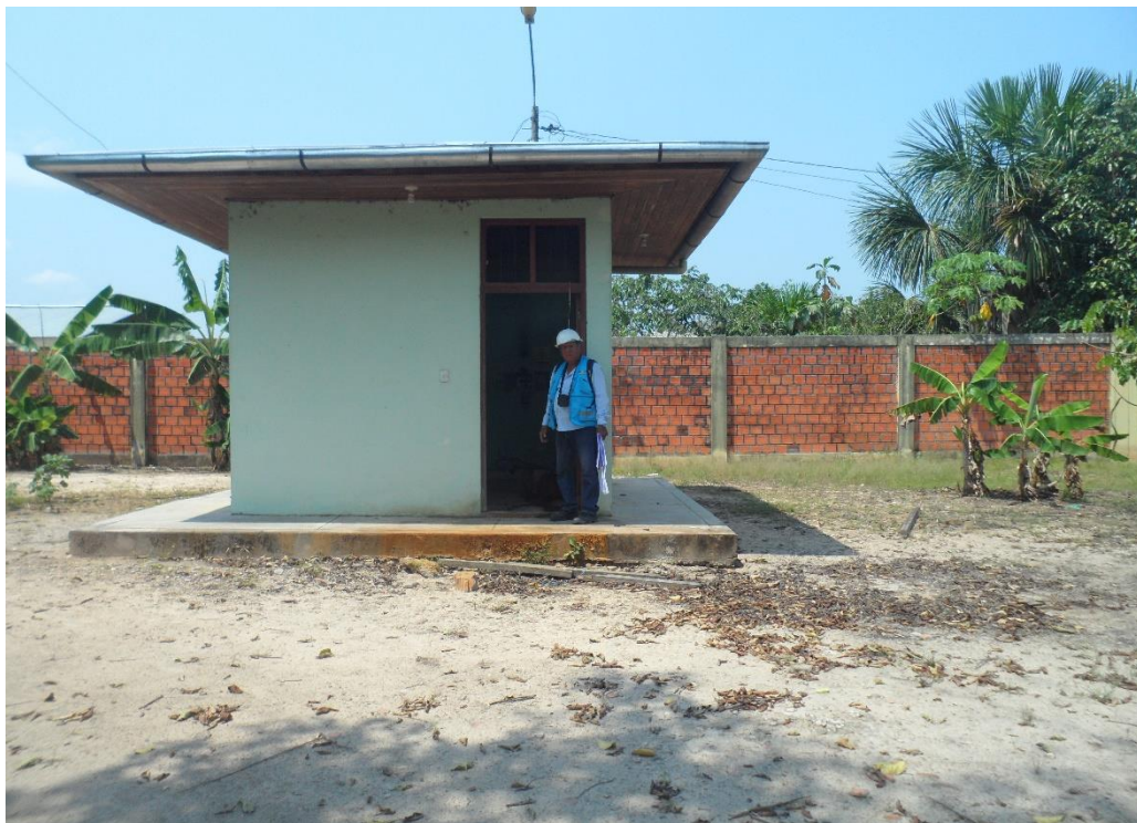
Foto n° 6: Caseta de bombeo
