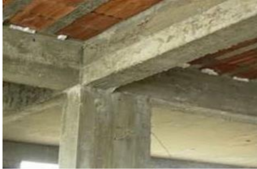
Figura 2: Viga de concreto armado - Fuente: Escalante T.
