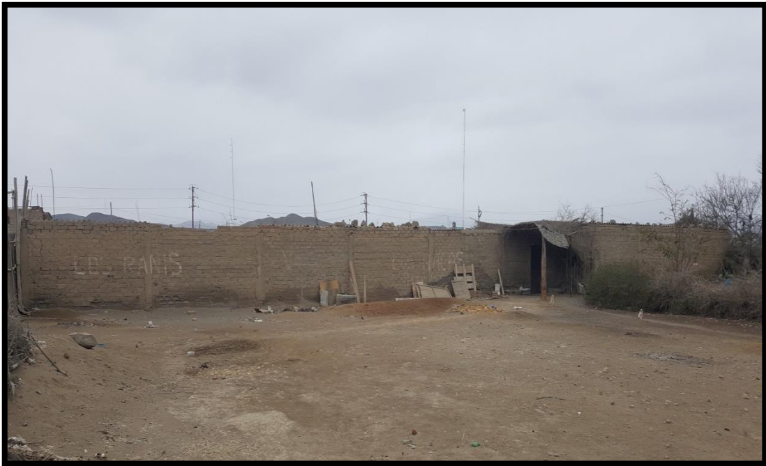
Imagen 3: Lado posterior del almacén del ministerio de transporte y comunicaciones (MTC) Huarney, distrito de Huarney
