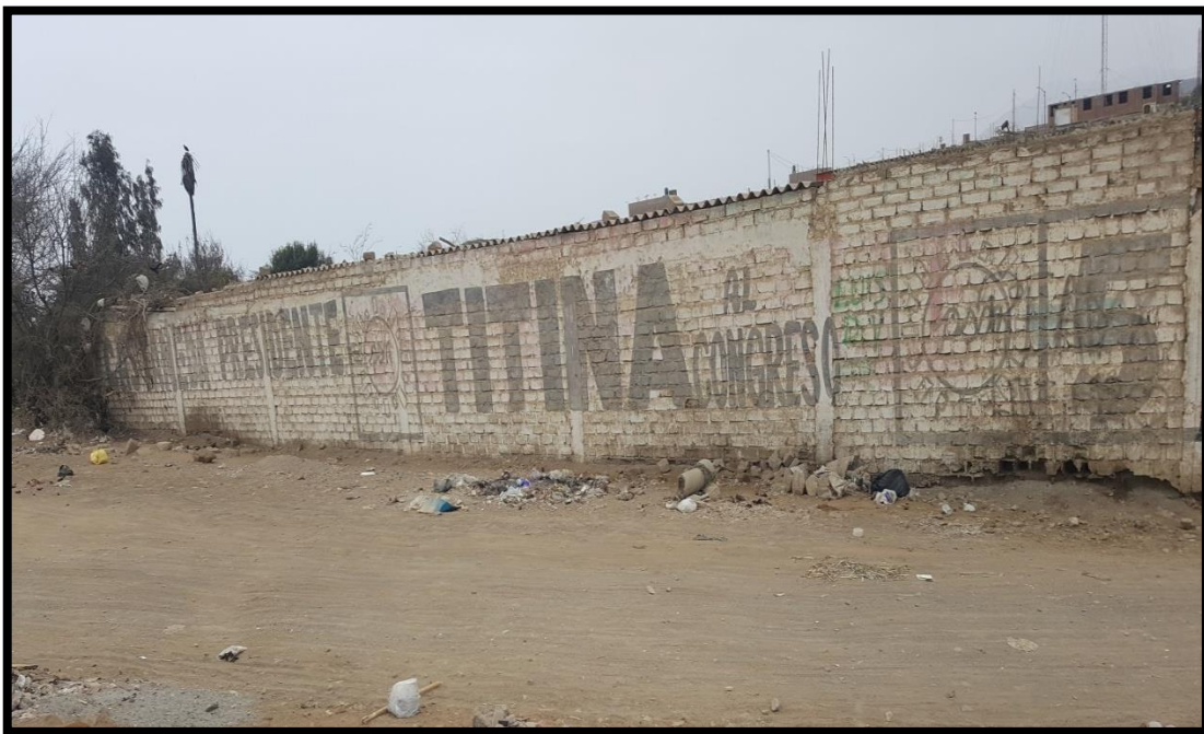
Imagen 2: Lado lateral sur del almacén del ministerio de transporte y comunicaciones (MTC) Huarney, distrito de Huarney
