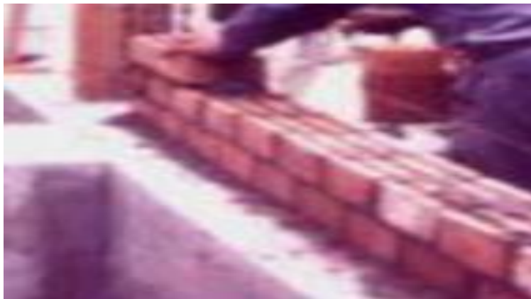
Figura 1: Albañilería.- Fuente: Bartolomé
