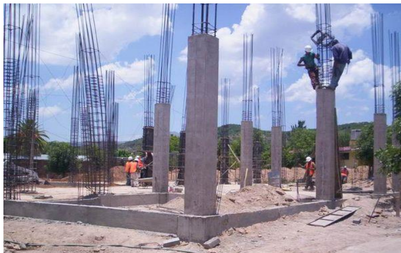
Figura 3: Columna de concreto armado - Fuente: Pagina de Arquys.com
