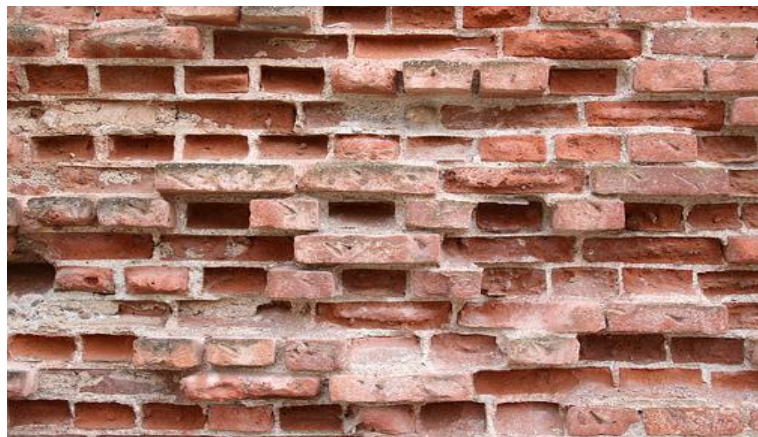
Figura 9: Disgregación en muros – fuente Auto :Hugovk
