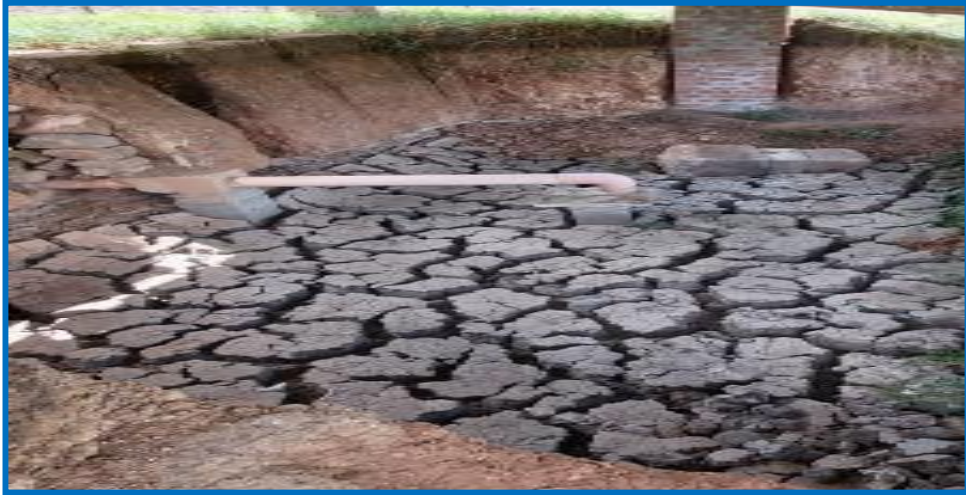
Fotografía N° 04: Lecho de secado
