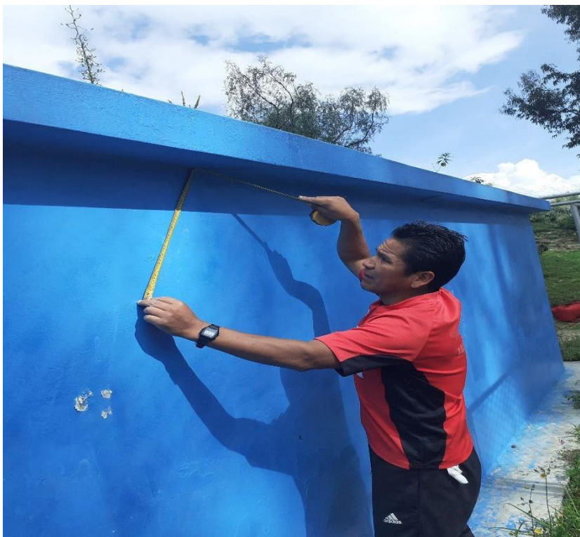
Fotografía N° 05: Midiendo dimensiones de las fisuras del reservorio
