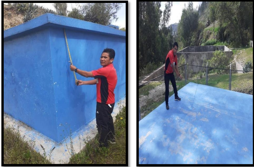
Fotografía N° 13: Vista del reservorio.
