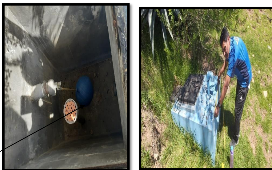
Fotografía18: Vista de estado de la cámara rompe presión.
