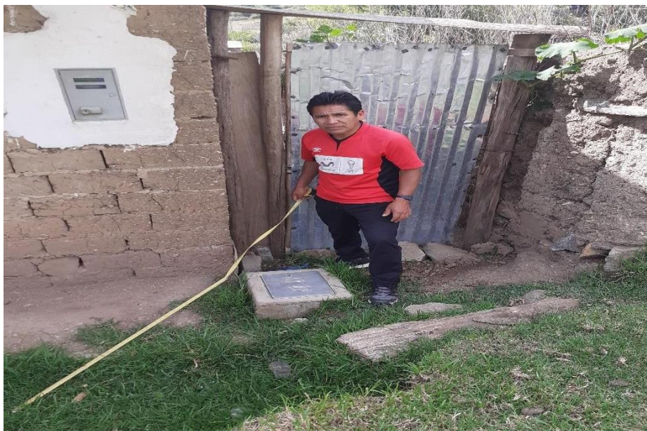
Fotografía N° 07: Verificando conexiones dimidiarías de agua potable
