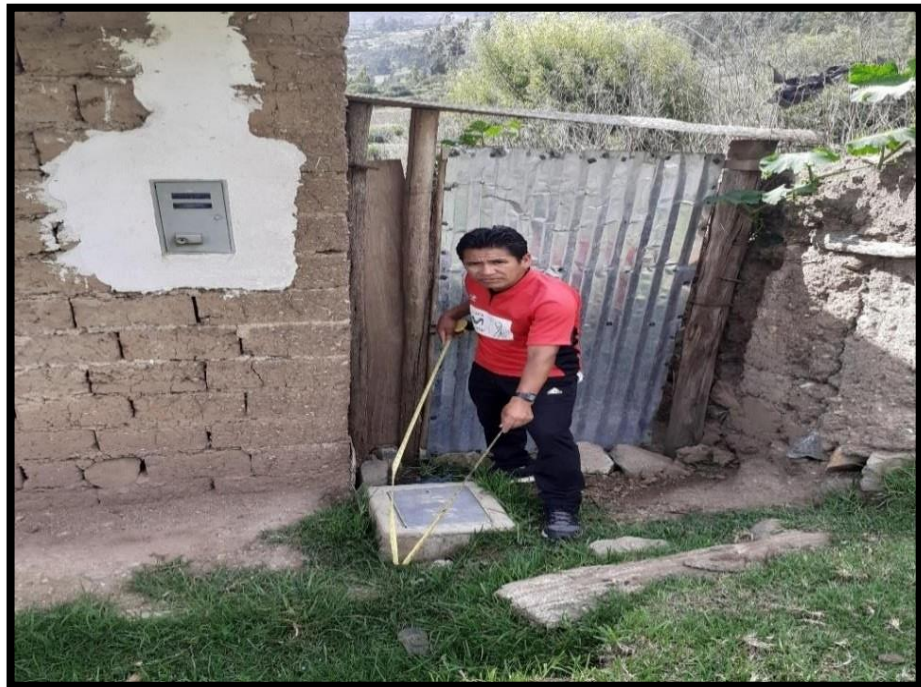
Fotografía N°17: Vista de conexión domiciliaria.
