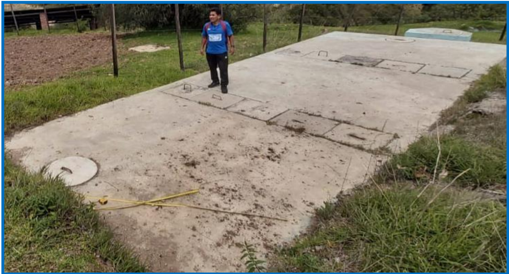
Fotografía N° 02: Tanque Séptico
