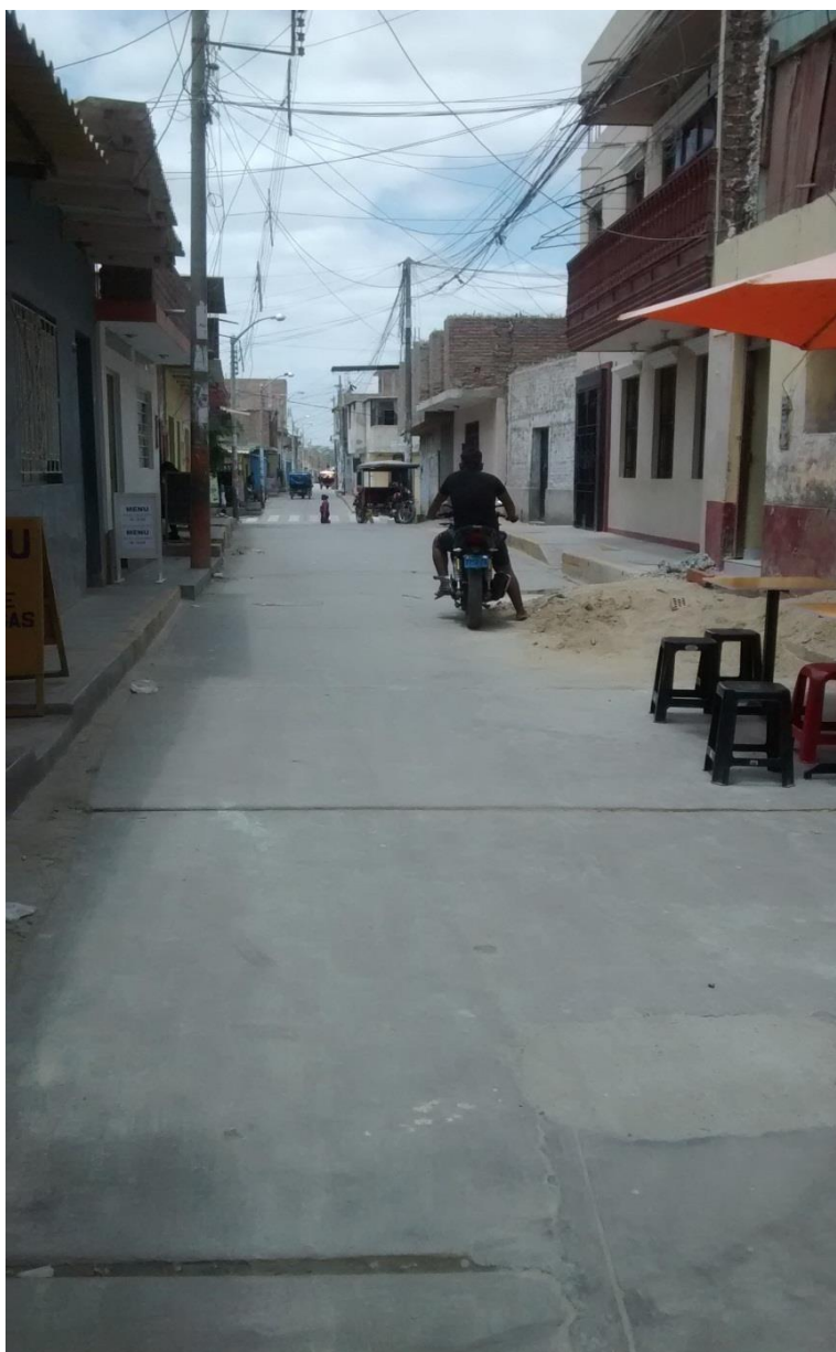
FOTO N°1: Pavimento rígido de la Calle Arequipa
