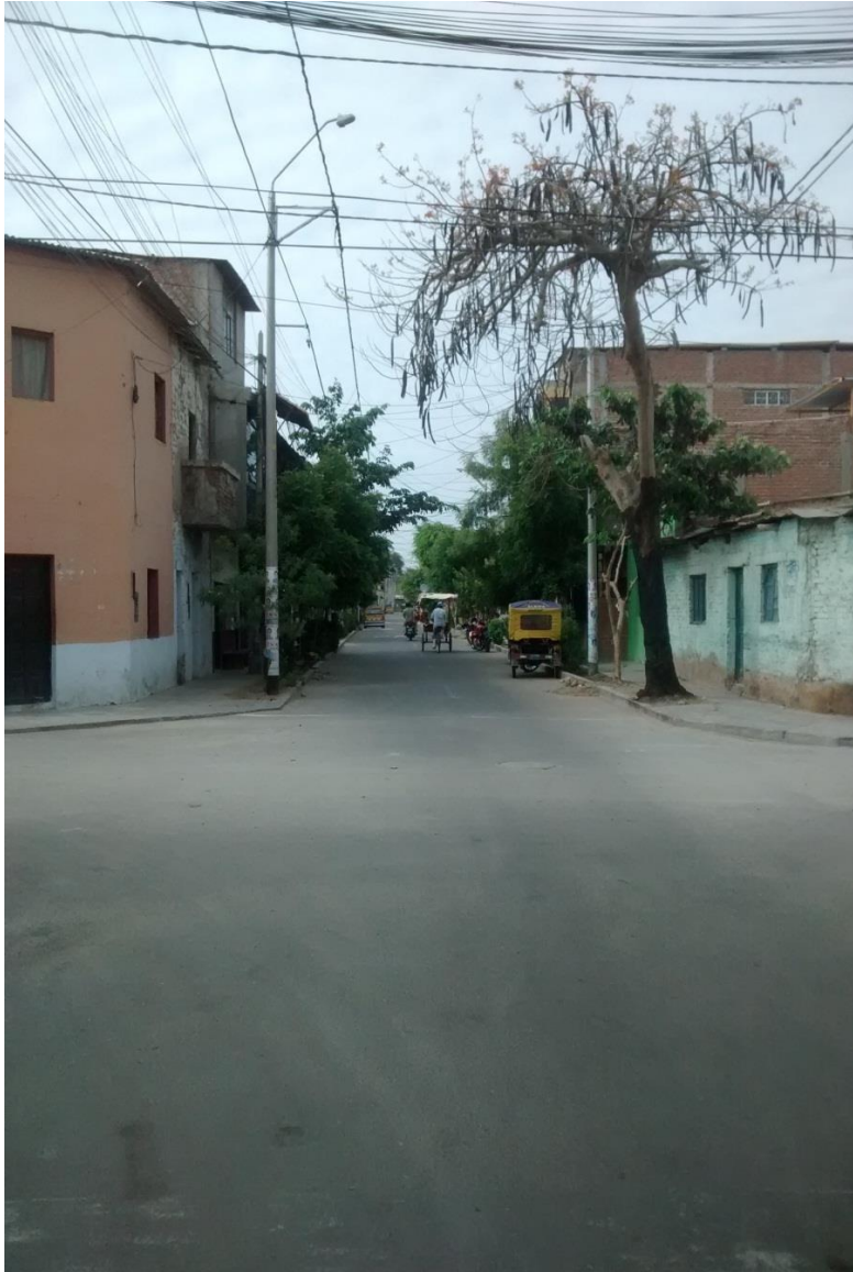
FOTO N°4: Pavimento rígido de la Calle San Francisco
