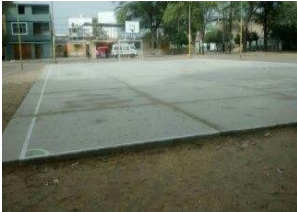
FOTO N°5: Pavimento rígido de la Losa deportiva
