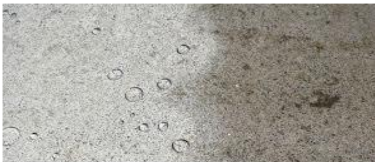
FIGURA N° 02: Pulimento de agregados
