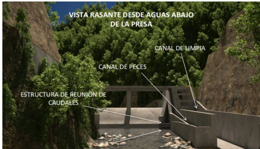
Figura 2.1: Obra de Capatación de Agua.
