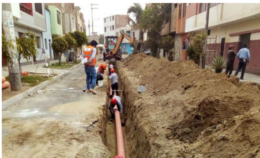
Figura 2.5: Instalación del Alcantarillado.
