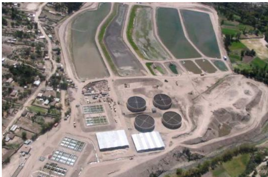
Figura 2.6: Planta de Tratamiento de Totorilla - Ayacucho.
