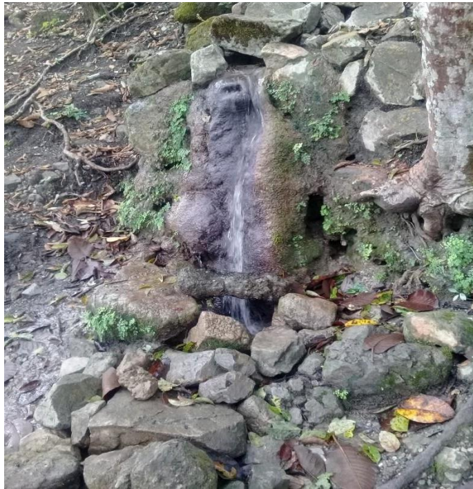
Ilustración 37: Estado actual red de la captación Guzmán 2
