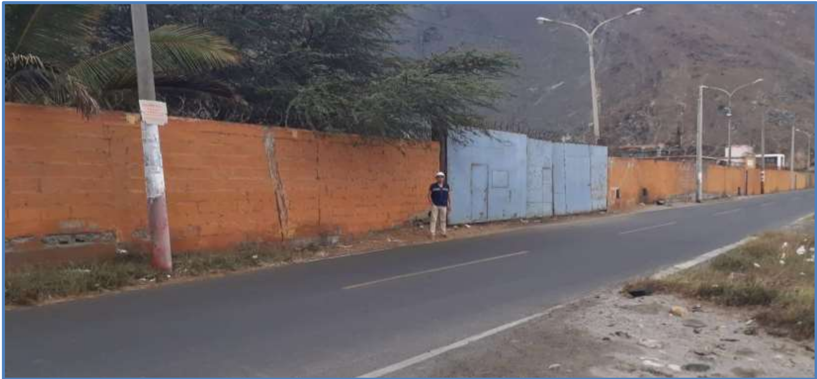
Imagen 1: Vista panorámica de la fachada principal del Depósito Pesquero Exalmar S.A.
