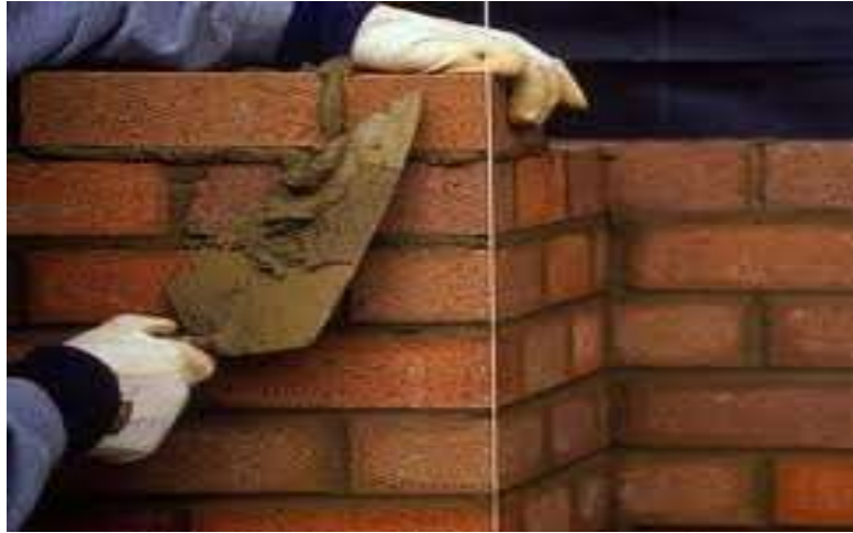
Figura 10: Muro de Albañilería Simple.
