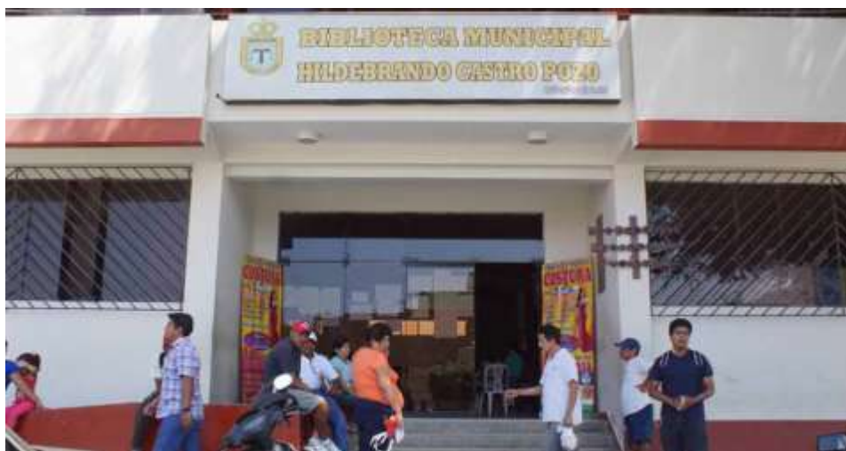
Figura 3: Biblioteca Municipalidad de Marcavelica.
