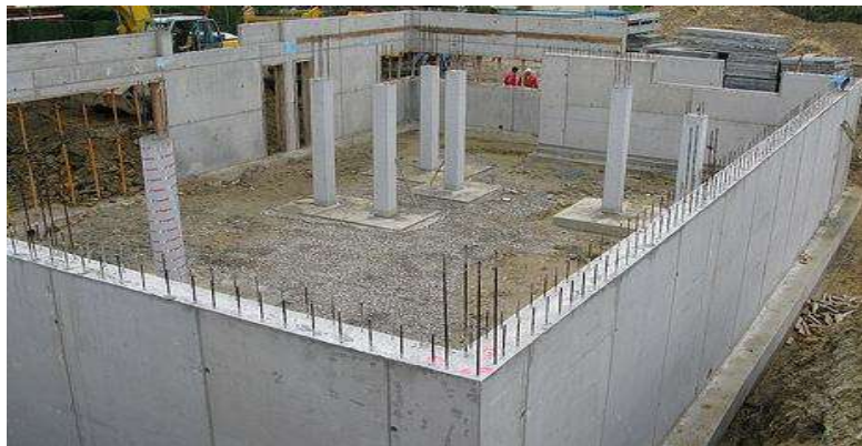
Figura 16: Muro de Concreto Armado.
