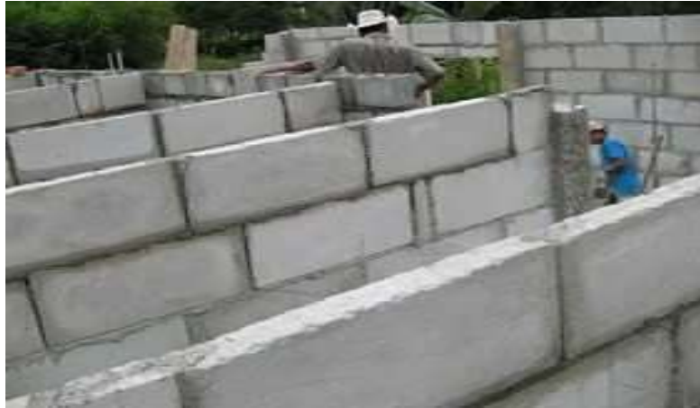
Figura 15: Muro de concreto Simple.
