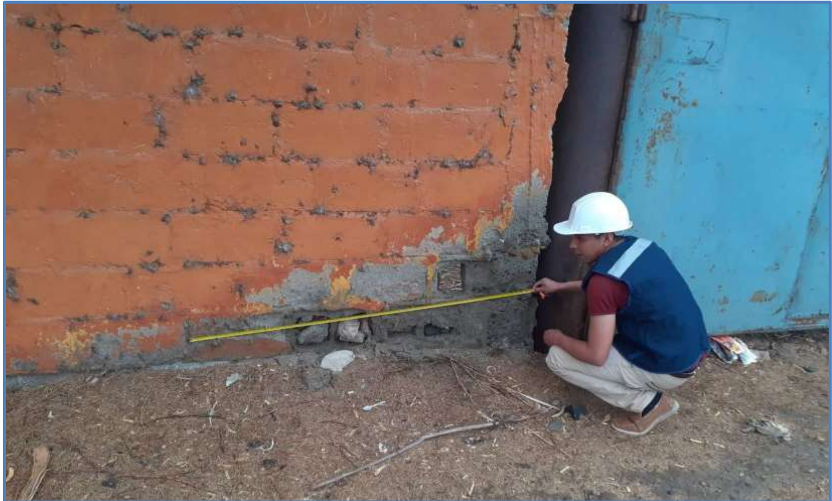
Imagen 2: Patología Erosión presente en el Muro de la Unidad Muestral 03 del Depósito Pesquero Exalmar S.A.
