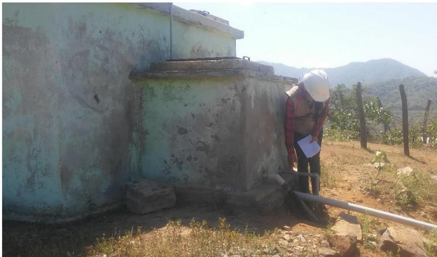
***Fotografía 9: Tubería aducción expuesta a rotura***
