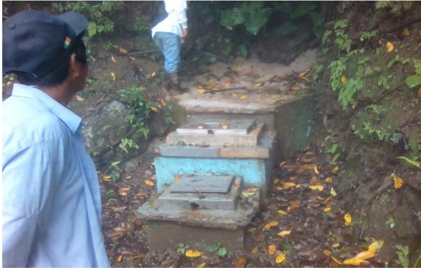
***Fotografía 6: Línea de conducción expuesta***
