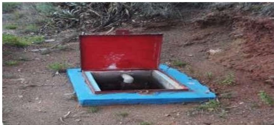
En cuanto al área externa de la cámara rompe presión tipo 6 se observa que esta se encuentra en condiciones regulares y mantenido no presenta muchas patologías, para mantener la estructura en condiciones buenas debe hacerse el cerco perimétrico, y pequeños resanes al exterior de la cámara rompe presión.
