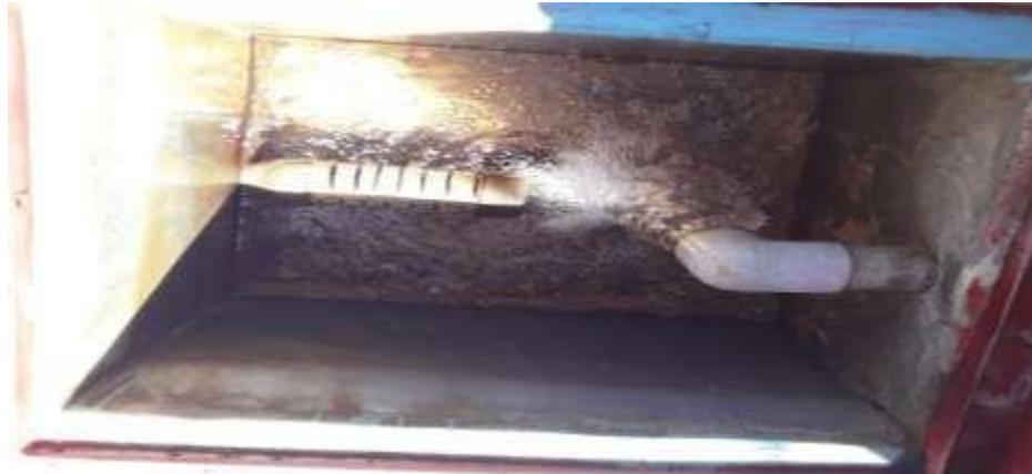
Se observa en la fotografía que el interior de la cámara rompe presión tipo 6 se encuentra sucia de una serie de partículas que contaminan las aguas lo mínimo que se propone es mantener limpio las paredes de la estructura.
