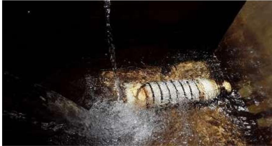
Se observa en la fotografía que el interior de la cámara rompe presión tipo 6 se encuentra sucia y a su vez impregnada de una serie de partículas que contaminan las aguas recolectadas.
