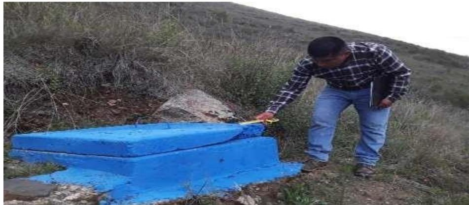
En la fotografía se observa que la cámara rompe presión tipo 6 se encuentra fracturada por la caída de rocas, lo cual supone que este tipo de deslizamientos se producen en la temporada de lluvias.
