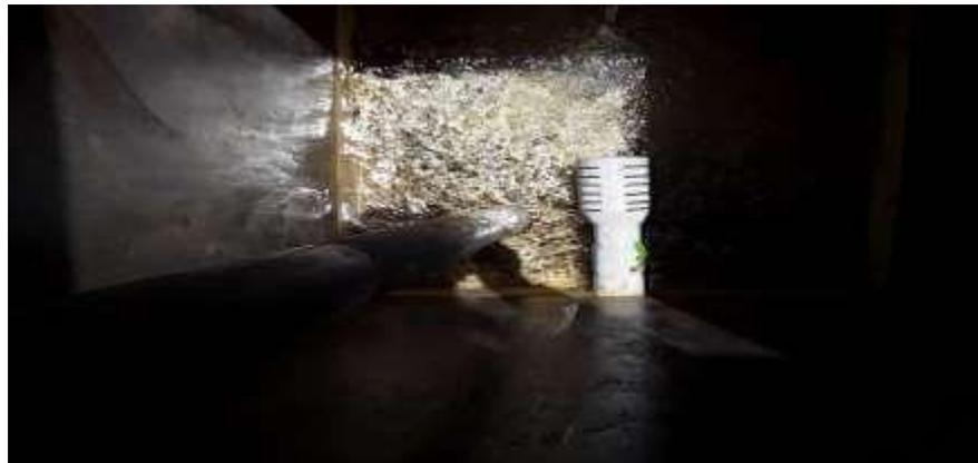
Se observa que la parte interior de la captación 1 se encuentra sucia debido a que no se está realizando la limpieza adecuado durante el año 2019.
