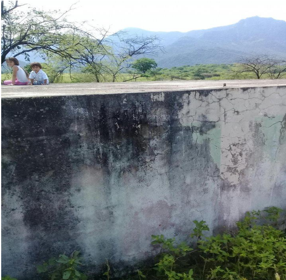
Gráfico 6: reservorio apoyado en el caserío El Carrizo, Tambogrande
