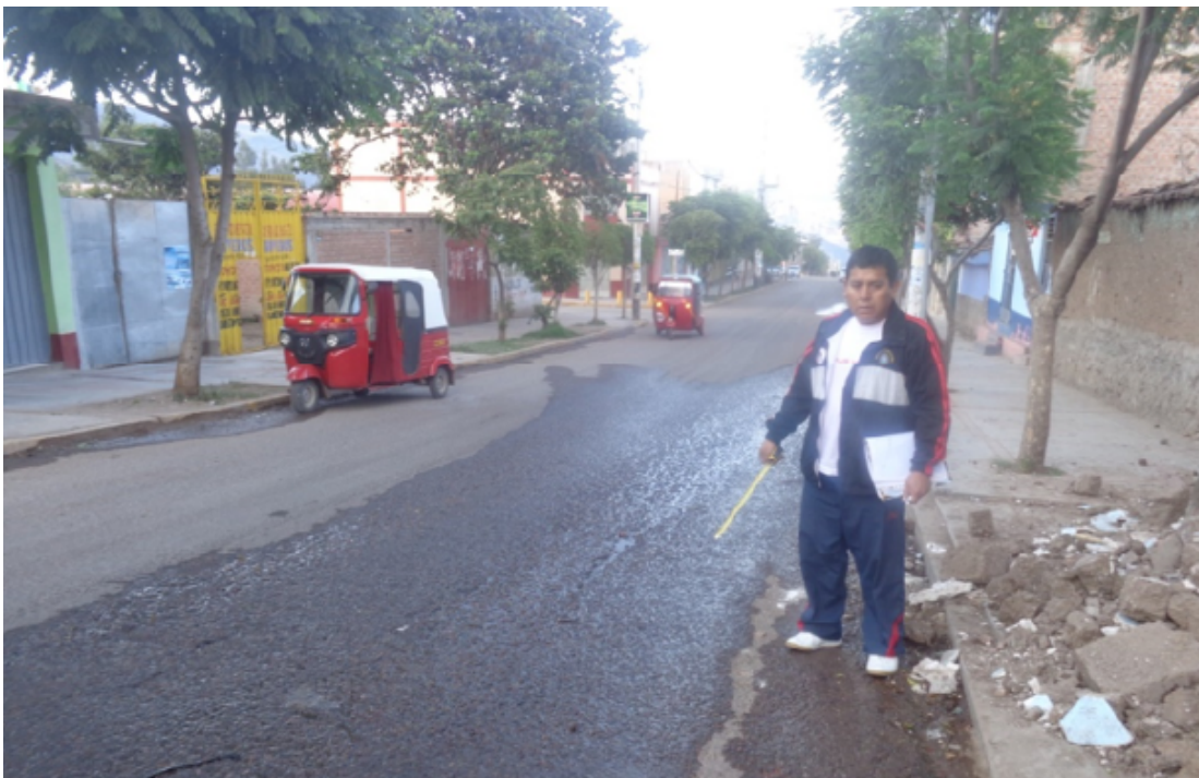
Fotografía 4: Patologías encontradas en la muestra.
