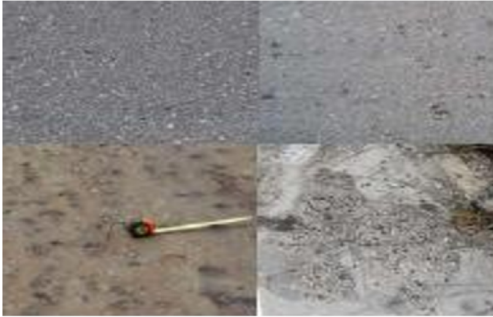
Figura 2.13: Perdida de áridos. Fuente:(Cálculo del ICP av. Luis Montero)
