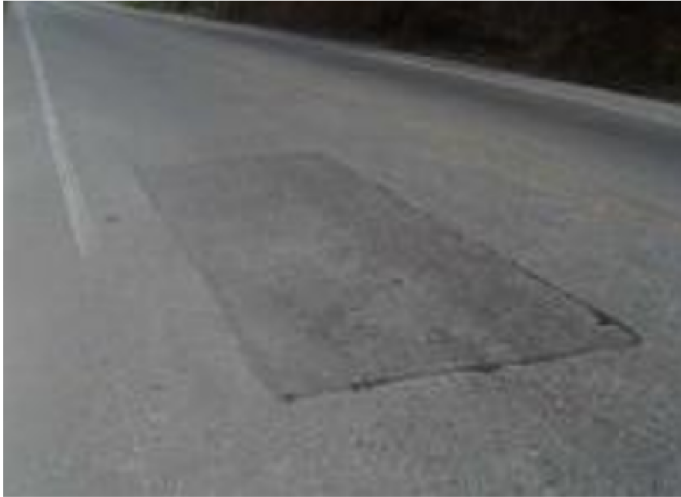
Figura 2.7: Parches deteriorados.
