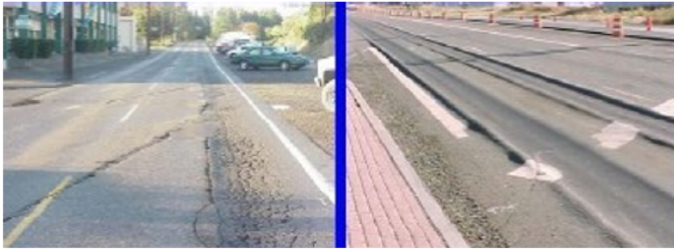
Figura 2.9: Ahuellamientos.
