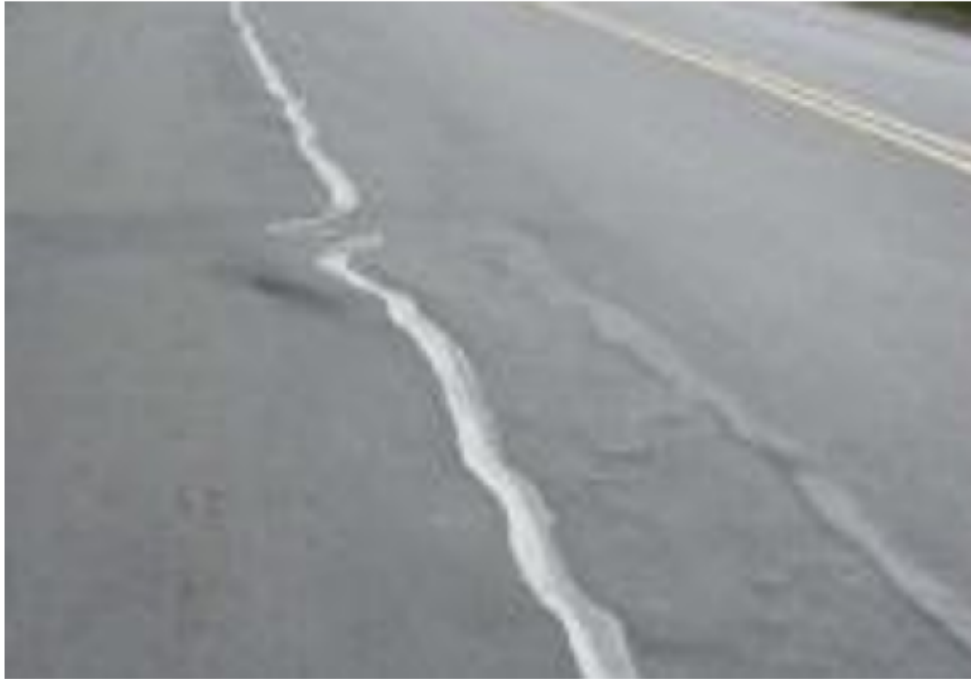
Figura 2.14: Descenso de la berma.
