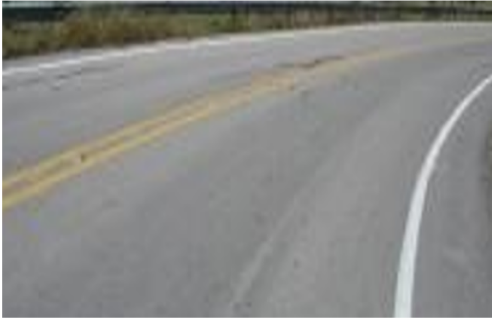
Figura 2.12: Desgaste.
