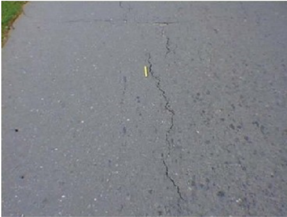
Figura 2.5: Fisuras y grietas longitudinales y transversales. Fuente: (Cálculo del ICP av. Luis Montero)
