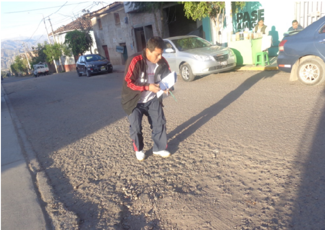
Fotografía 6: Patologías encontradas en la muestra.
