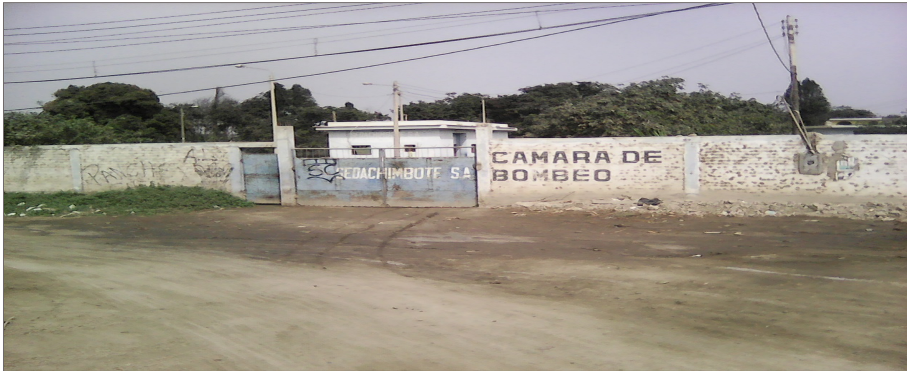
Fotografía 01: Vista Panorámica del exterior del cerco perimétrico de la caseta de bombeo 01 de SedaChimbote del distrito de Huarmey, provincia de Huarmey, región Áncash.
