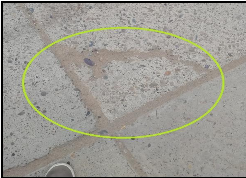
Figura 113: Descascaramiento de Junta UM-01.
