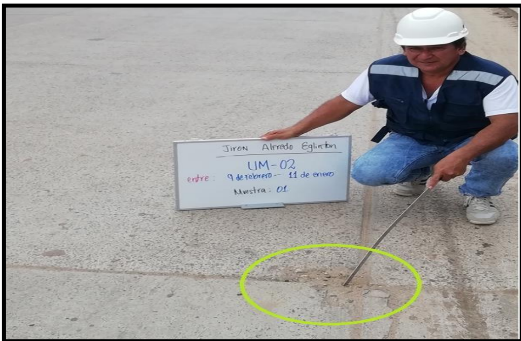
Figura 116: Descascaramiento de Esquina UM-02.
